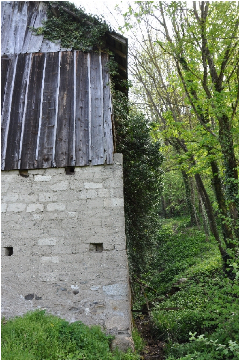
Vue de la façade ouest avec en perspective le passage de l'eau
