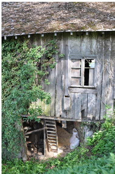
Détail de la façade sud Phot. Yannick Milleret IVR82_20127301610NUCA
