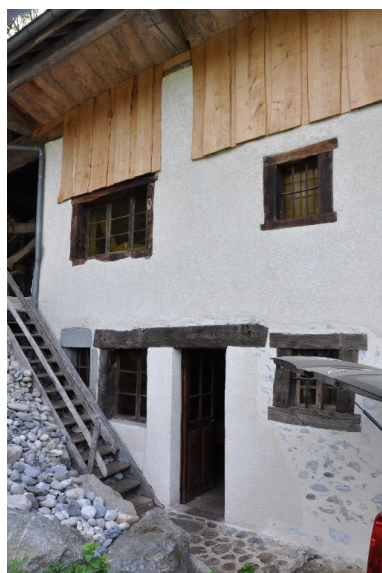
Entrée du moulin, vue nord Phot. Yannick Milleret IVR82_20127301607NUCA
