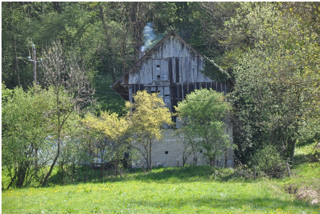
Vue du moulin à huile et de la scierie depuis la route départementale 49, vue ouest
