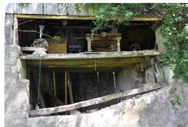
Détail de la façade sud Phot. Yannick Milleret IVR82_20127301611NUCA
