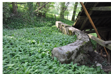
Vue du mur de soutènement de la retenue d'eau Phot. Yannick Milleret IVR82_20127301614NUCA
