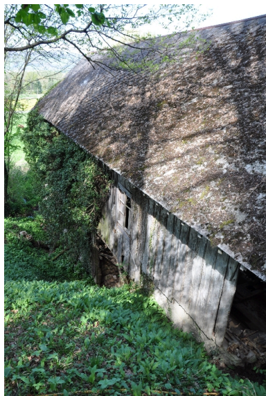
Vue sud du bâtiment, l'eau passait le long de cette façade Phot. Yannick Milleret IVR82_20127301609NUCA
