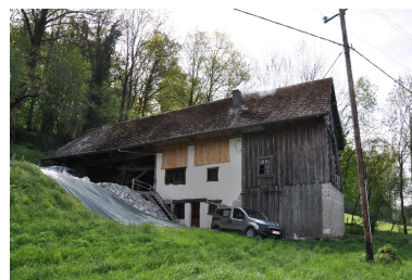
Vue générale du moulin à huile et de la scierie, vue nord Phot. Yannick Milleret IVR82_20127301605NUCA
