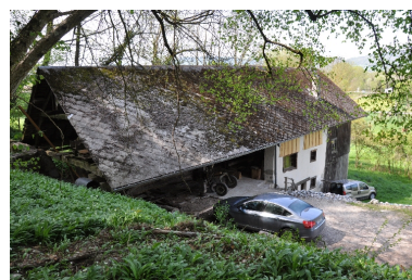
Vue est des bâtiments, au premier plan la scierie Phot. Yannick Milleret IVR82_20127301608NUCA
