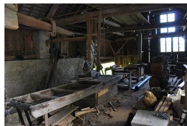
Vue de la scie circulaire Phot. Yannick Milleret IVR82_20127301620NUCA
