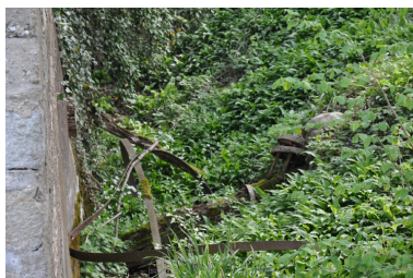
Vestiges de la roue verticale sur la façade sud Phot. Yannick Milleret IVR82_20127301613NUCA
