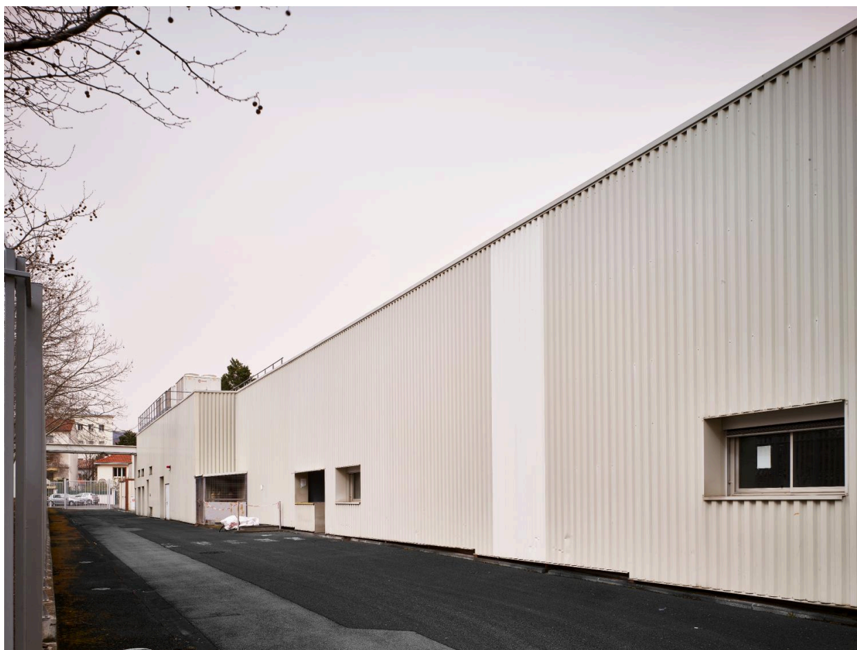
L'élévation sud des ateliers O9 (état 2022).
