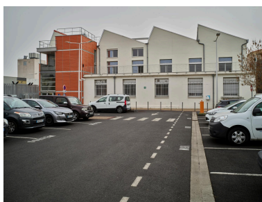
Élévations ouest des bâtiments B7 (à gauche) et B8 (à droite), depuis le parking des Trois Ponts (état 2022). Phot. Christian Parisey IVR84_20226301455NUC4A
