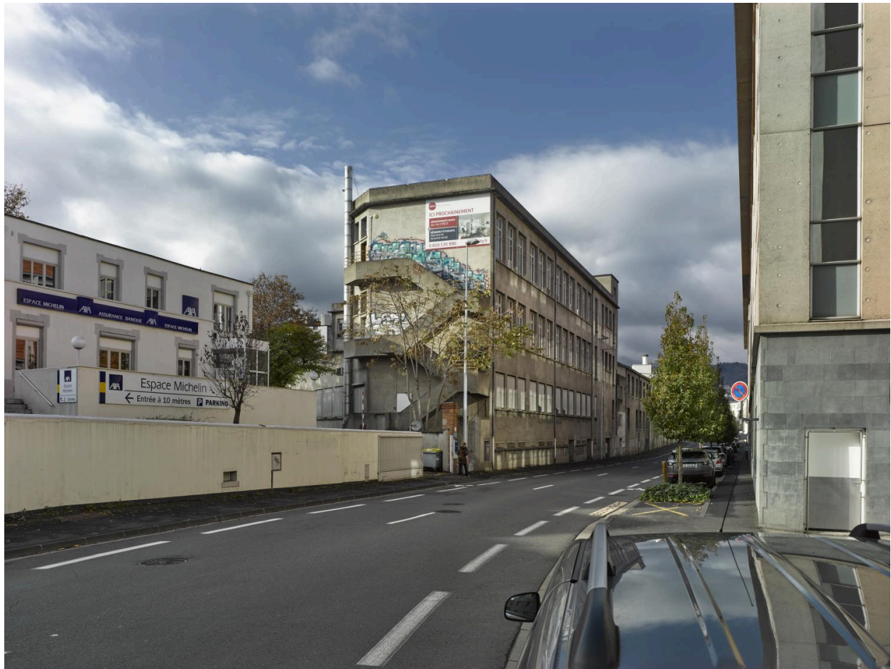
Côté sud de la rue Henri-Barbusse depuis la place des Carmes : état 2018 avant les grandes transformations de 2019-2020. Au centre, l'ancien bâtiment S9, démoli depuis.
