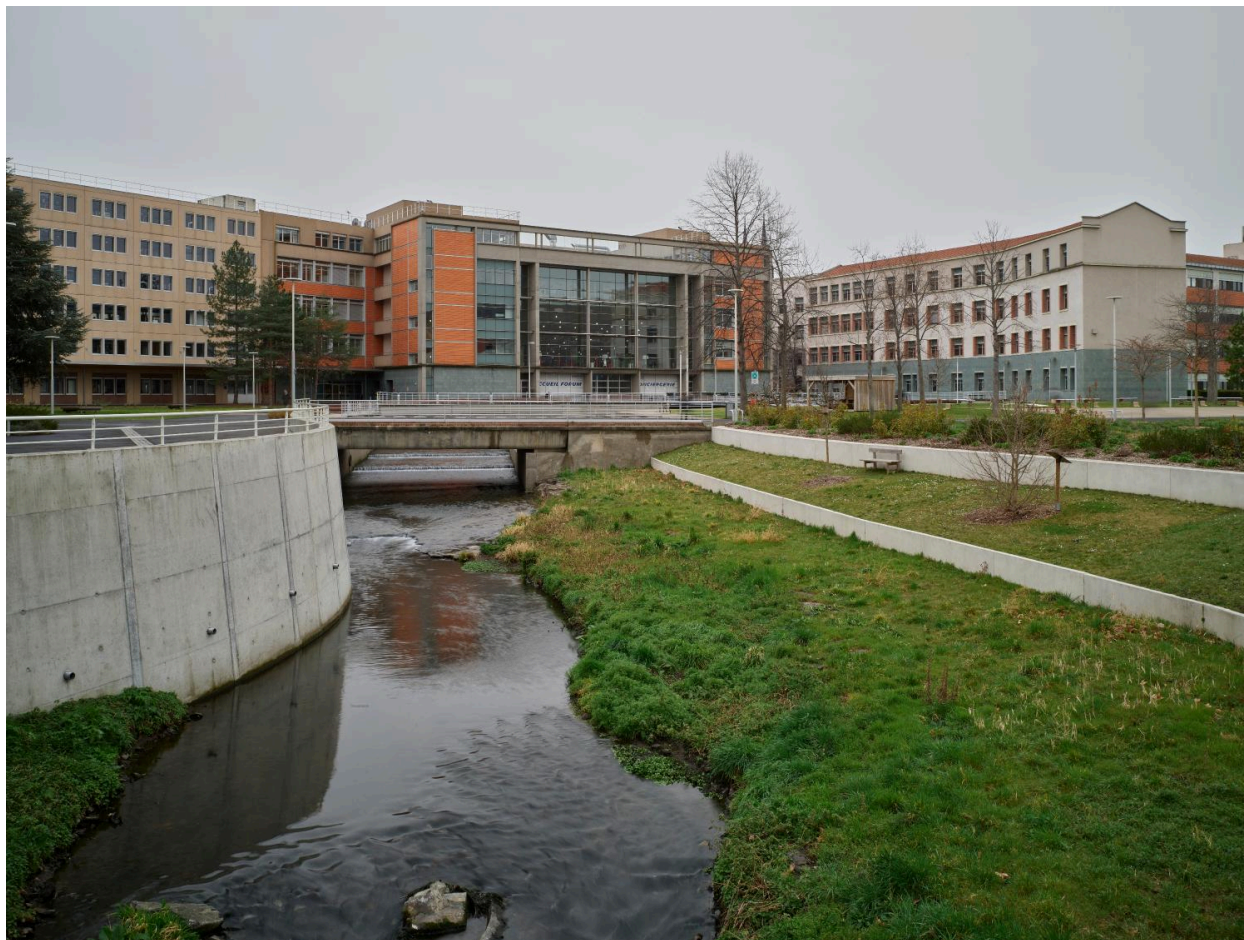
Vue générale des bâtiments A7, A14 et A1 depuis les bords de la Tiretaine (état 2022).
