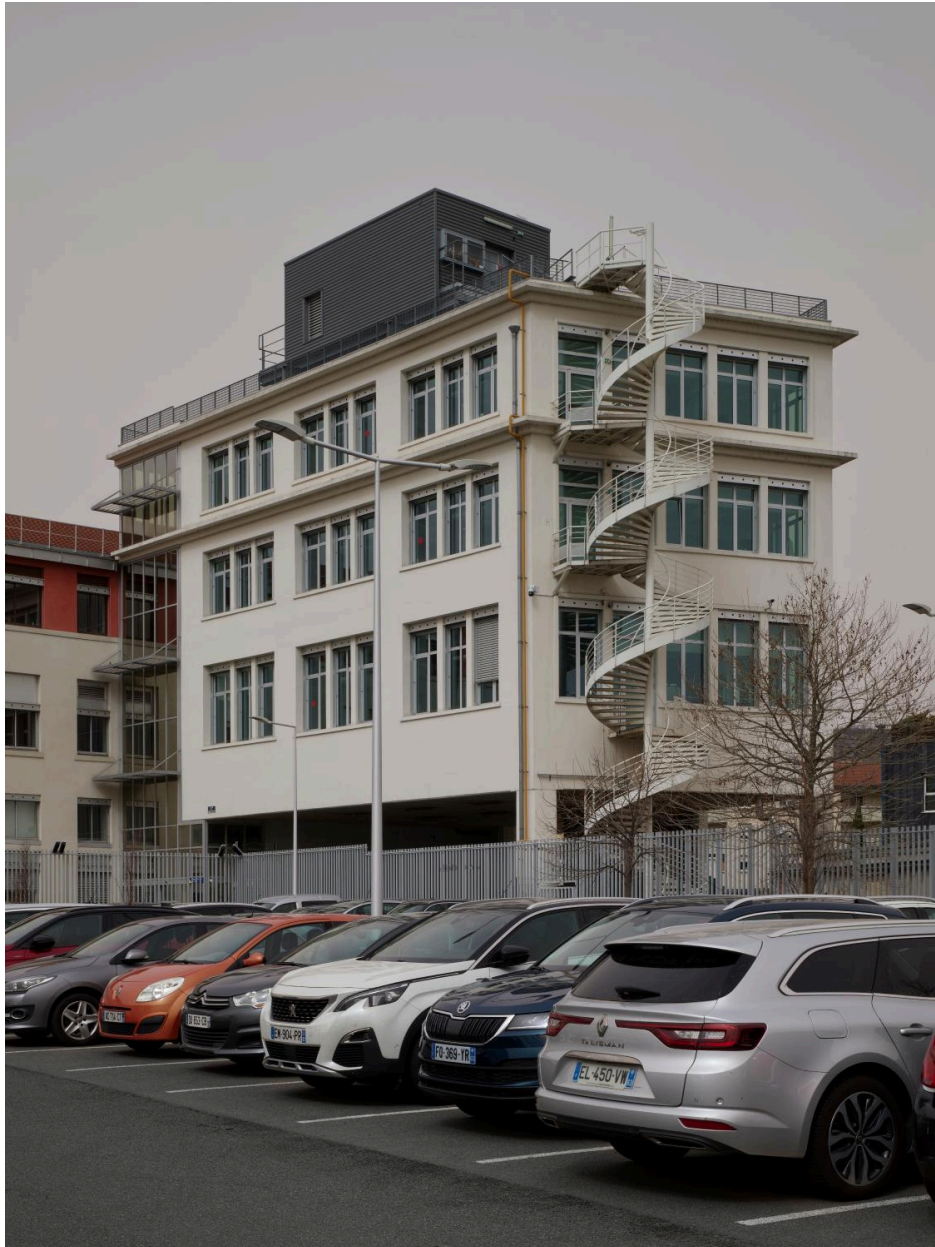
Le bâtiment O14, à l'extrémité nord du site (état 2022).
