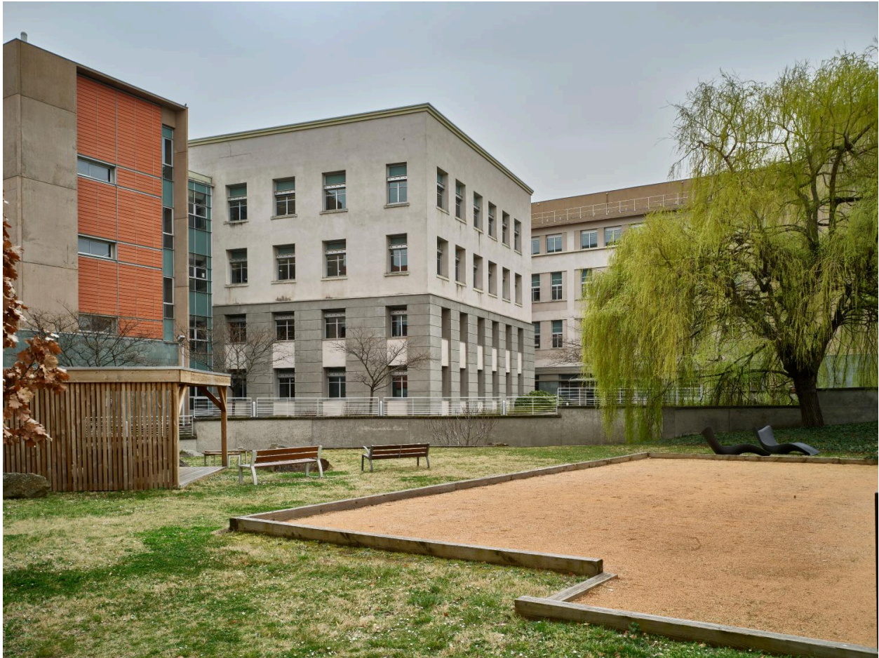
Le bâtiment S13 vu depuis le nord-ouest (état 2022). A l'arrière-plan, une partie du bâtiment F12.
