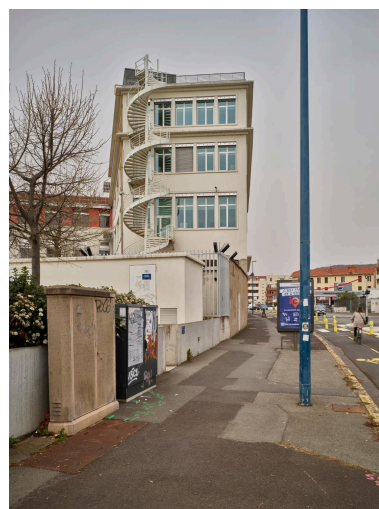
Élévation est du bâtiment O14 et son escalier de secours (état 2022). Phot. Christian Parisey IVR84_20226301453NUC4A
