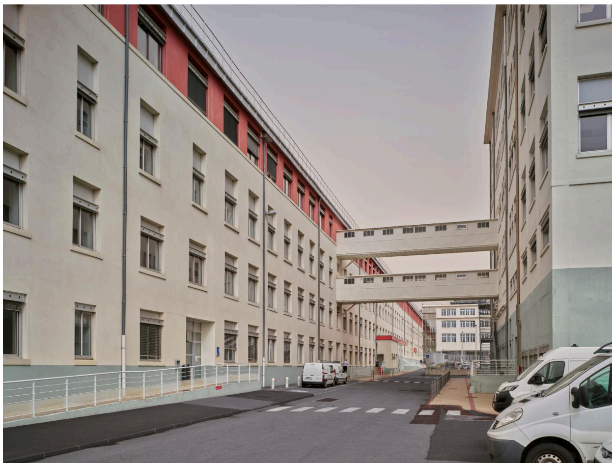
Passage entre les bâtiment O10 et O12, reliés par deux passerelles aux étages supérieurs (état 2022).
