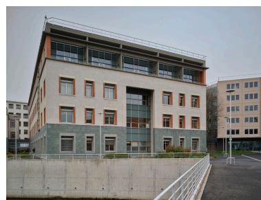
L'élévation ouest du bâtiment T1 (état 2022). Au second plan à droite, le bâtiment A7, prolongé lors de la dernière campagne de travaux.
