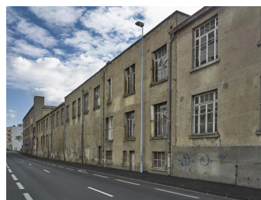
Anciens bâtiments Michelin S9, S18 et S21 du côté sud de la rue Henri-Barbusse : état 2018, avant les démolitions de 2019.
