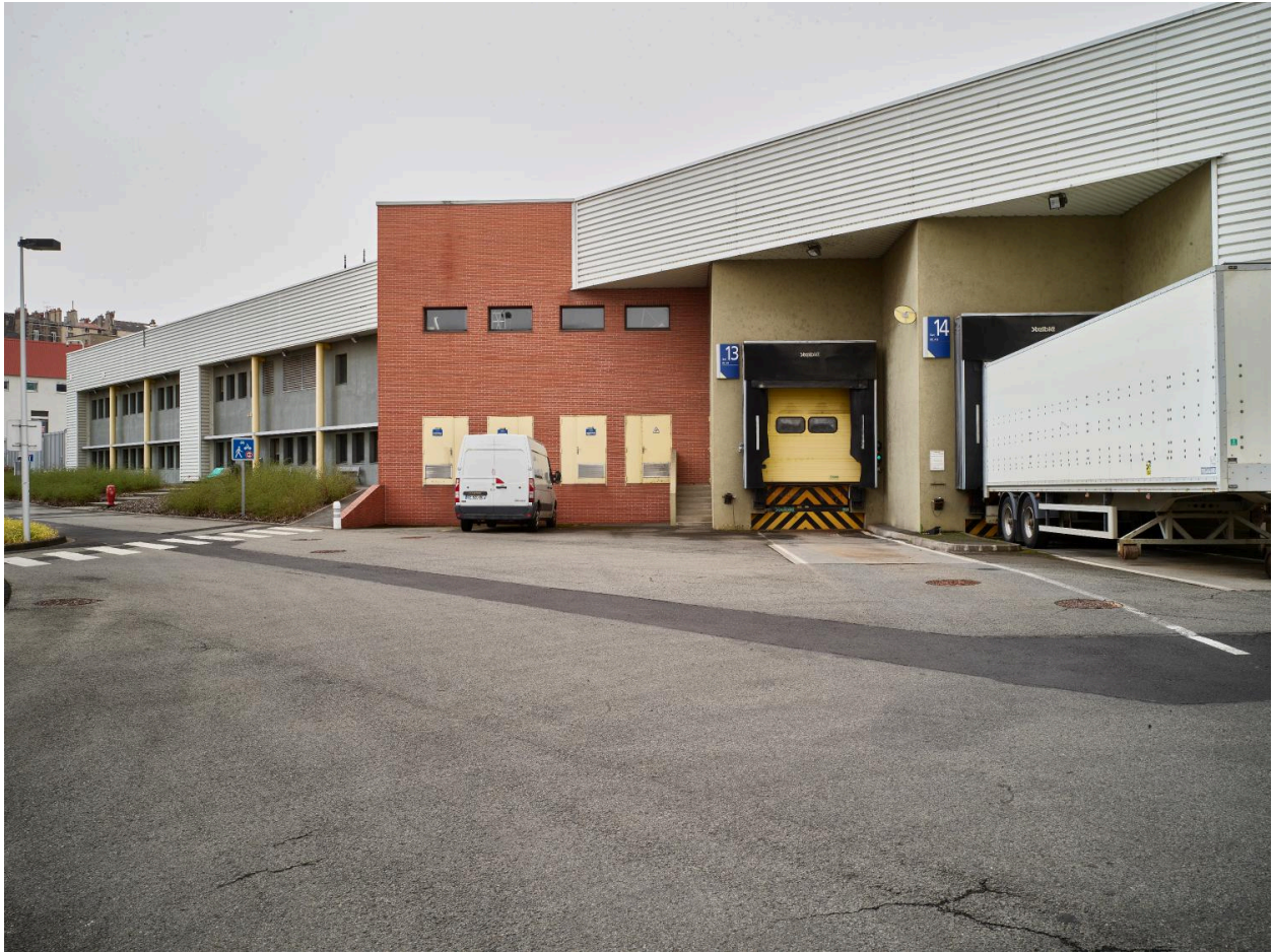
Le bâtiment A13 depuis le nord-est (état 2022).
