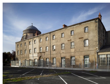
Bâtiment S24 de "la Mission" (état 2022), école Michelin installée dans l'ancien couvent des Carmes-Déchaux et accolé à la chapelle de celui-ci : vue du nord-est.
