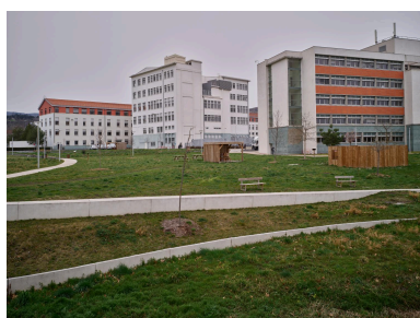
De gauche à droite : l'extrémité sud du bâtiment O10, le bâtiment O12 et une partie du bâtiment A17 (état 2022). Phot. Christian Parisey IVR84_20226301421NUC4A
