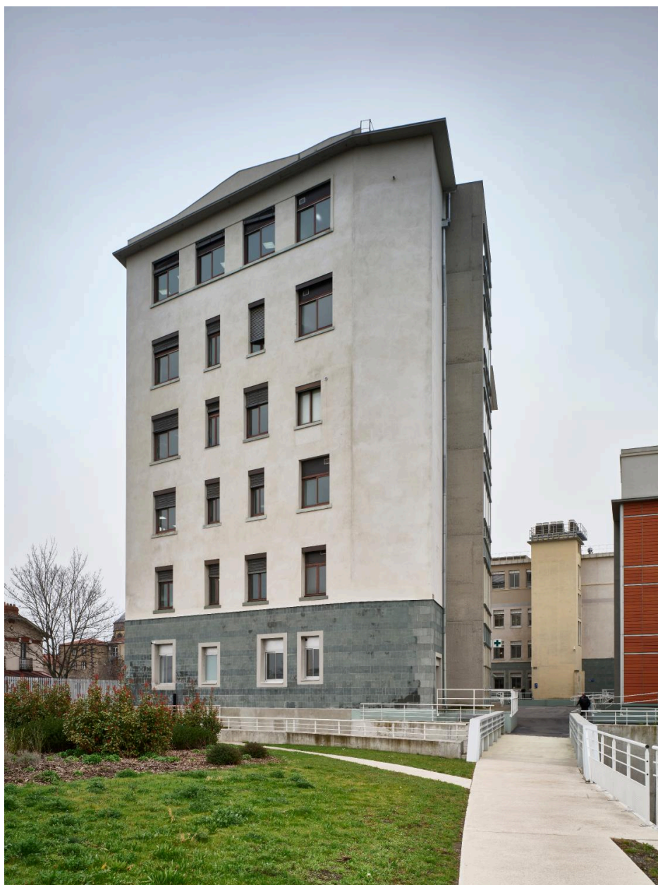
L'élévation nord du bâtiment T15 (état 2022).
