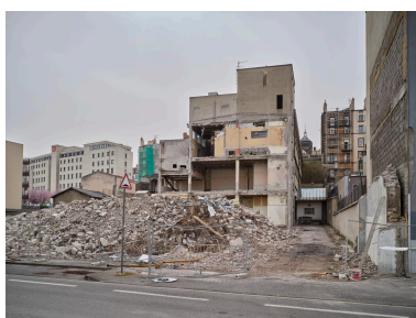
Démolition, en mars 2022, du bâtiment de l'ancien restaurant d'entreprise S47, du côté sud de la rue Henri-Barbusse.
