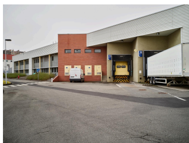
Le bâtiment A13 depuis le nord-est (état 2022). Phot. Christian Parisey IVR84_20226301433NUC4A
