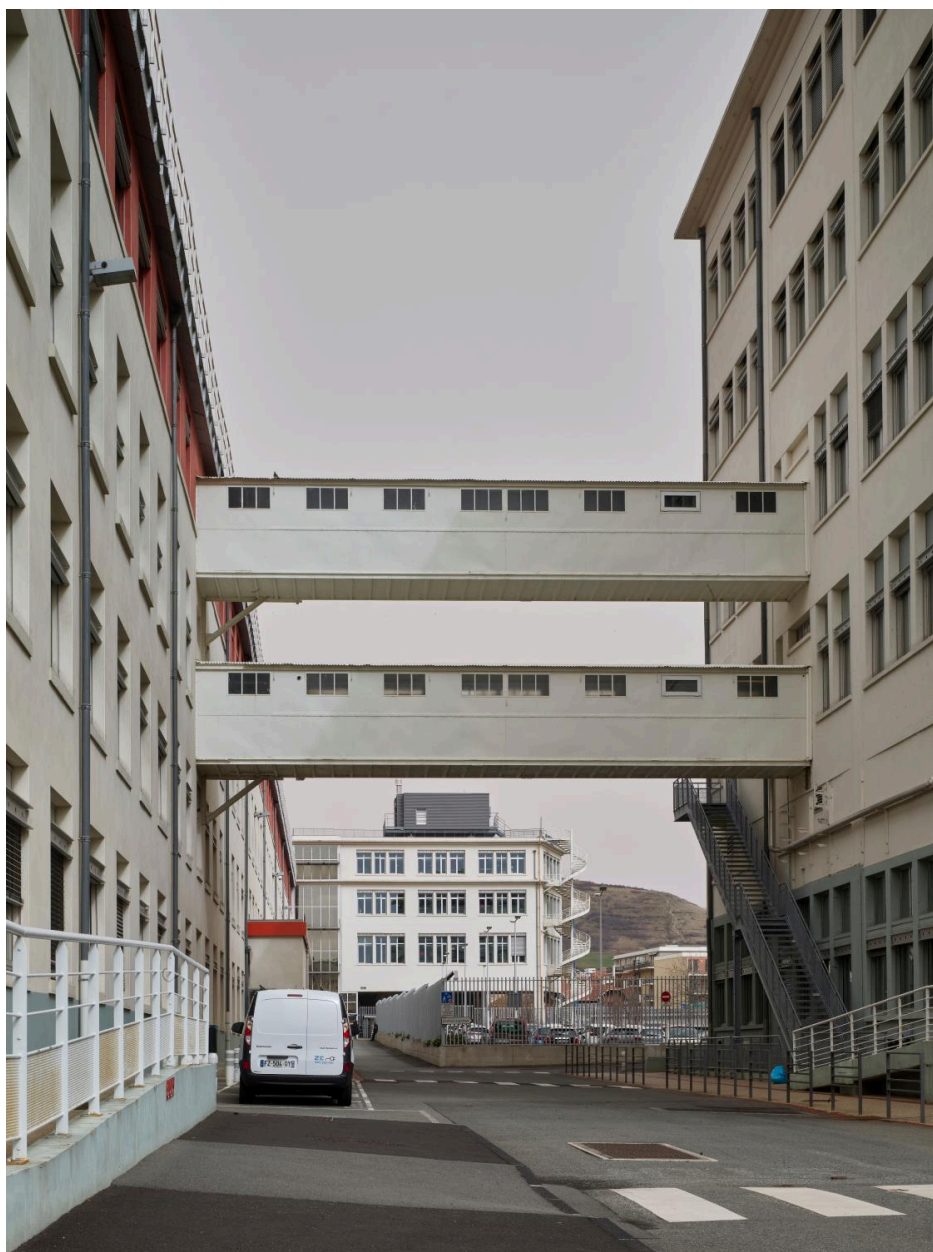
Passerelles entre les bâtiments O10 et O12 (état 2022). En fond de perspective, le bâtiment O14.
