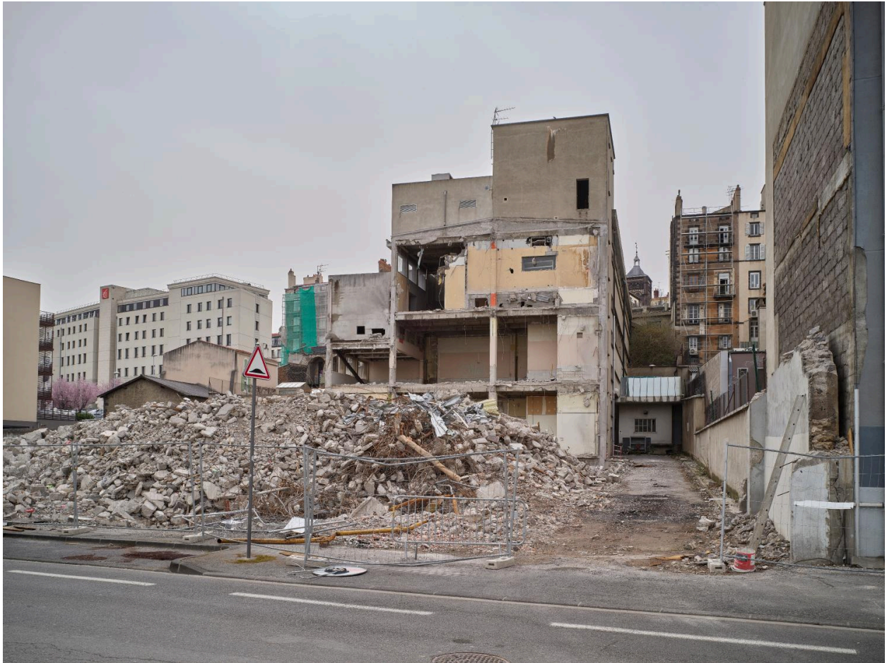
Démolition, en mars 2022, du bâtiment de l'ancien restaurant d'entreprise S47, du côté sud de la rue Henri-Barbusse.
