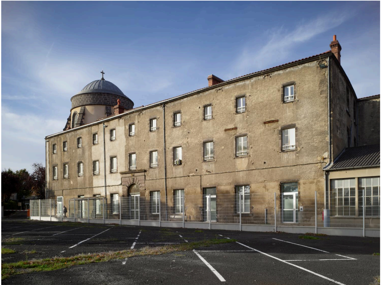
Bâtiment S24 de "la Mission" (état 2022), école Michelin installée dans l'ancien couvent des Carmes-Déchaux et accolé à la chapelle de celui-ci : vue du nord-est.
