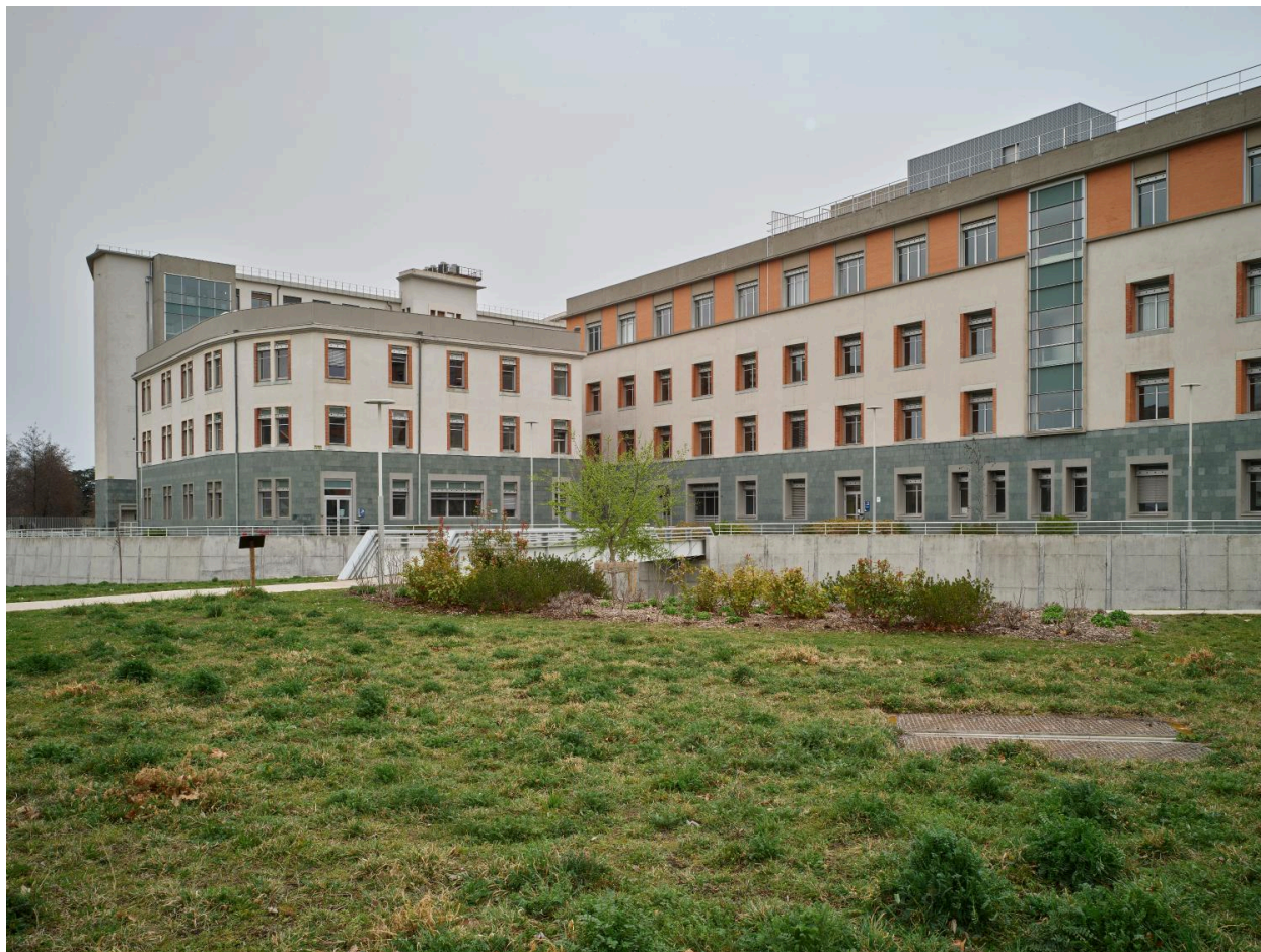
Les bâtiments T2 (à gauche) et T1 (à droite) vus depuis le nord-ouest (état 2022).
