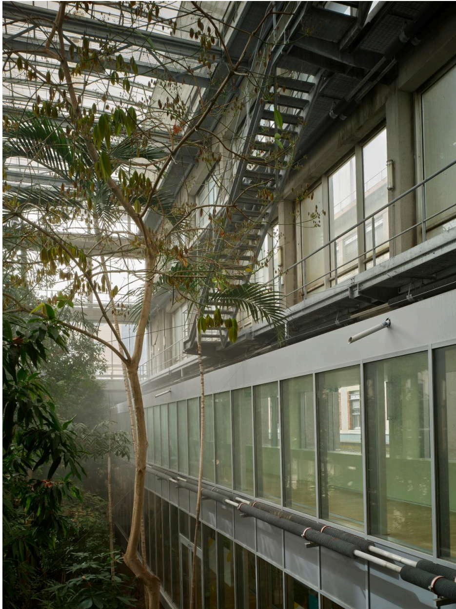
Intérieur de la serre depuis la coursive du premier étage (état 2022).
