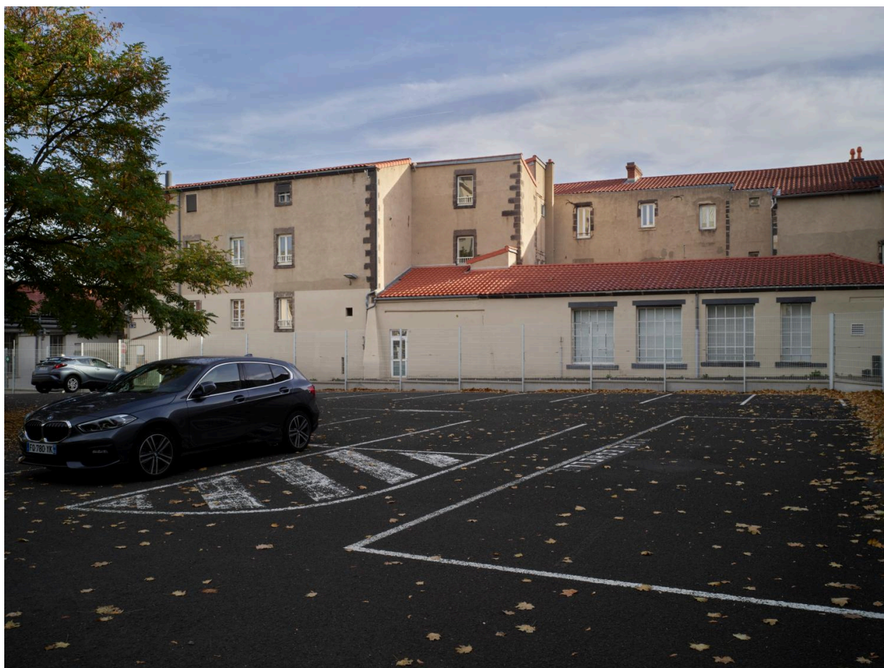
Vue ouest des bâtiments S24 de "la Mission".
