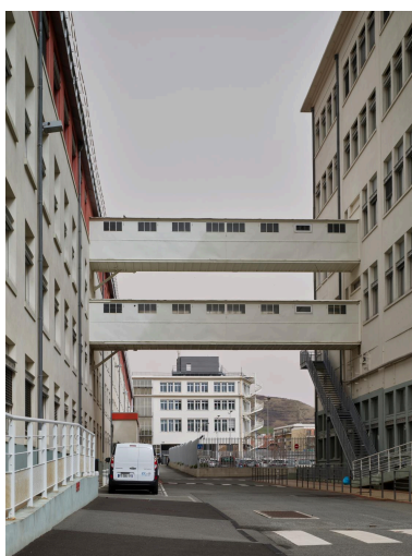
Passerelles entre les bâtiments O10 et O12 (état 2022). En fond de perspective, le bâtiment O14. Phot. Christian Parisey IVR84_20226301438NUC4A
