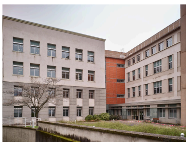
La jonction entre les bâtiments S13 et F12, depuis le nord-ouest (état 2022). Phot. Christian Parisey IVR84_20226301431NUC4A
