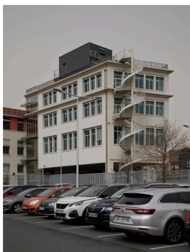
Le bâtiment O14, à l'extrémité nord du site (état 2022). Phot. Christian Parisey IVR84_20226301440NUC4A
