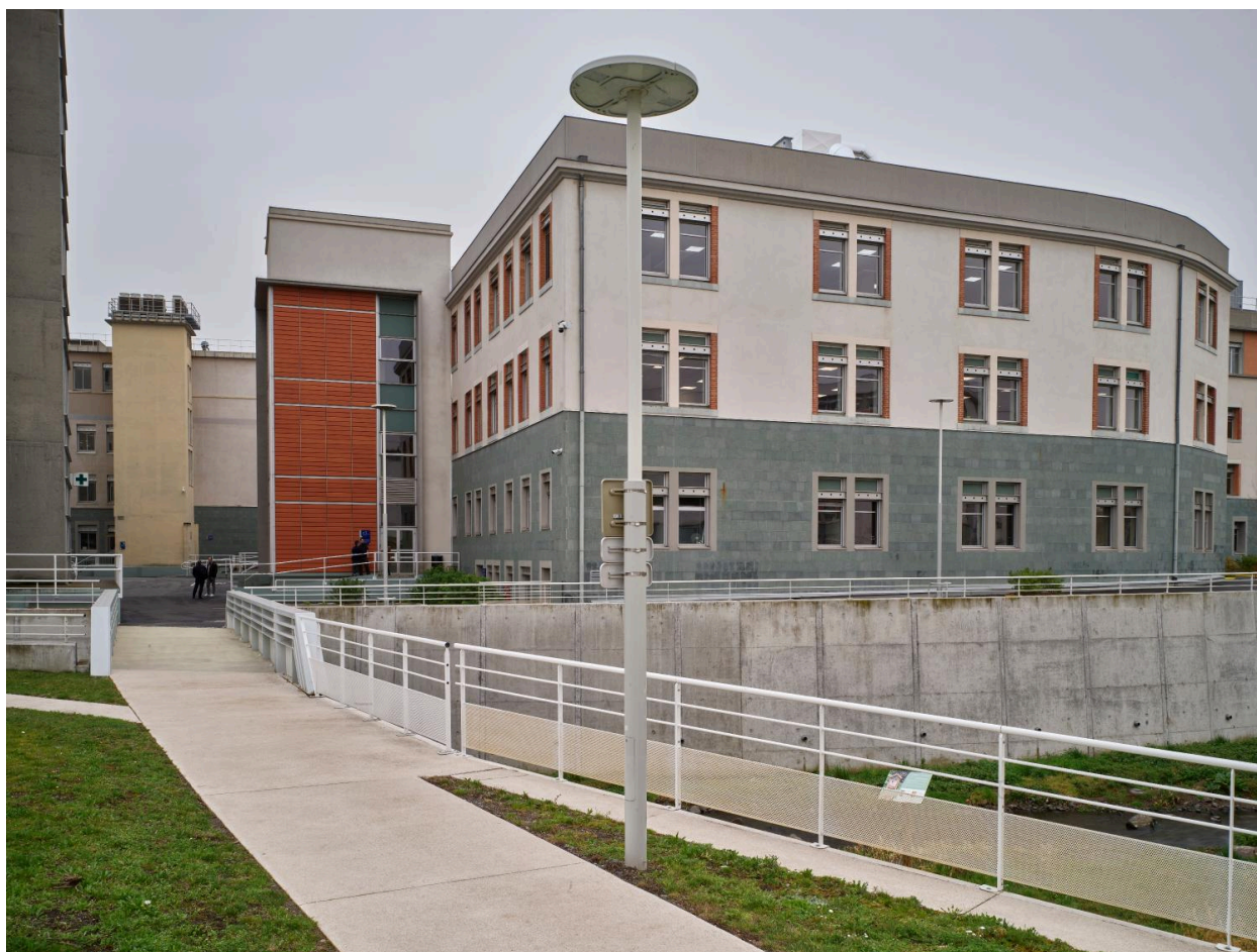
Le bâtiment T2 depuis le nord (état 2022).
