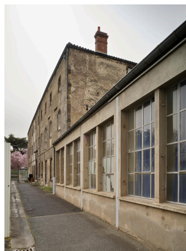
Bâtiments de l'ancienne école Michelin, dite "la Mission", au sud-est du site principal : élévation est des bâtiments S24 (état 2022).
