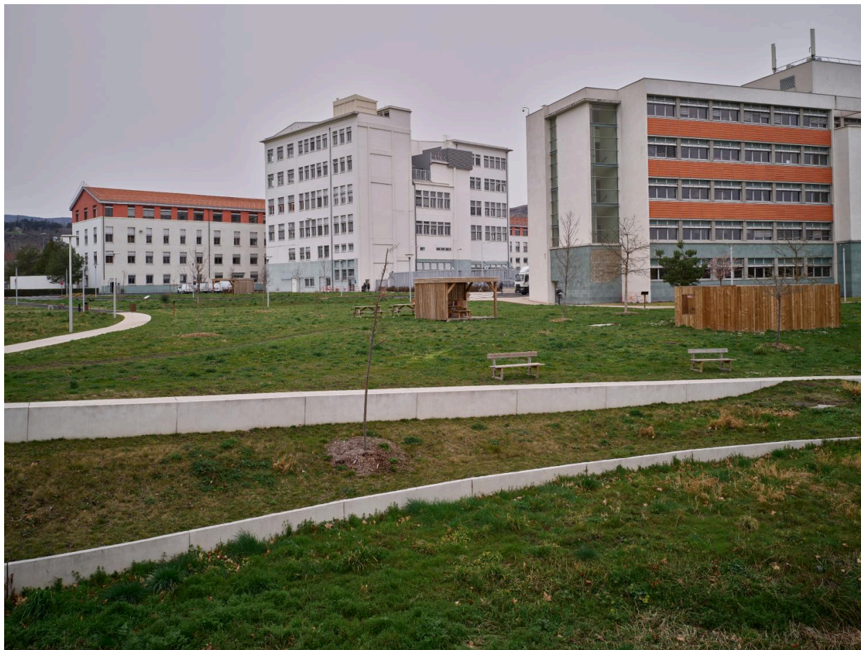
De gauche à droite : l'extrémité sud du bâtiment O10, le bâtiment O12 et une partie du bâtiment A17 (état 2022).
