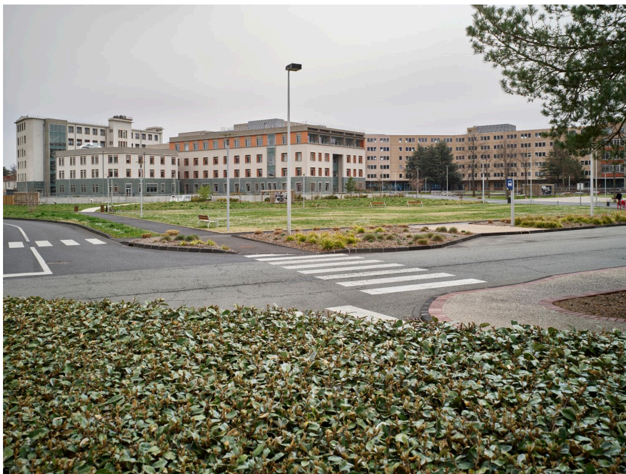
Vue d'ensemble de la partie sud-est du site des Carmes depuis son centre (état 2022) : de gauche à droite, bâtiments T15, T2, T1 et A7.
