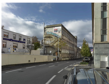
Côté sud de la rue Henri-Barbusse depuis la place des Carmes : état 2018 avant les grandes transformations de 2019-2020. Au centre, l'ancien bâtiment S9, démoli depuis.
