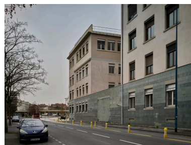
L'extrémité du bâtiment SL côté boulevard et, sur sa droite, une partie du bâtiment T15 (état 2022). Entre les deux, les vestiges d'une ancienne entrée, désormais bouchée. Phot. Christian Parisey IVR84_20226301450NUC4A
