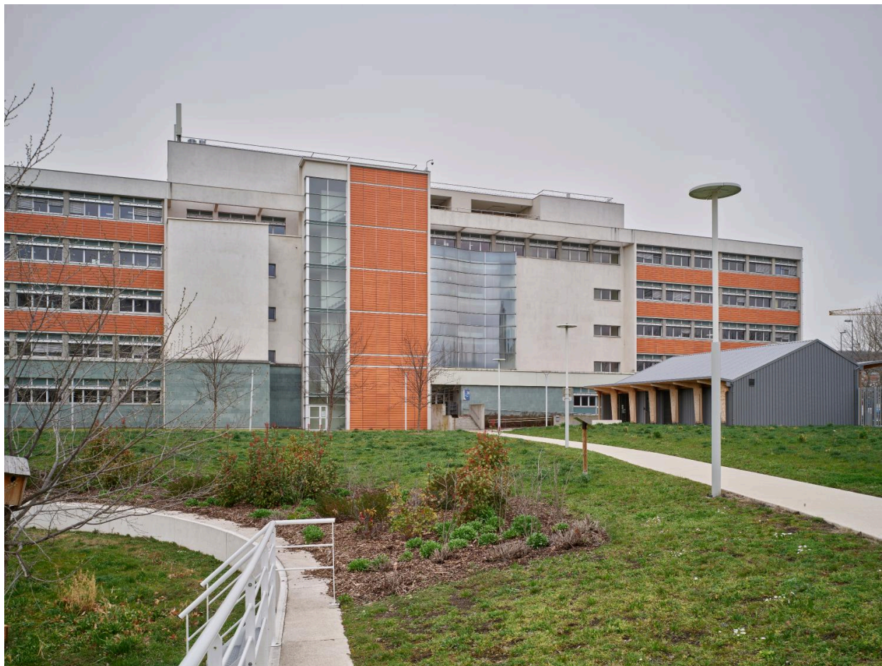
Le bâtiment A17 depuis le sud-est, et à son pied, le petit bâtiment des actuels bureaux A20 (état 2022).
