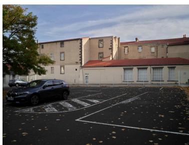
Vue ouest des bâtiments S24 de "la Mission". Phot. Emeline Munier IVR84_20226304625NUC4A
