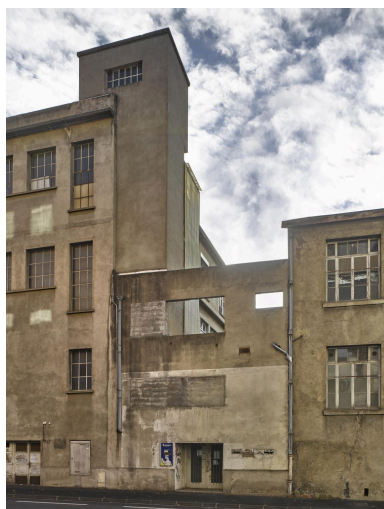
Anciens locaux Michelin du côté sud de la rue Henri-Barbusse (état 2018, avant démolitions de 2019) : jonction entre les bâtiments S9 et S18.
