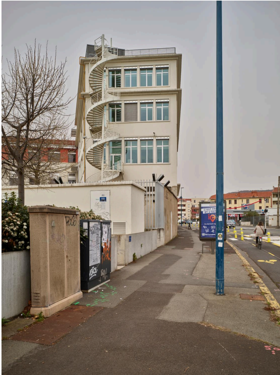
Élévation est du bâtiment O14 et son escalier de secours (état 2022).
