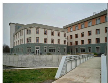
Passerelle sur la Tiretaine donnant accès, côté nord, aux bâtiments T2 et T1 (état 2022).
