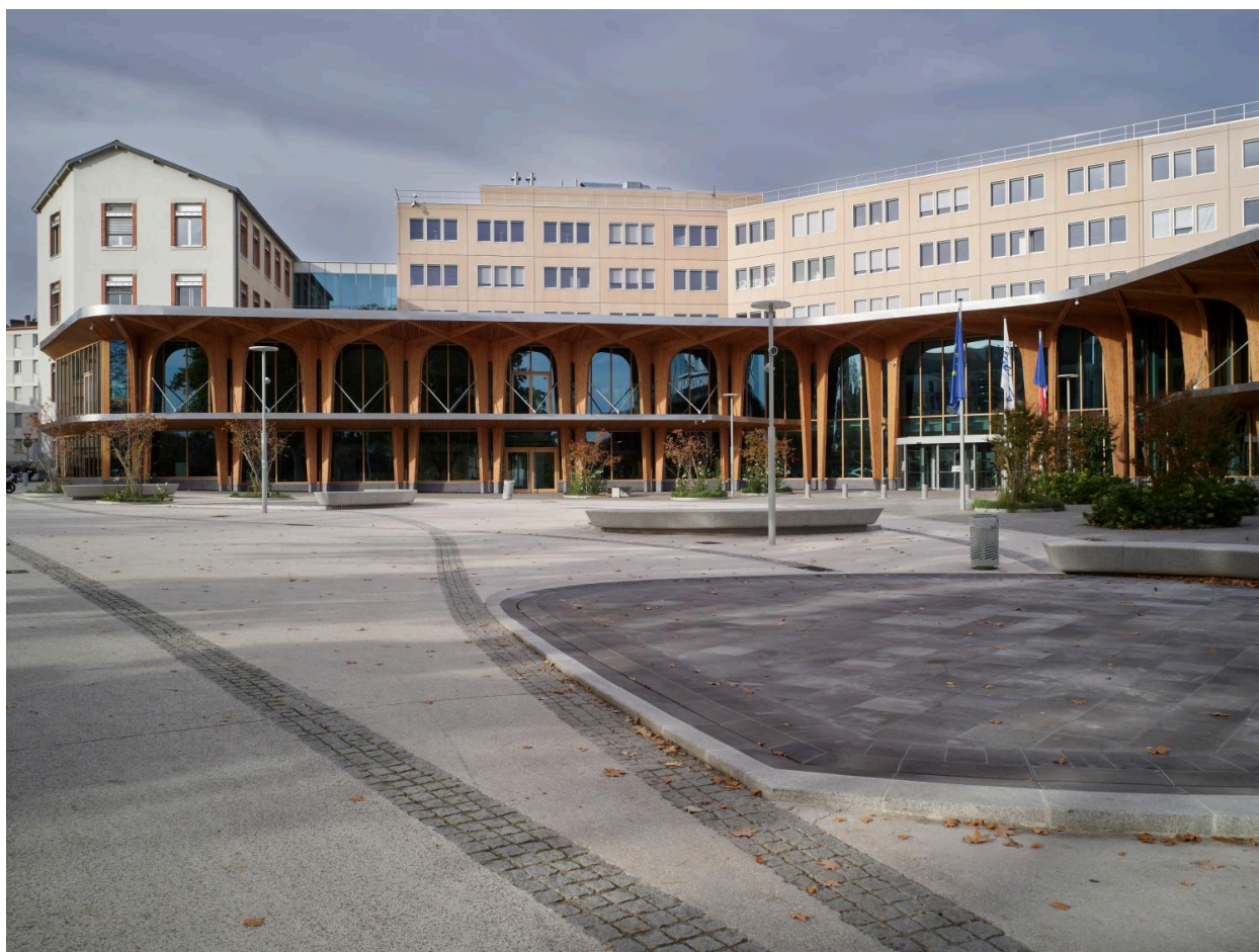
La Canopée, nouvel espace d'accueil du siège social de Michelin, ouvert sur la place des Carmes rénovée.
