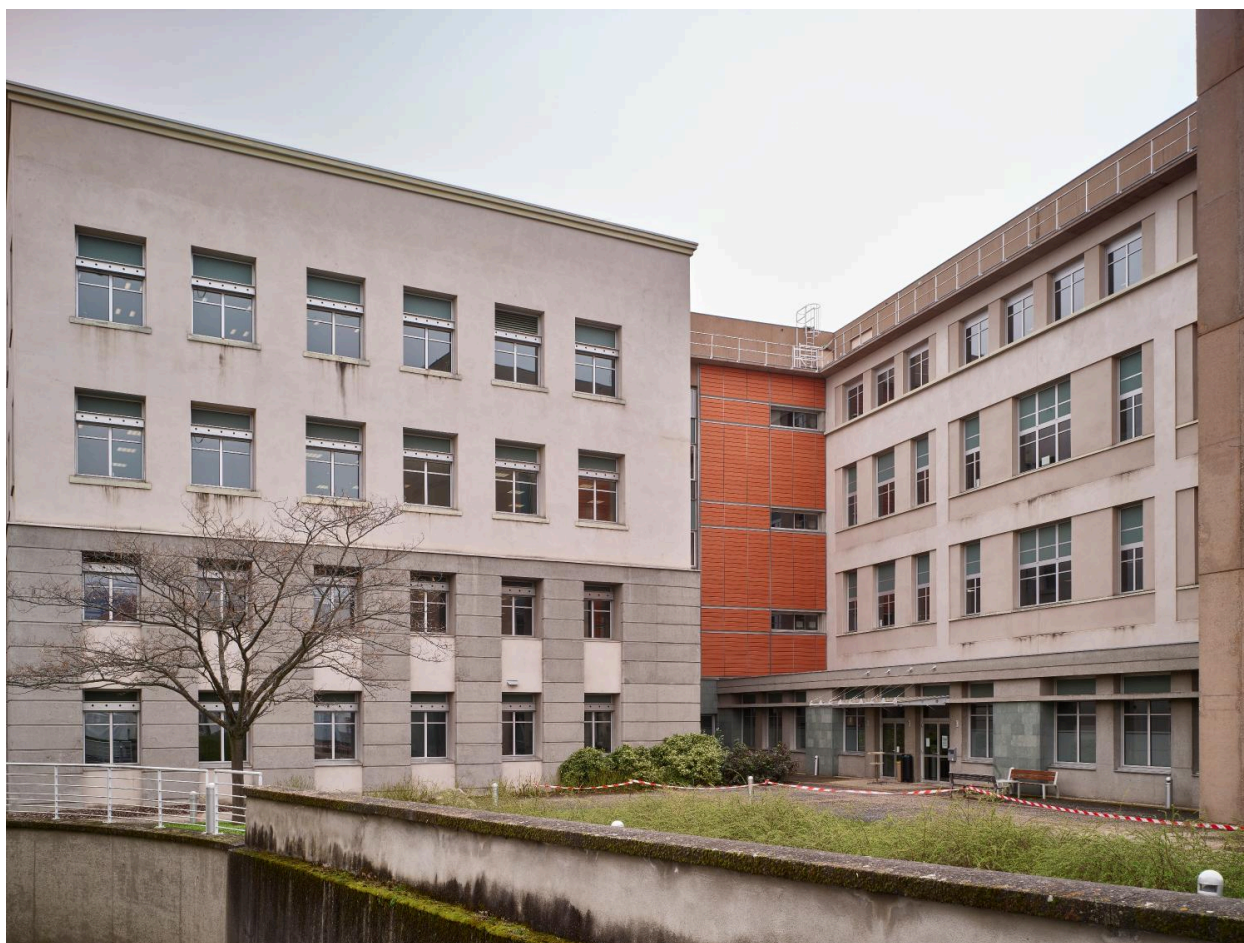
La jonction entre les bâtiments S13 et F12, depuis le nord-ouest (état 2022).
