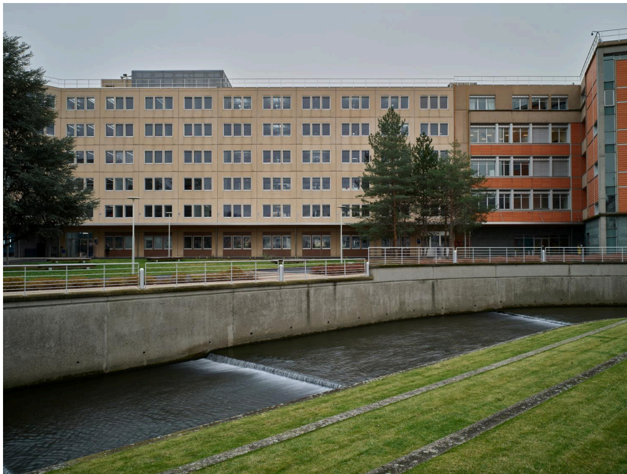
Élévation nord du bâtiment A7. Au premier plan, les rives réaménagées de la Tiretaine dans sa traversée du site (état 2022).
