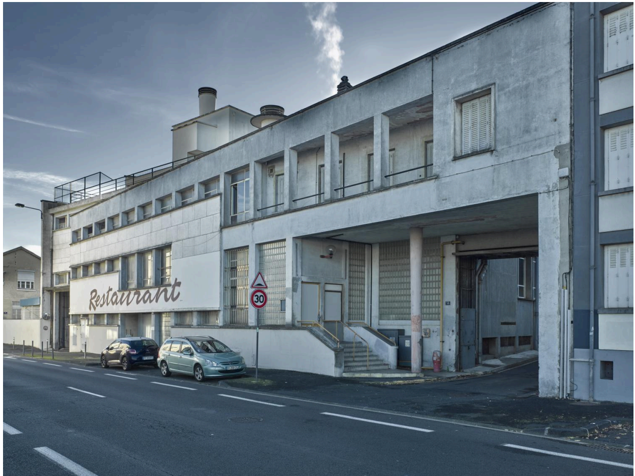
Ancien restaurant d'entreprise S47 (puis centre de formation et d'audiovisuel), du côté sud de la rue Henri-Barbusse : état de 2018, avant sa démolition en 2022.
