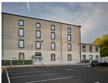
Bâtiment S23 de "la Mission" (état 2022), école Michelin installée dans l'ancien couvent des Carmes-Déchaux : vue depuis le nord.
