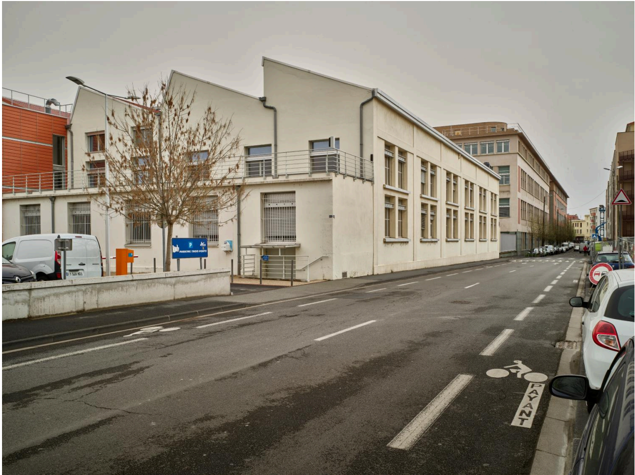
Les élévations ouest et sud du bâtiment B8, depuis la rue Henri-Barbusse (état 2022).
