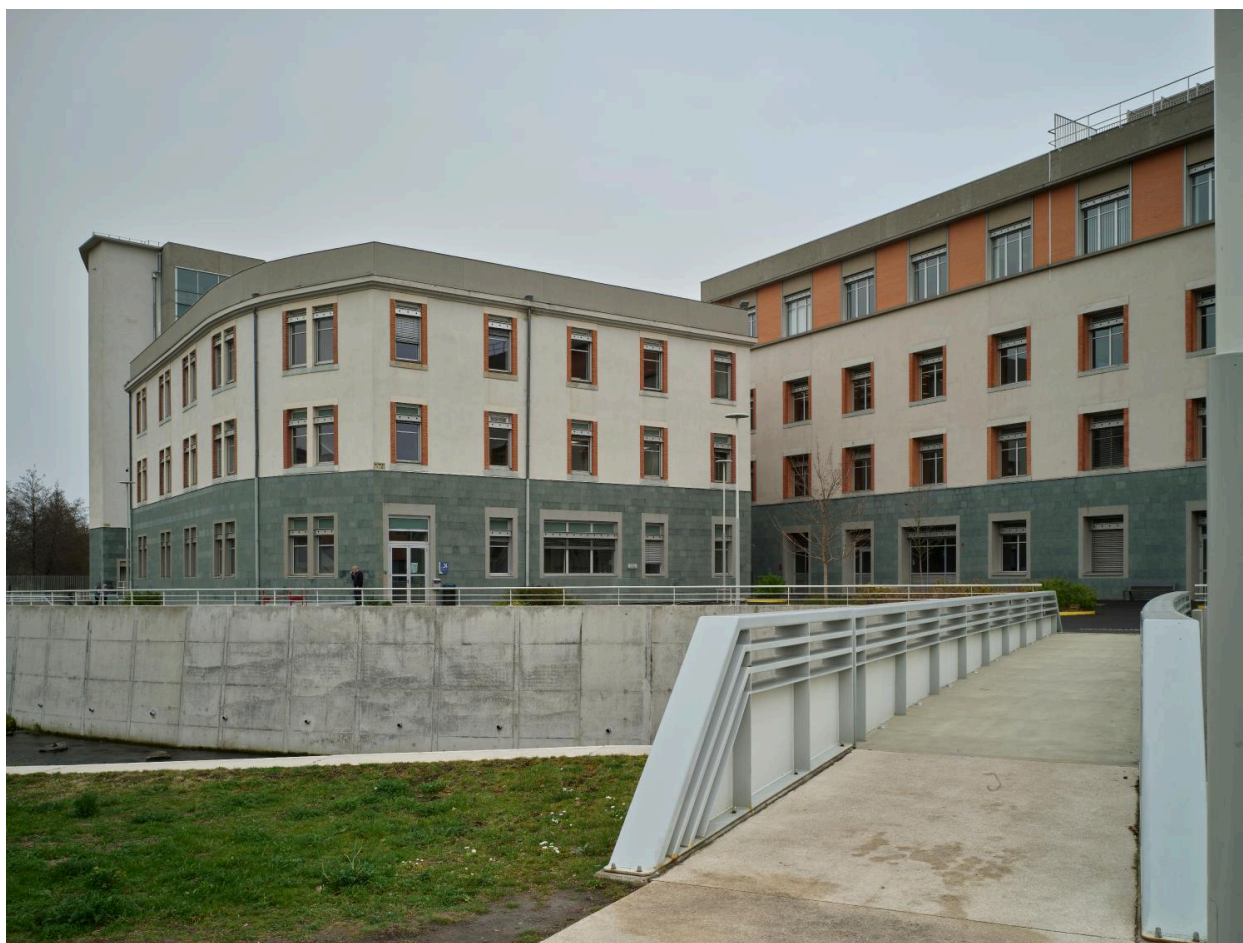
Passerelle sur la Tiretaine donnant accès, côté nord, aux bâtiments T2 et T1 (état 2022).
