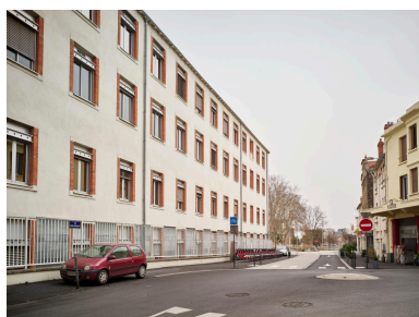
Le bâtiment A2 rue Henri-Barbusse, en direction de la place des Carmes (état 2022).
