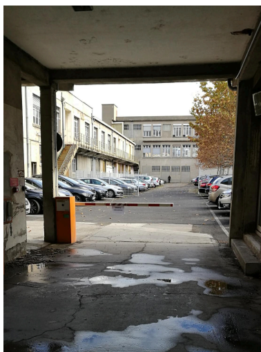
Vue arrière des anciens bâtiments S21, S18 et S9 détruits en 2019, depuis le porche ouvrant sur la rue d'Ormesson : état 2018. (Photo chercheur).
