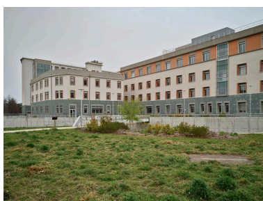
Les bâtiments T2 (à gauche) et T1 (à droite) vus depuis le nord-ouest (état 2022).
