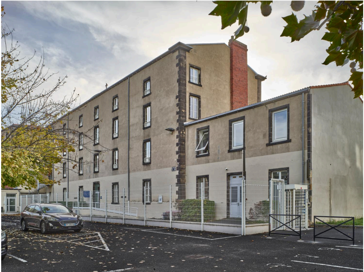
Bâtiment S23 de "la Mission" (état 2022), école Michelin installée dans l'ancien couvent des Carmes-Déchaux : vue depuis le nord-ouest.
