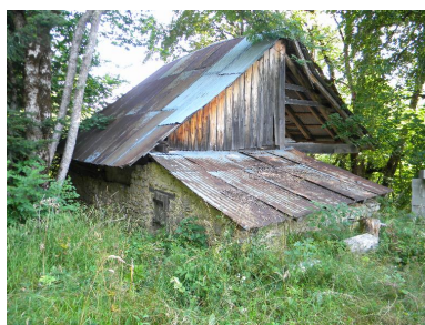
Vue d'ensemble Phot. Jérôme Daviet IVR84_20167306797NUCA
