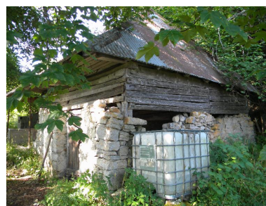
Vue de trois-quarts nord-est. Phot. Jérôme Daviet IVR84_20167306795NUCA
