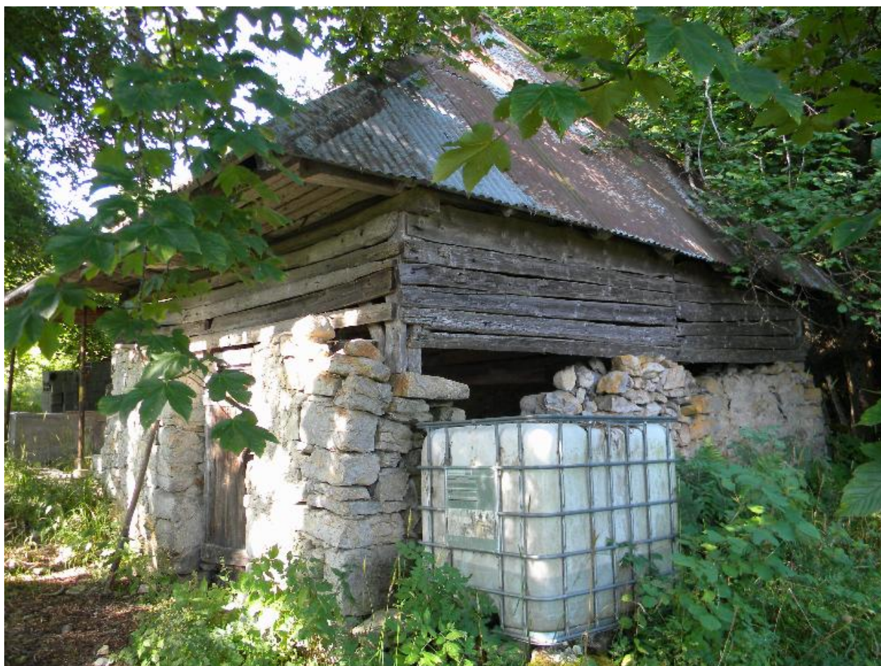
Vue de trois-quarts nord-est.
