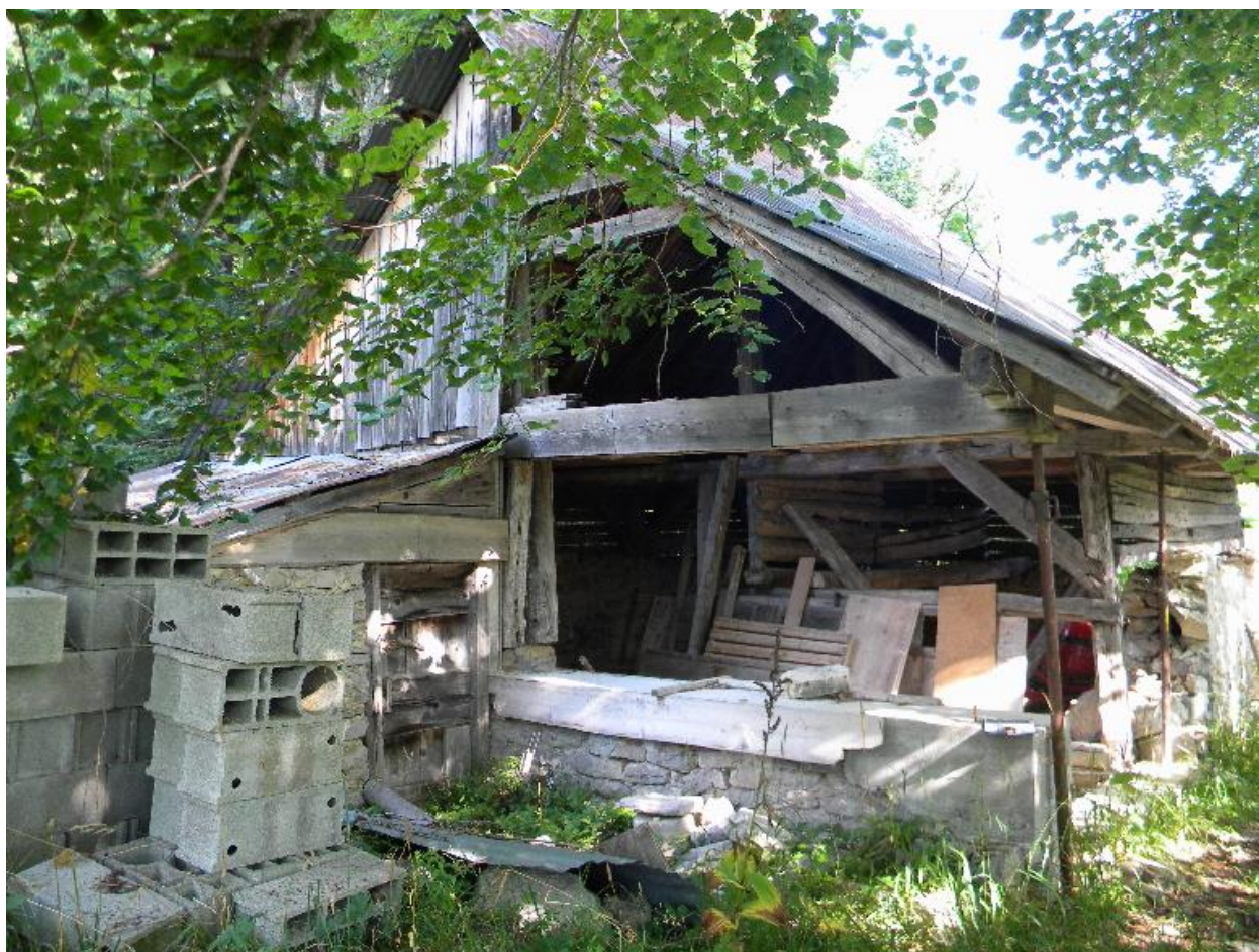
Vue du pignon sud.
