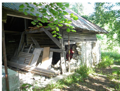
Vue de trois-quarts sud-est. Phot. Jérôme Daviet IVR84_20167306794NUCA
