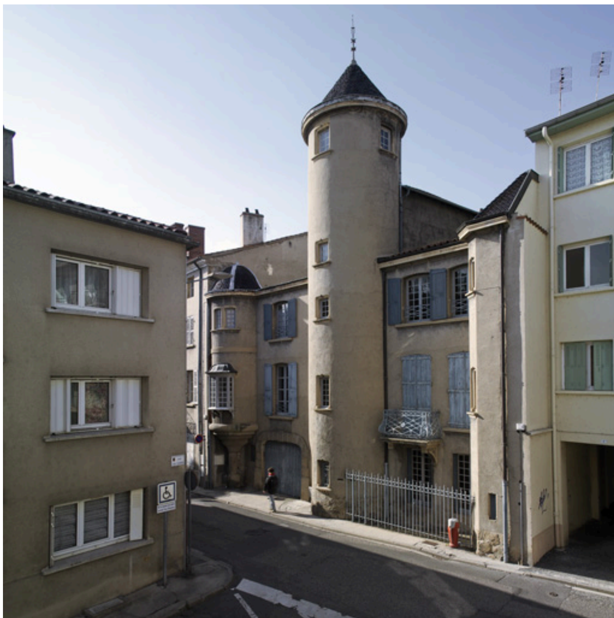
Vue d'ensemble de l'élévation principale sur rue.
