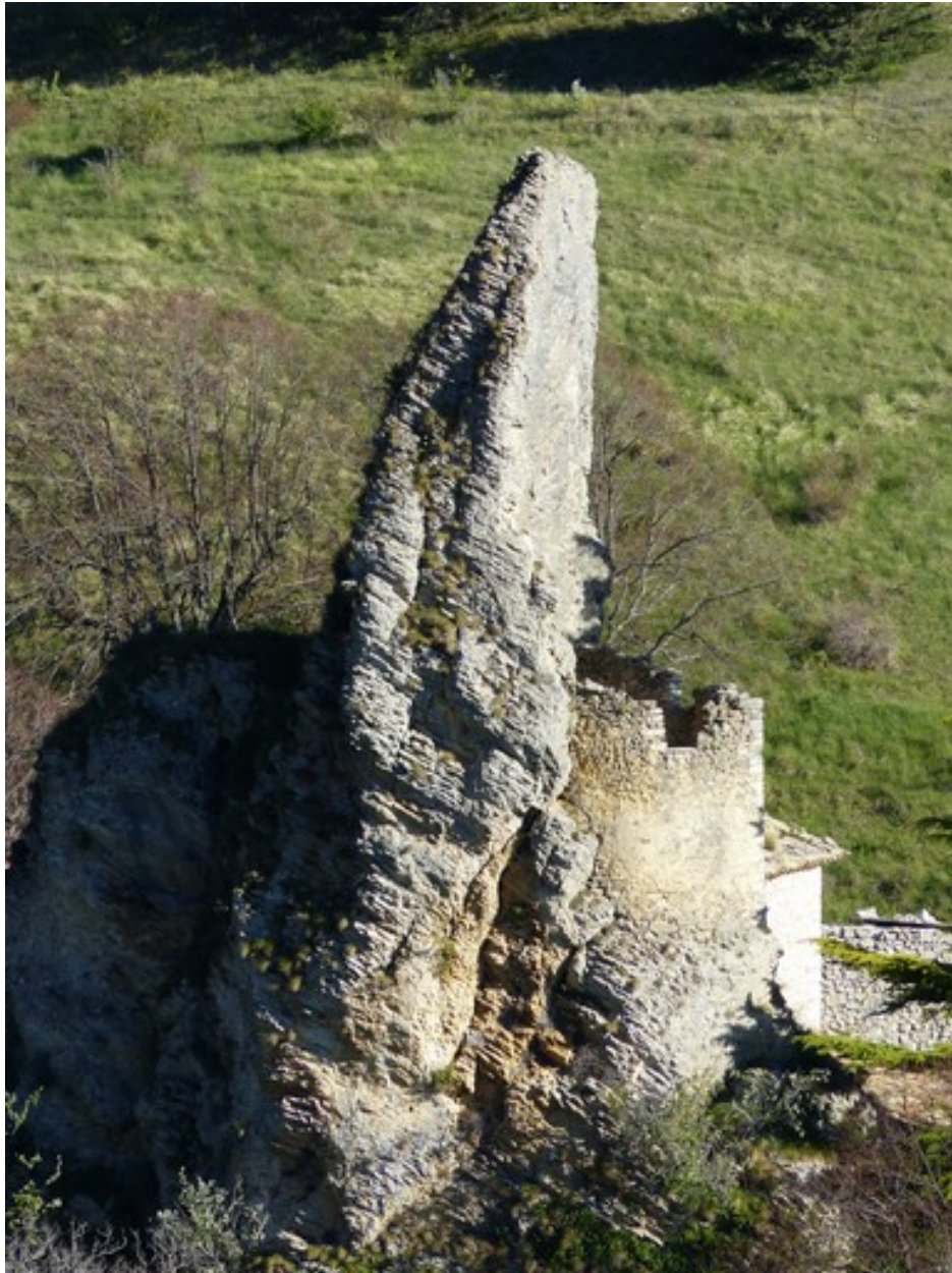
Vue de situation prise du nord.
