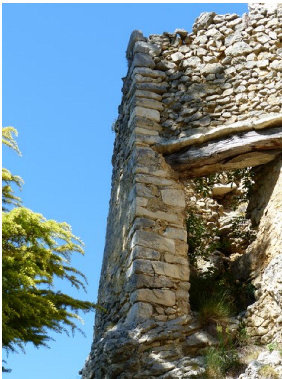
Extrémité du mur ouest.
