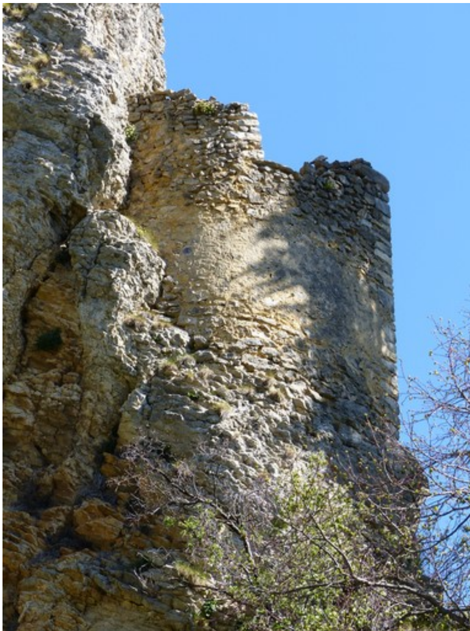
Vue d'ensemble prise du nord-ouest.
