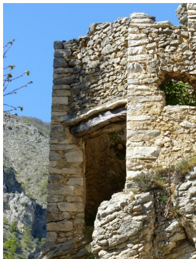
Angle sud-ouest, porte. Phot. Alexei Laurent IVR84_20162600305NUCA
