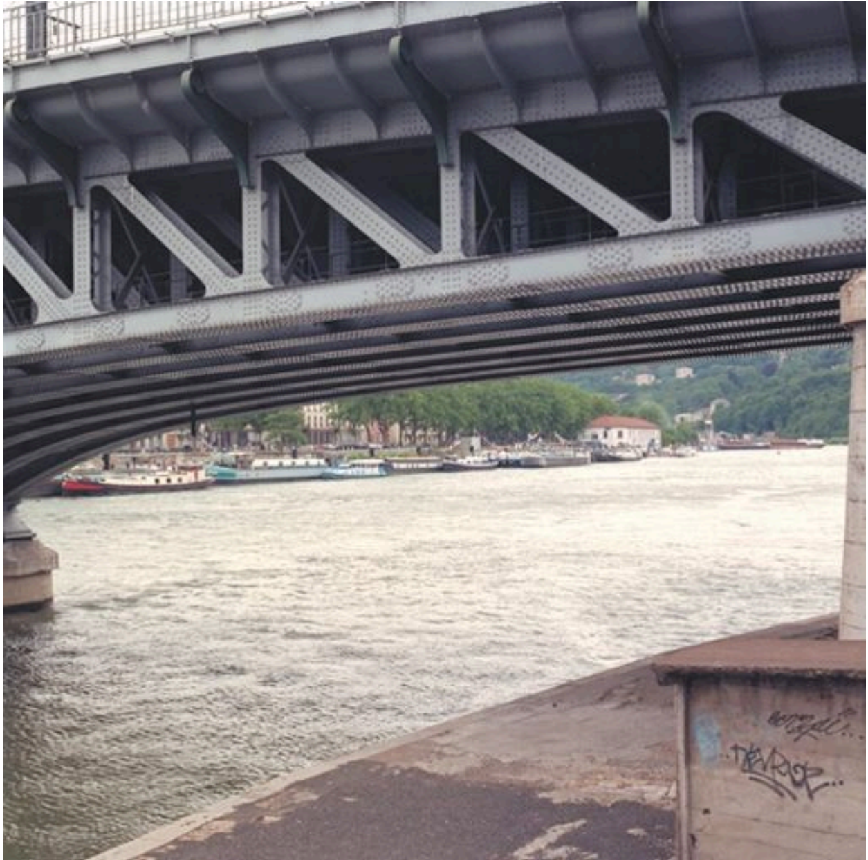
Fête des mariniers. Vue d'ensemble depuis le nord de la rive droite
