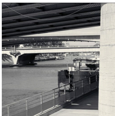
Vue d'ensemble vers le nord depuis le bas-quai, à la hauteur du viaduc de la Quarantaine : l'enfilade des 3 ponts (la Quarantaine, autoroutier et Kitchener-Marchand) Phot. Eric Dessert IVR82_20026903801X
