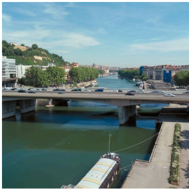
Vue d'ensemble vers le nord depuis le poste d'aiguillage 1 de Lyon-Perrache
