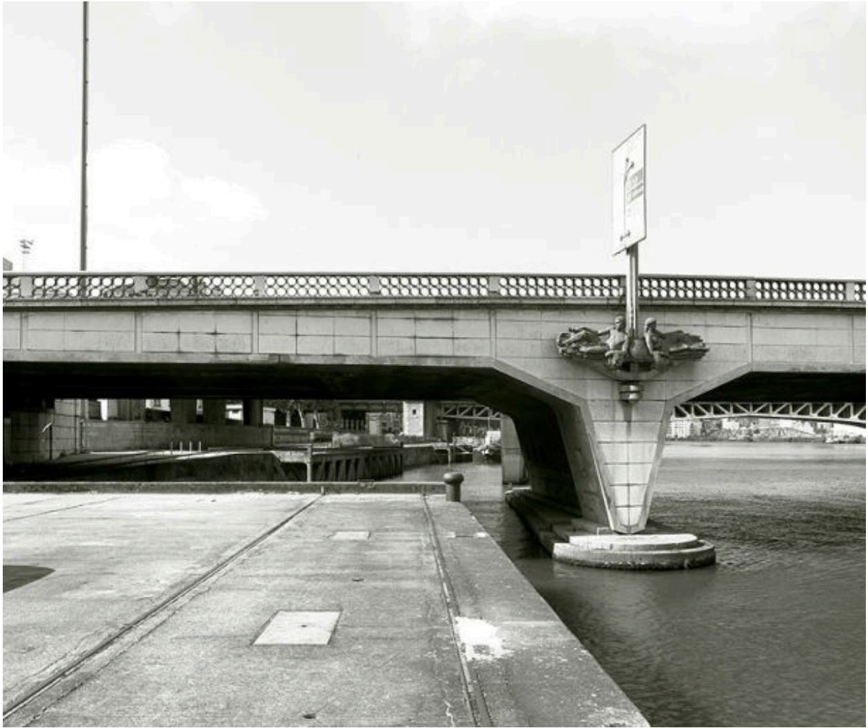
Vue d'ensemble du bas-quai de la rive gauche, depuis le nord du pont Kitchener-Marchand
