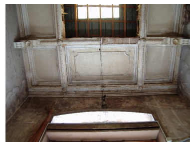
Plafond à décor de stuc Phot. François Fouger IVR82_20077300579NUCA
