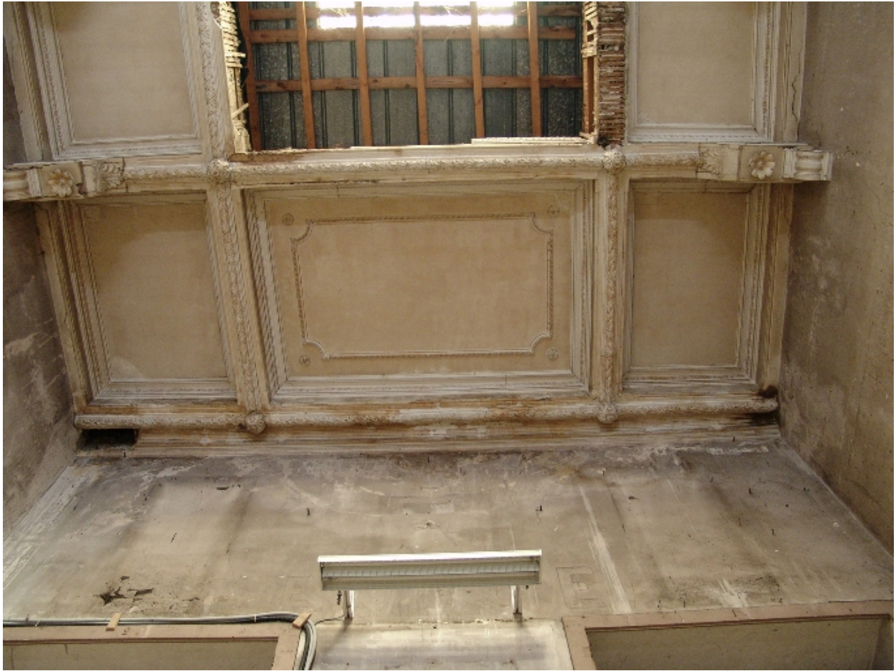
Plafond à décor de stuc, détail
