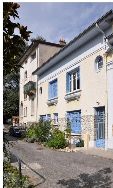
Façade de la maison Phot. François Fouger IVR82_20117300574NUCA
