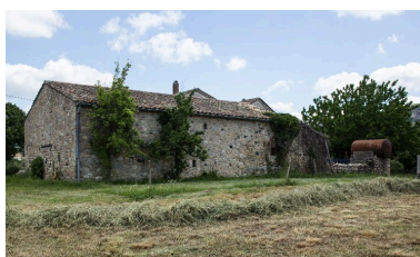
Grange : façade sud Phot. Pascal Lemaître IVR82_20140700196NUCA
