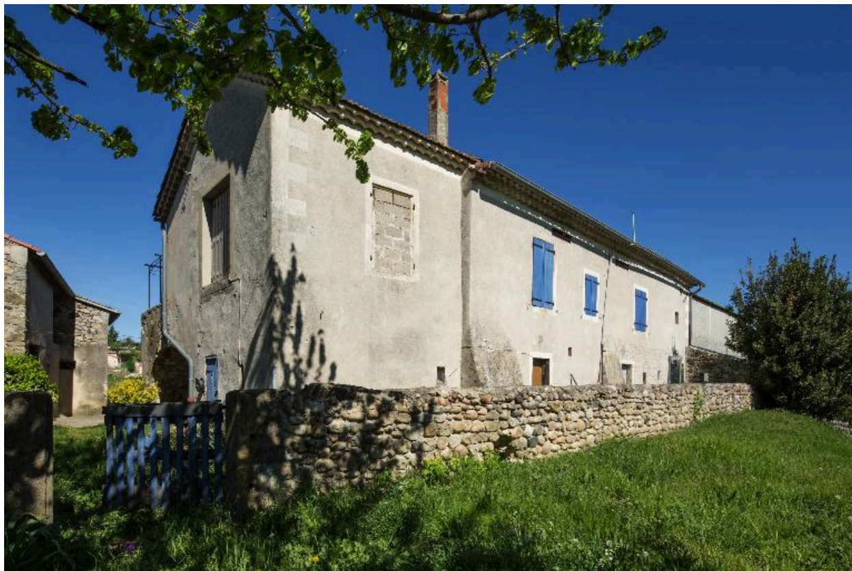
Maison : façades ouest et sud
