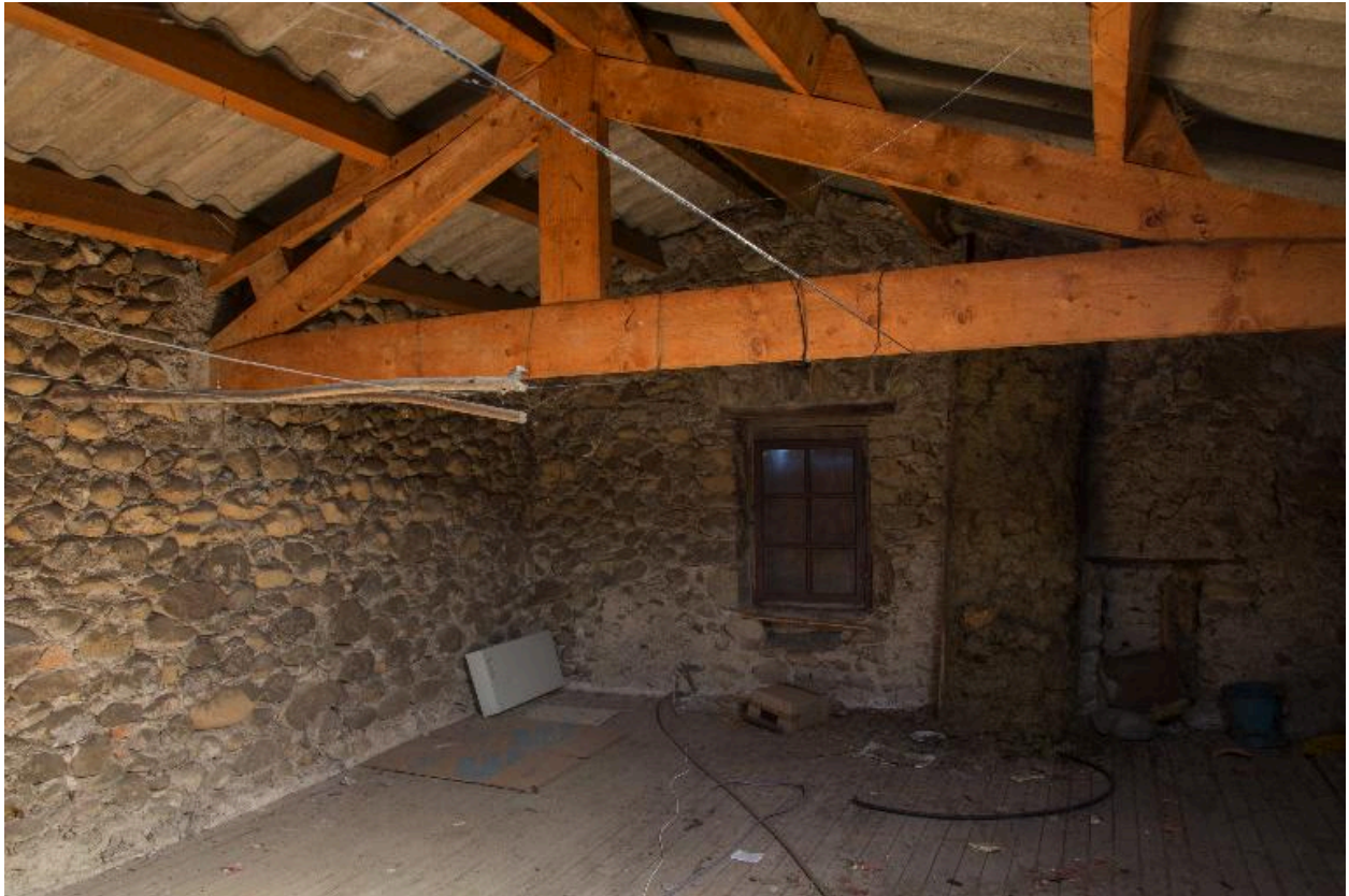
Maison : intérieur, grenier
