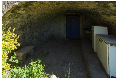
Maison : façade ouest, entrée de cave voûtée Phot. Pascal Lemaître IVR82_20140700193NUCA
