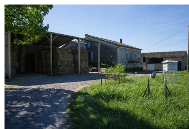
Vue d'ensemble côté est Phot. Pascal Lemaître IVR82_20140700188NUCA
