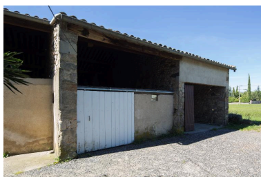
Grange : façade sud Phot. Pascal Lemaître IVR82_20140700199NUCA
