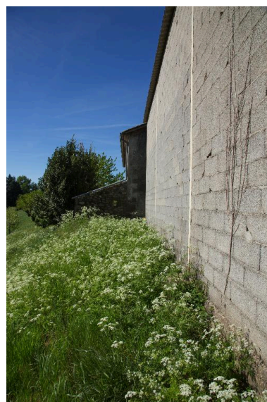
Grange : façade ouest ; au fond, façade nord de la maison Phot. Pascal Lemaître IVR82_20140700197NUCA
