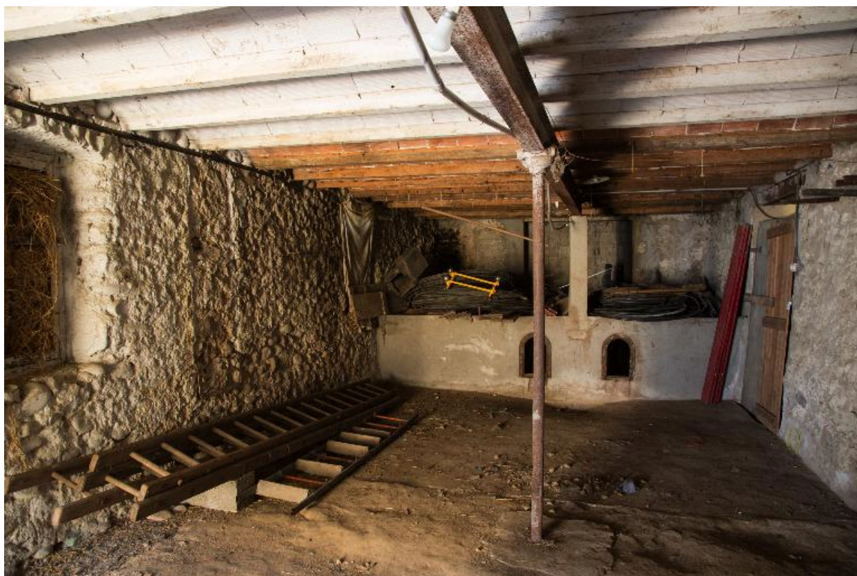
Maison : intérieur, cave côté est. Au fond, séchoir de 1925
