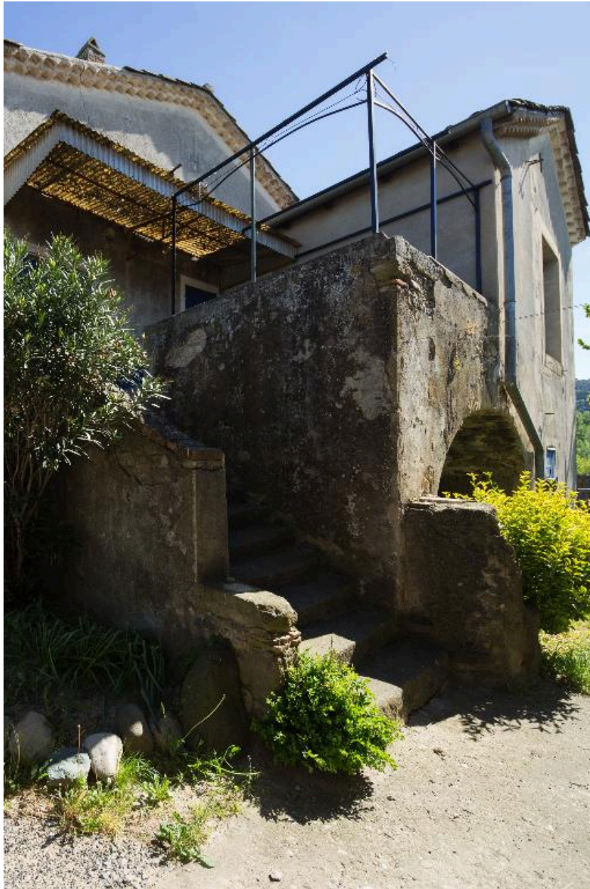
Maison : façade ouest, accès par escalier
