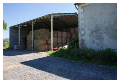
Hangar Phot. Pascal Lemaître IVR82_20140700203NUCA
