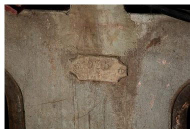
Maison : intérieur, cave côté est. Cartouche à date Phot. Pascal Lemaître IVR82_20140700206NUCA
