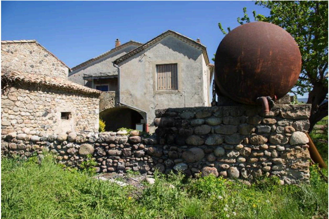
Côté ouest : mur du jardin et citerne
