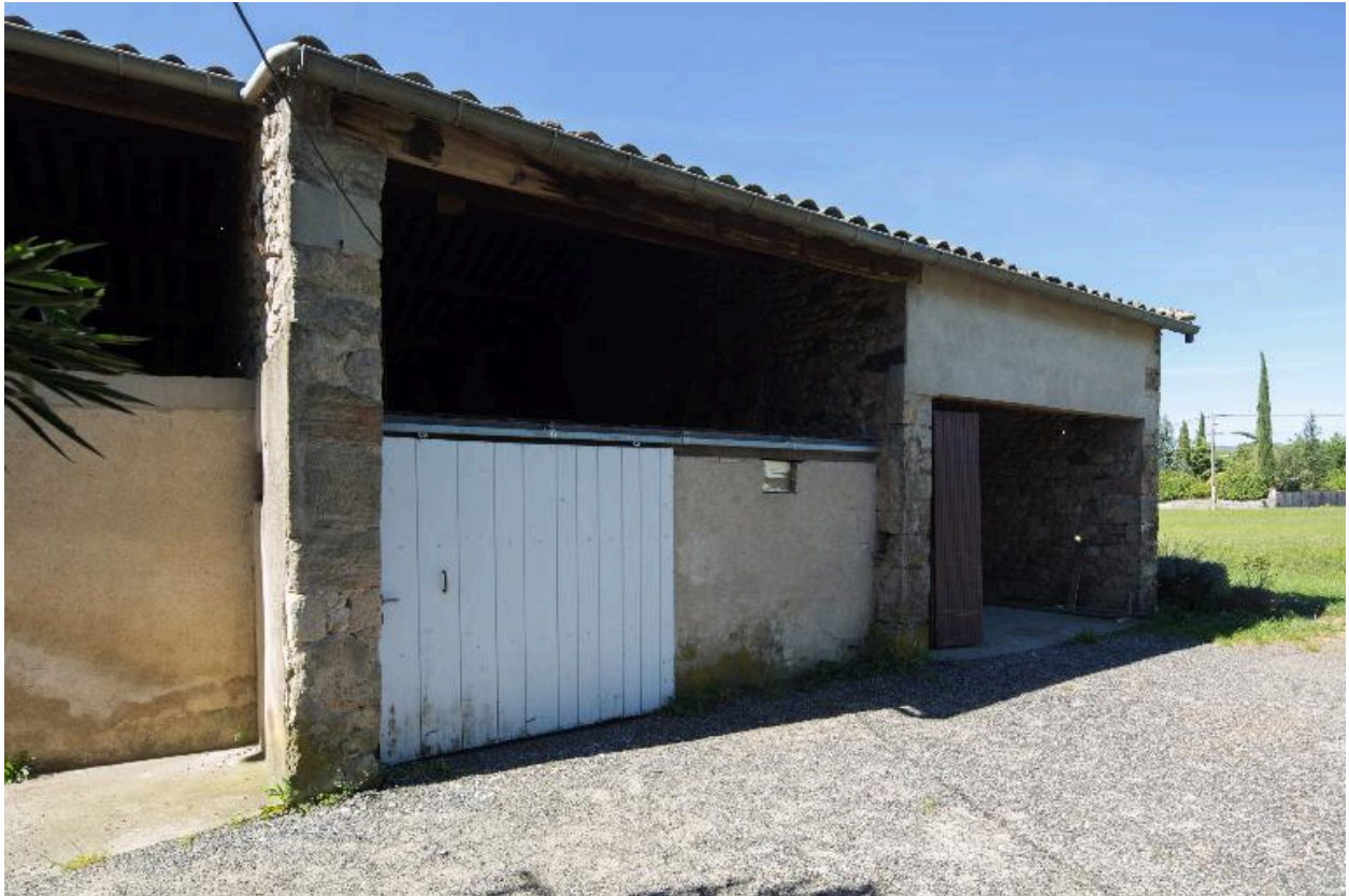
Grange : façade sud
