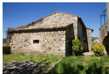
Grange : façade ouest, jardin au premier plan Phot. Pascal Lemaître IVR82_20140700200NUCA
