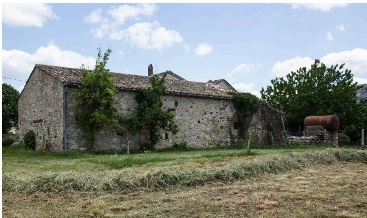
Grange : façade sud
