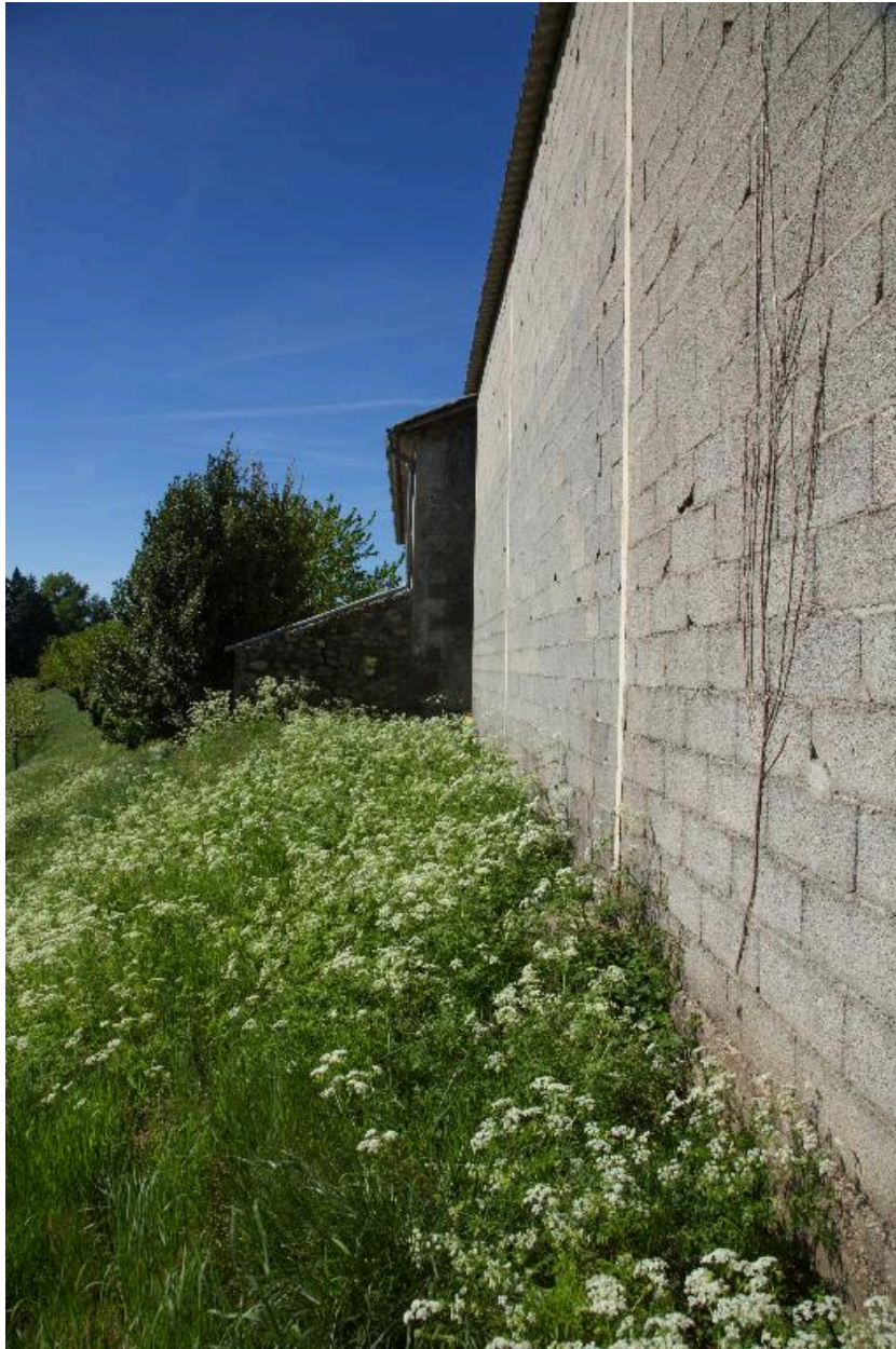
Grange : façade ouest ; au fond, façade nord de la maison
