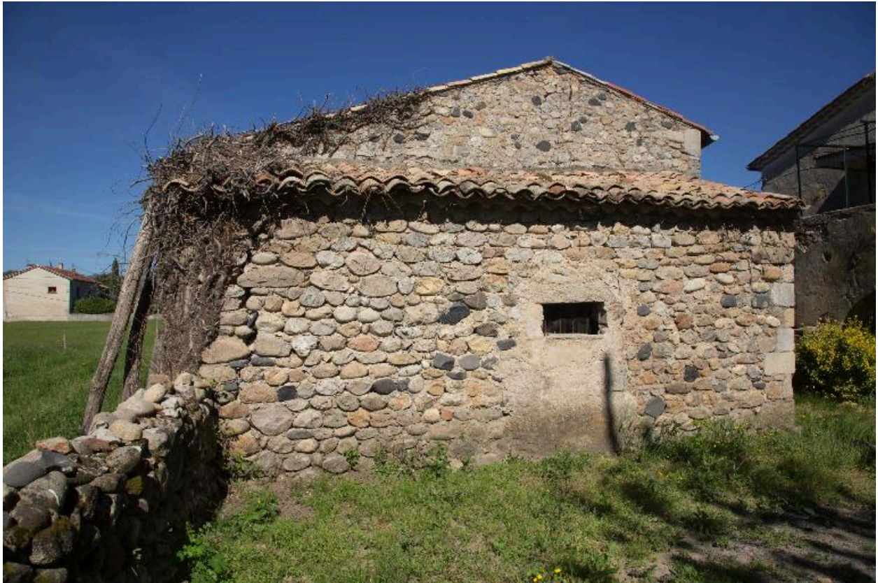
Grange : façade ouest
