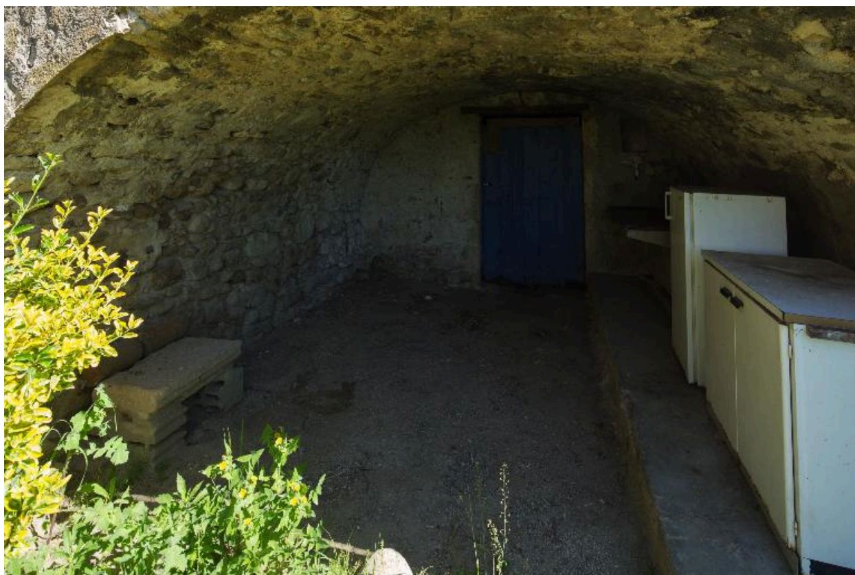
Maison : façade ouest, entrée de cave voûtée
