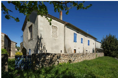
Maison : façades ouest et sud Phot. Pascal Lemaître IVR82_20140700192NUCA
