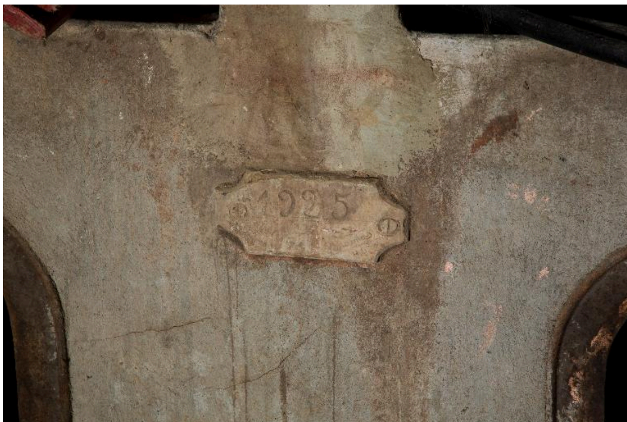
Maison : intérieur, cave côté est. Cartouche à date
