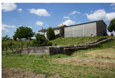
Vue générale depuis l'ouest, canal maçonné au premier plan Phot. Pascal Lemaître IVR82_20140700187NUCA
