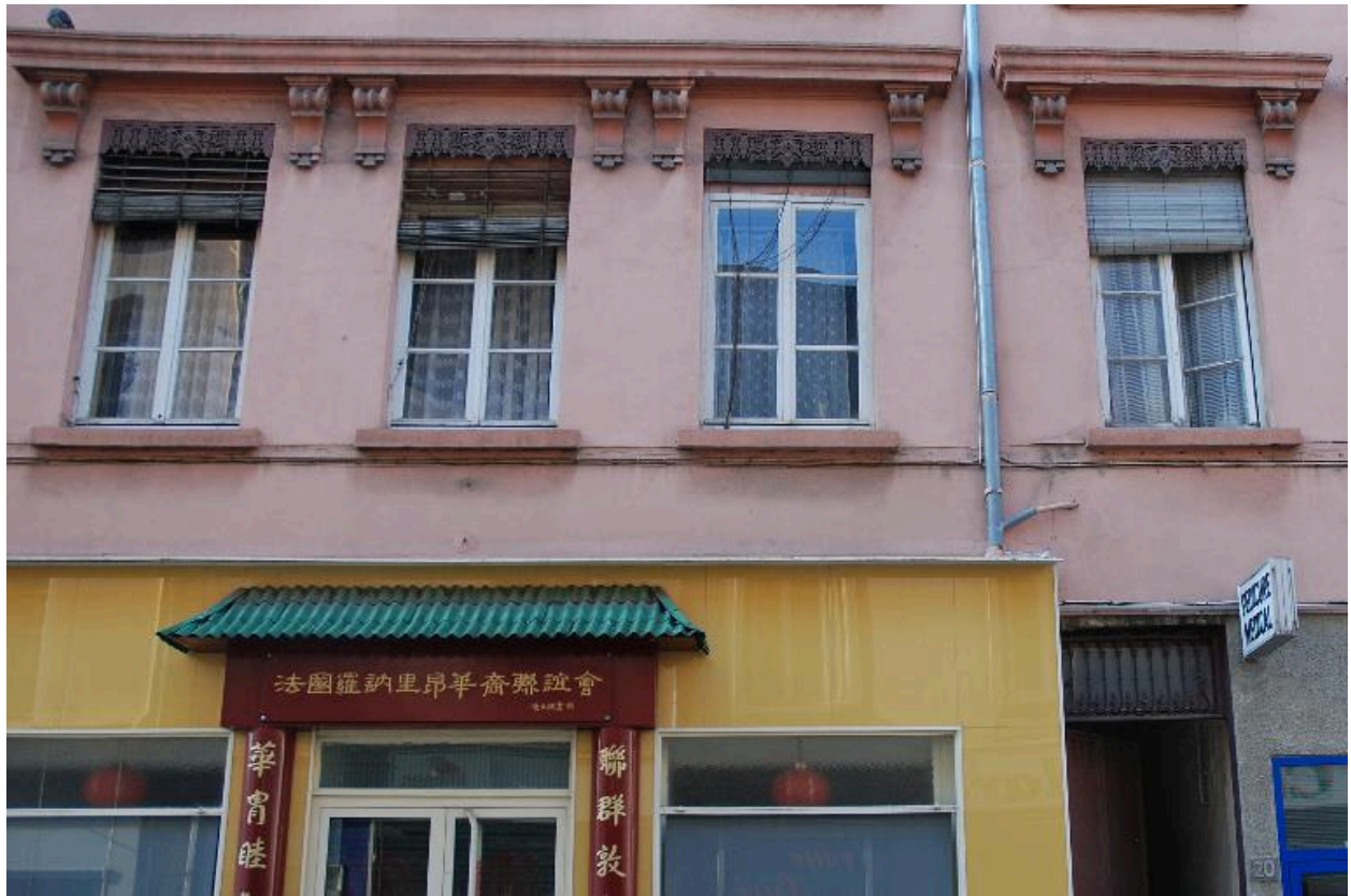
Vue rapprochée de l'élévation antérieure : le décor du premier étage carré
