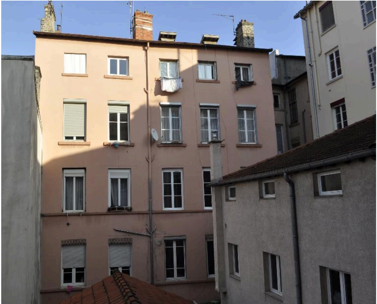
Vue générale de l'élévation postérieure
