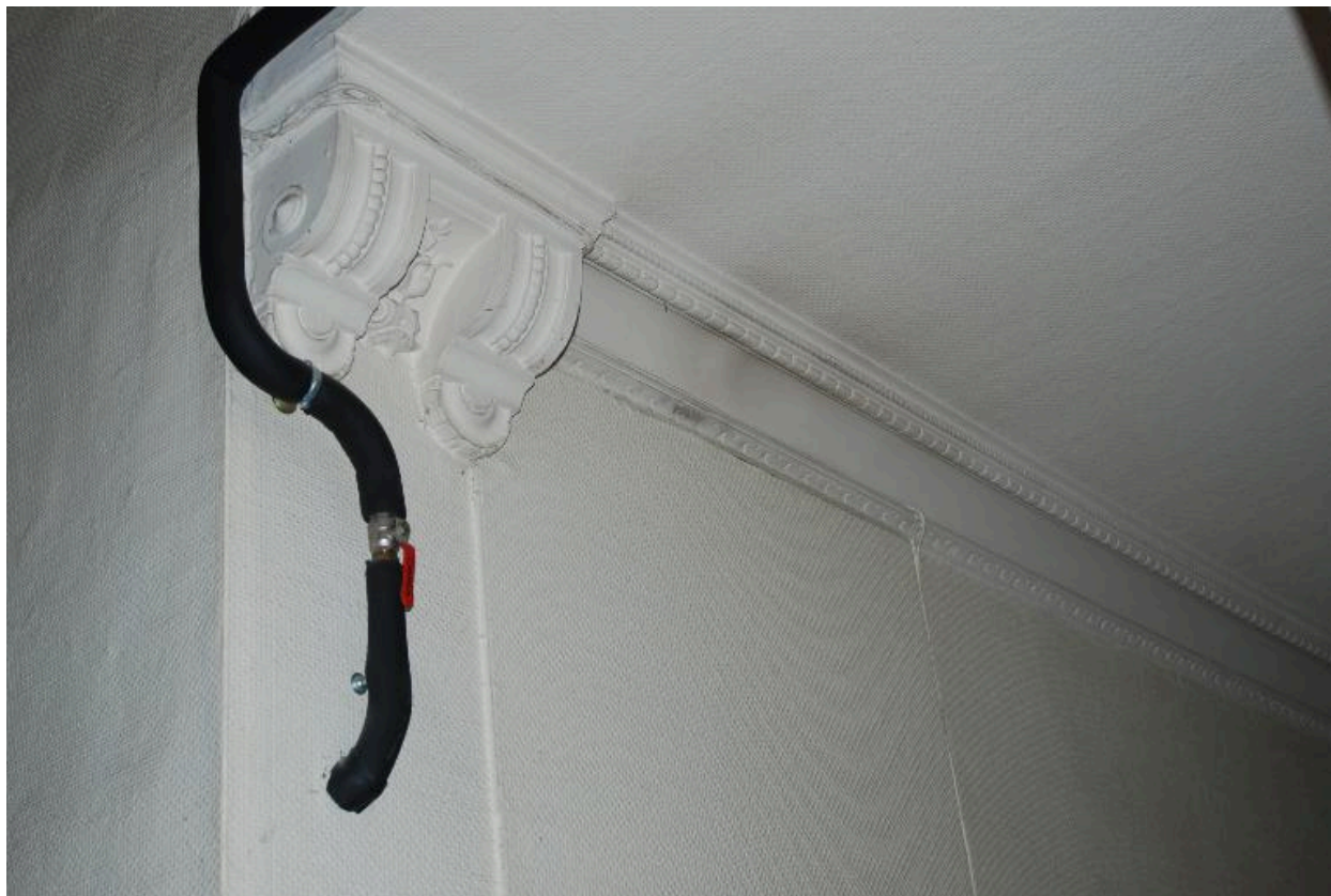
Vue intérieure : détail de la mouluration du plafond du couloir au rez-de-chaussée
