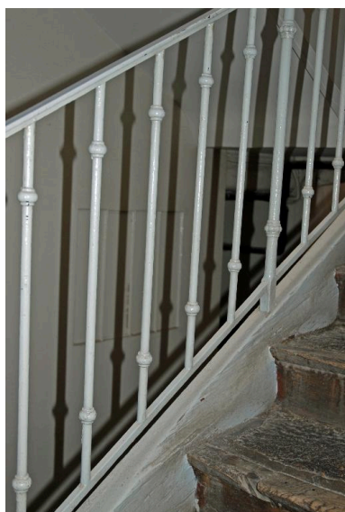
Vue intérieure : détail du garde-corps de l'escalier Phot. Magali Delavenne IVR82_20156902564NUCA
