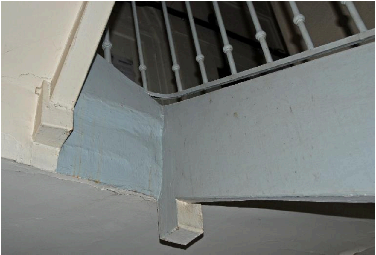
Vue intérieure : détail de la structure de l'escalier en charpente
