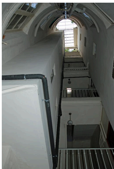
Vue de la courette couverte d'une verrière : colonne de sanitaires à gauche, paliers de l'escalier au fond Phot. Magali Delavenne IVR82_20156902561NUCA
