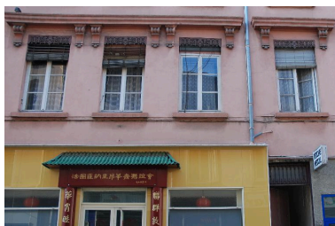
Vue rapprochée de l'élévation antérieure : le décor du premier étage carré Phot. Magali Delavenne IVR82_20156902560NUCA
