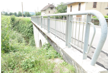
Pont de la Petite Morge, vue de la face amont, détail des garde-corps Phot. Pascale Renard IVR84_20207403101NUCA
