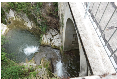
Pont de la Petite Morge, détail du seuil en face aval Phot. Pascale Renard IVR84_20207403104NUCA
