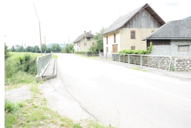
Pont de la Petite Morge, vue de la chaussée et des bâtiments alentours Phot. Pascale Renard IVR84_20207403105NUCA
