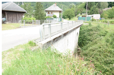
Pont de la Petite Morge, vue de la face aval Phot. Pascale Renard IVR84_20207403103NUCA
