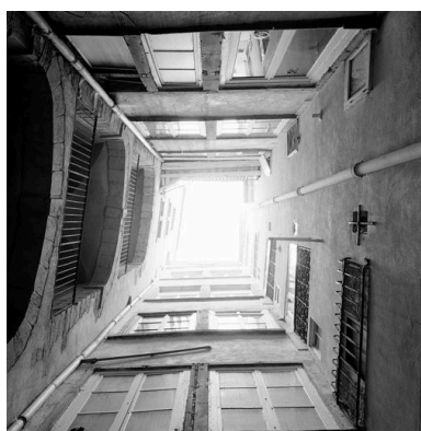
Cour commune, vue générale par-dessous Phot. Didier Gourbin IVR82_20056902646X
