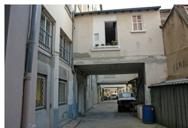
Loge de concierge. Vue depuis le nord Phot. Maryannick Chalabi IVR82_20076900302NUCA
