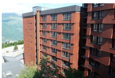
Façade sud. Vue générale depuis l'est Phot. Jean-François Lyon-Caen IVR82_20127302530NUCA
