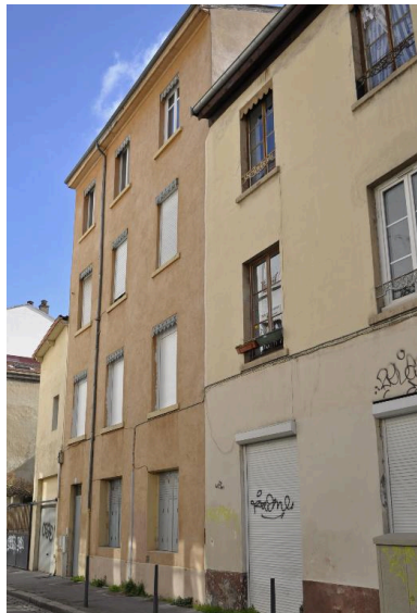
Elévation sur rue, vue générale Phot. Catherine Guégan IVR84_20176900979NUCA
