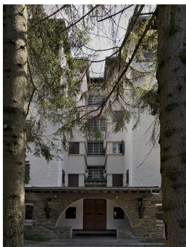
Élévation nord Phot. Eric Dessert IVR82_20107401368NUCA
