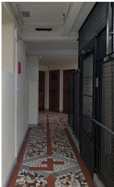
Vue d'ensemble du palier du 4e étage Phot. Eric Dessert IVR82_20107401278NUCA
