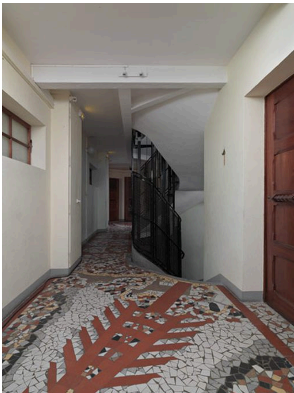
Le palier du rez-de-chaussée surélevé
