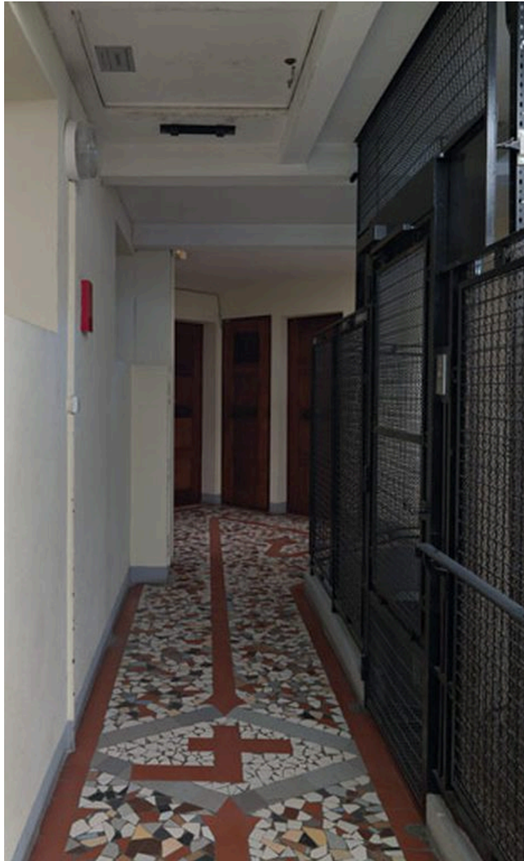
Vue d'ensemble du palier du 4e étage
