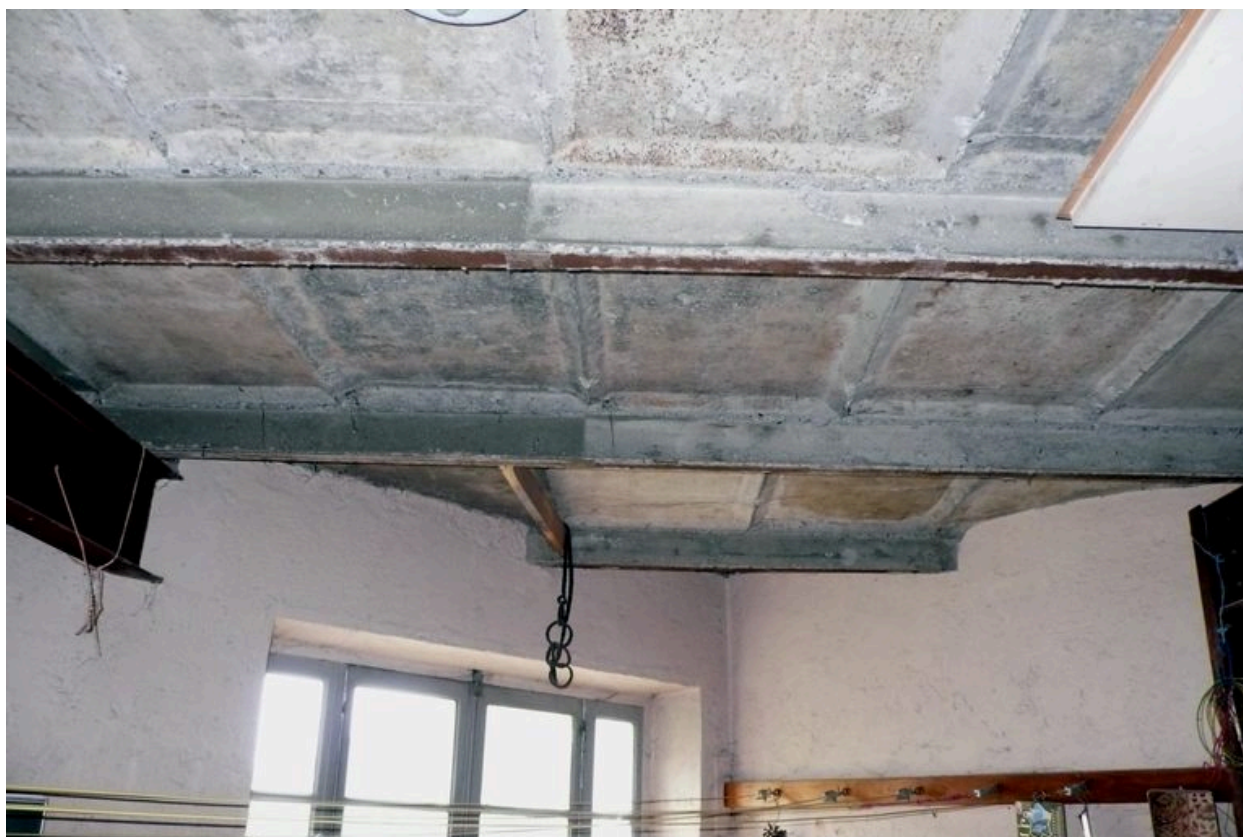
Etage de soubassement. Détail des dalles de béton du plafond
