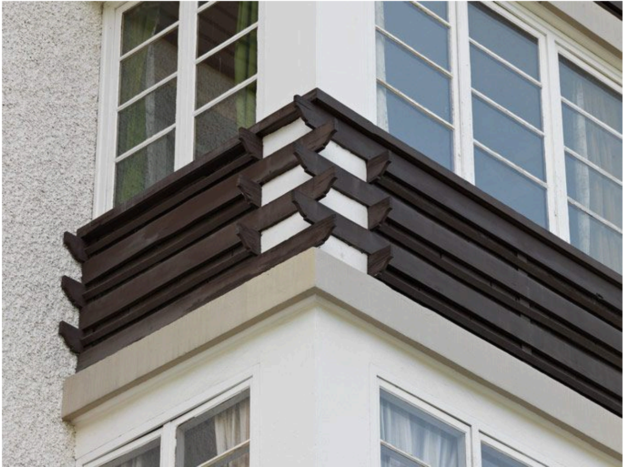
Détail d'une fenêtre d'angle
