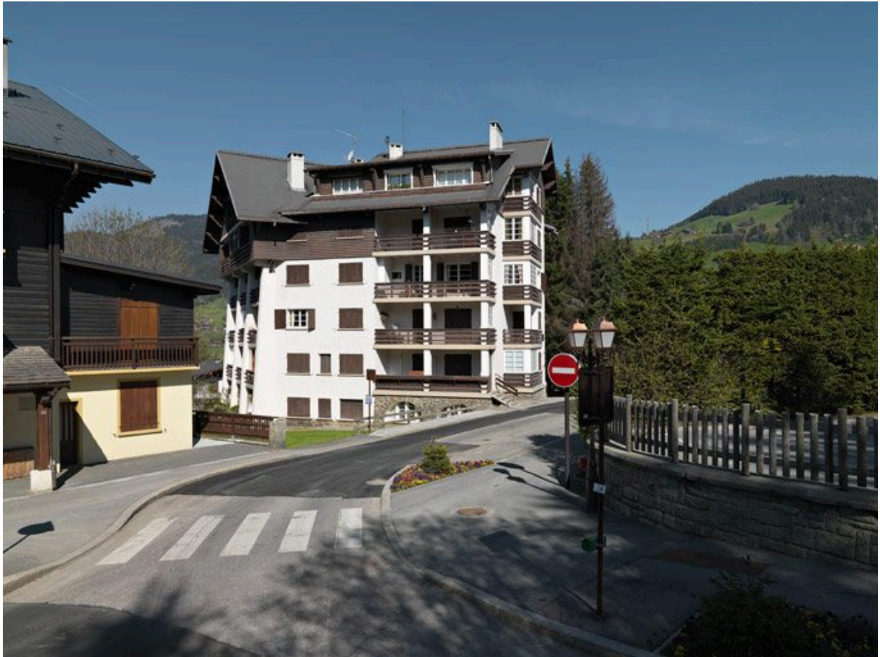
Vue depuis le sud
