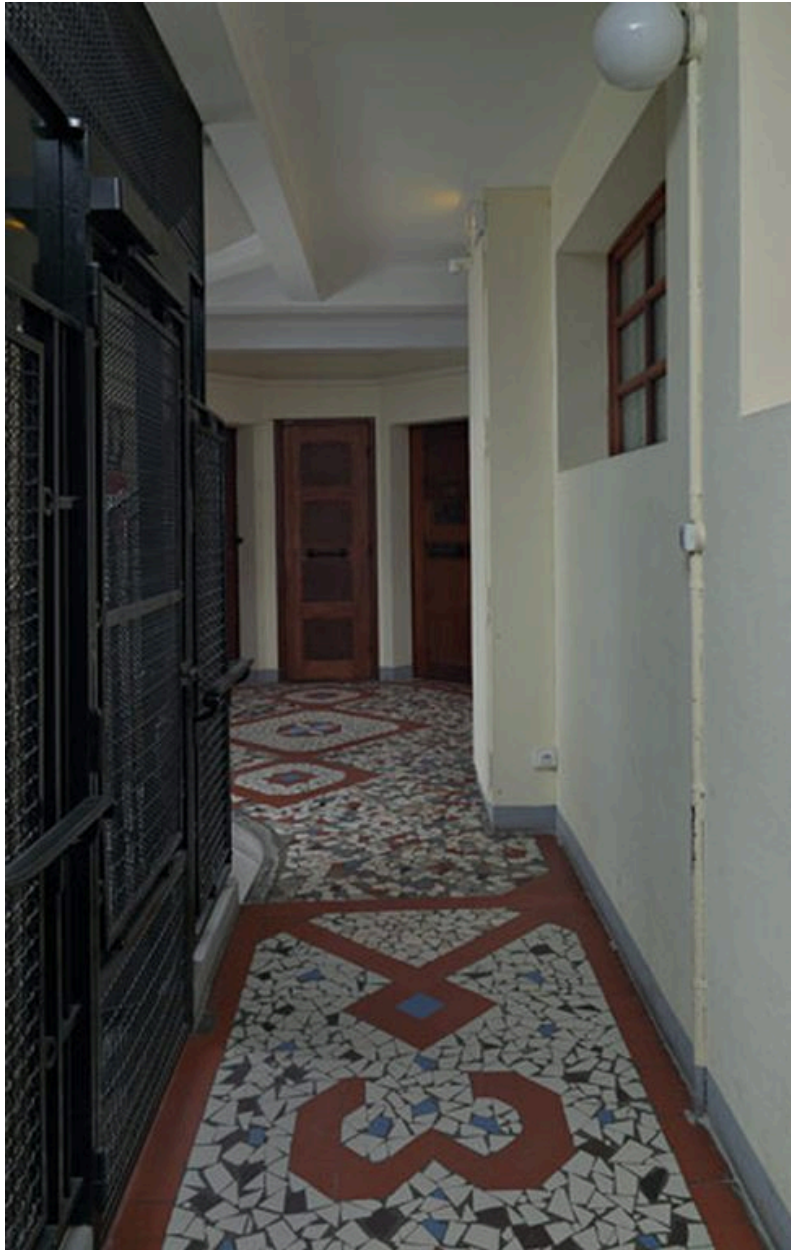
Vue d'ensemble du palier du 3e étage
