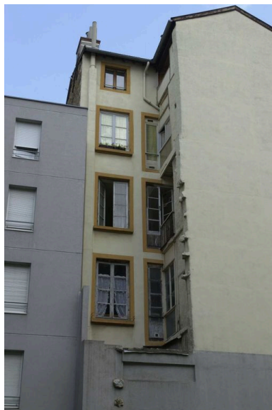
Elévation postérieure, partie sud IVR82_20026902831NUCA
