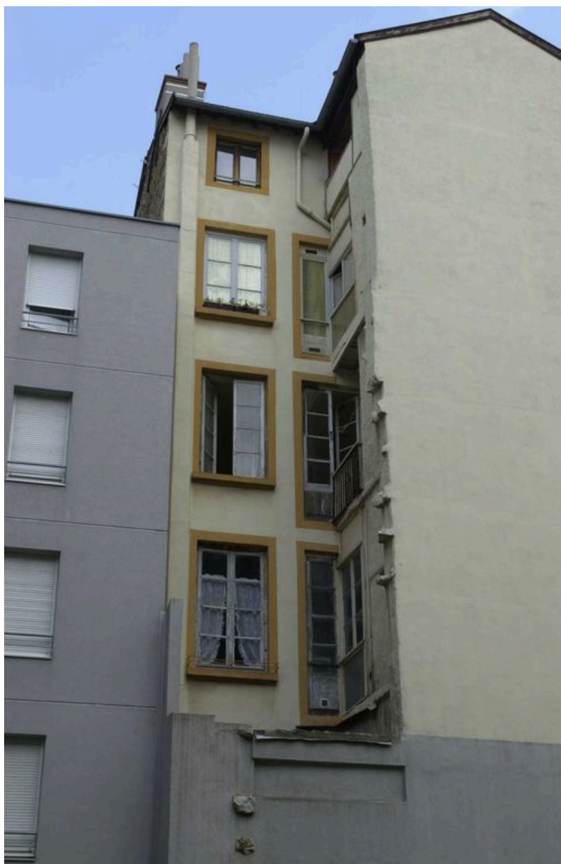
Elévation postérieure, partie sud
