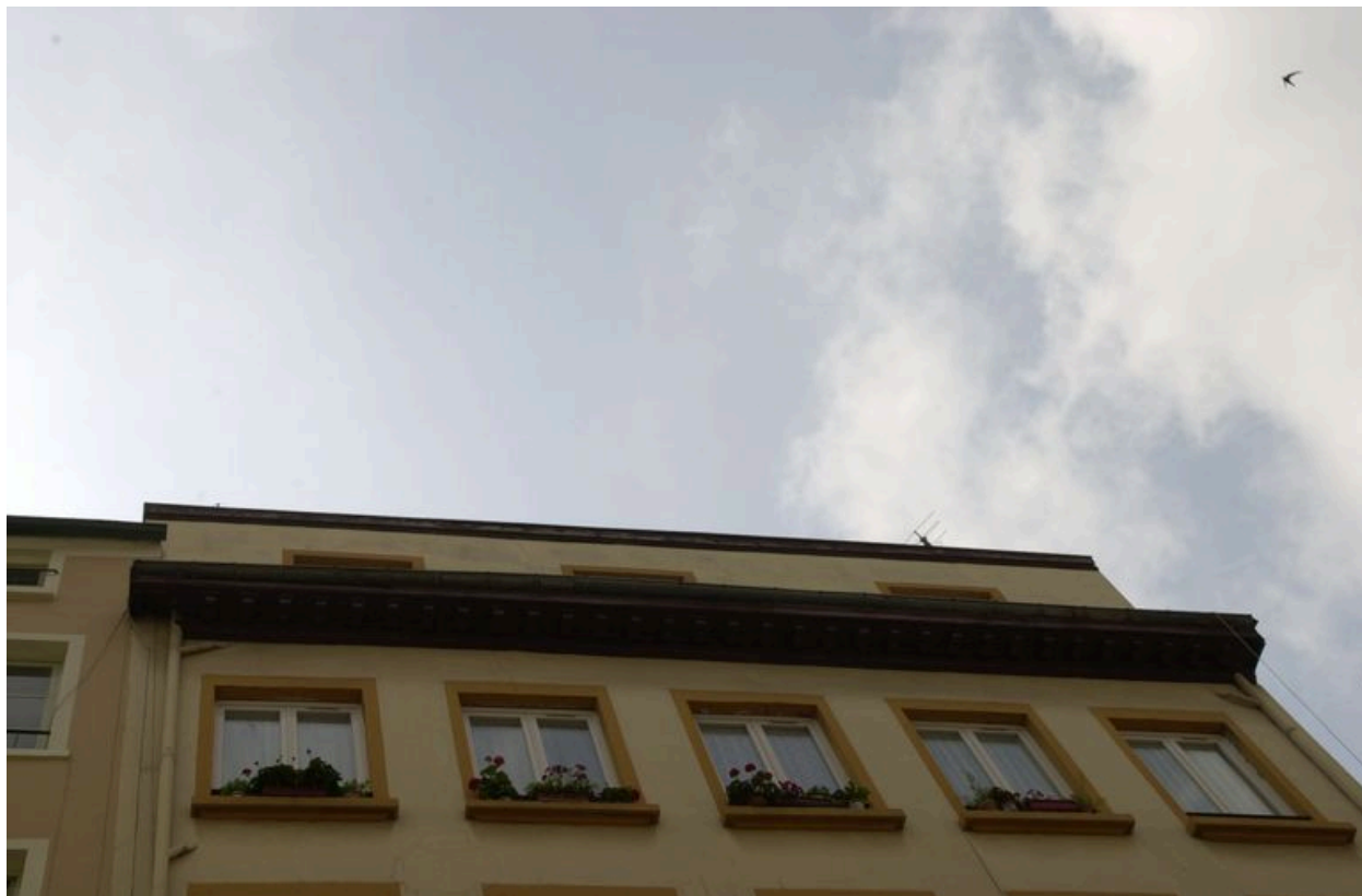
Détail de la surélévation
