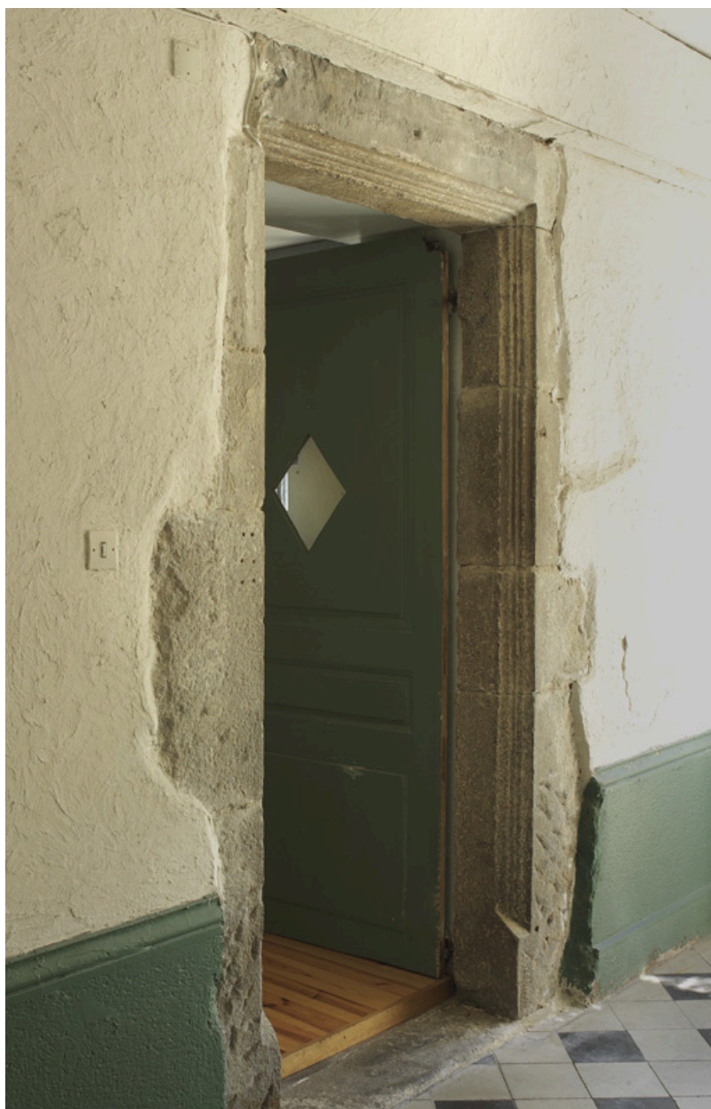
Porte intérieure à encadrement mouluré.
