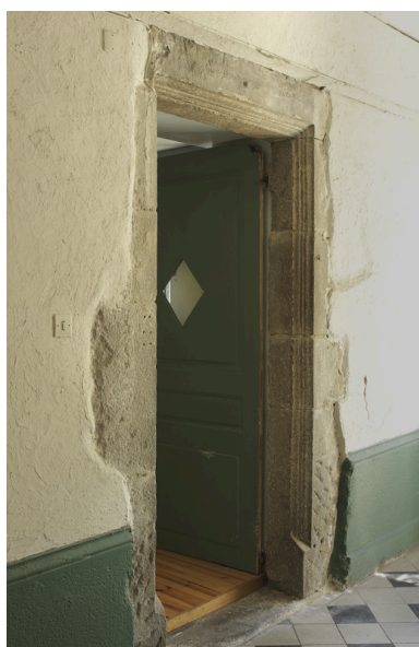
Porte intérieure à encadrement mouluré.
