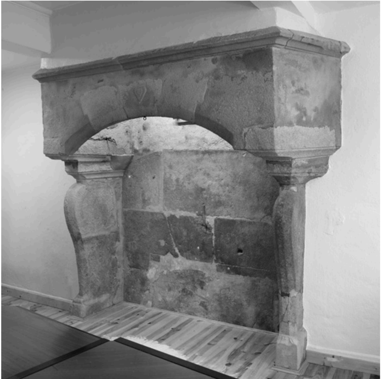
Cheminée de l'ancienne cuisine.
