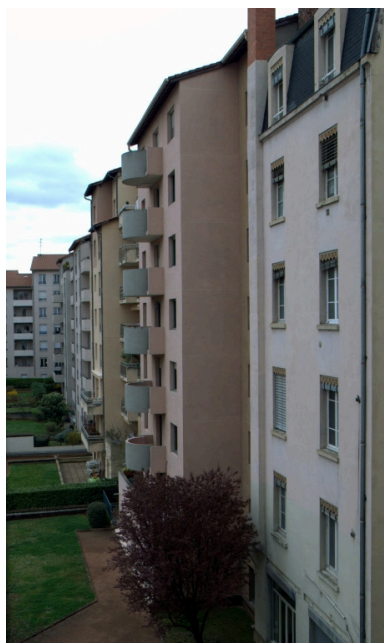
Elévation postérieure Phot. Maryannick Chalabi IVR82_20116905025NUCA
