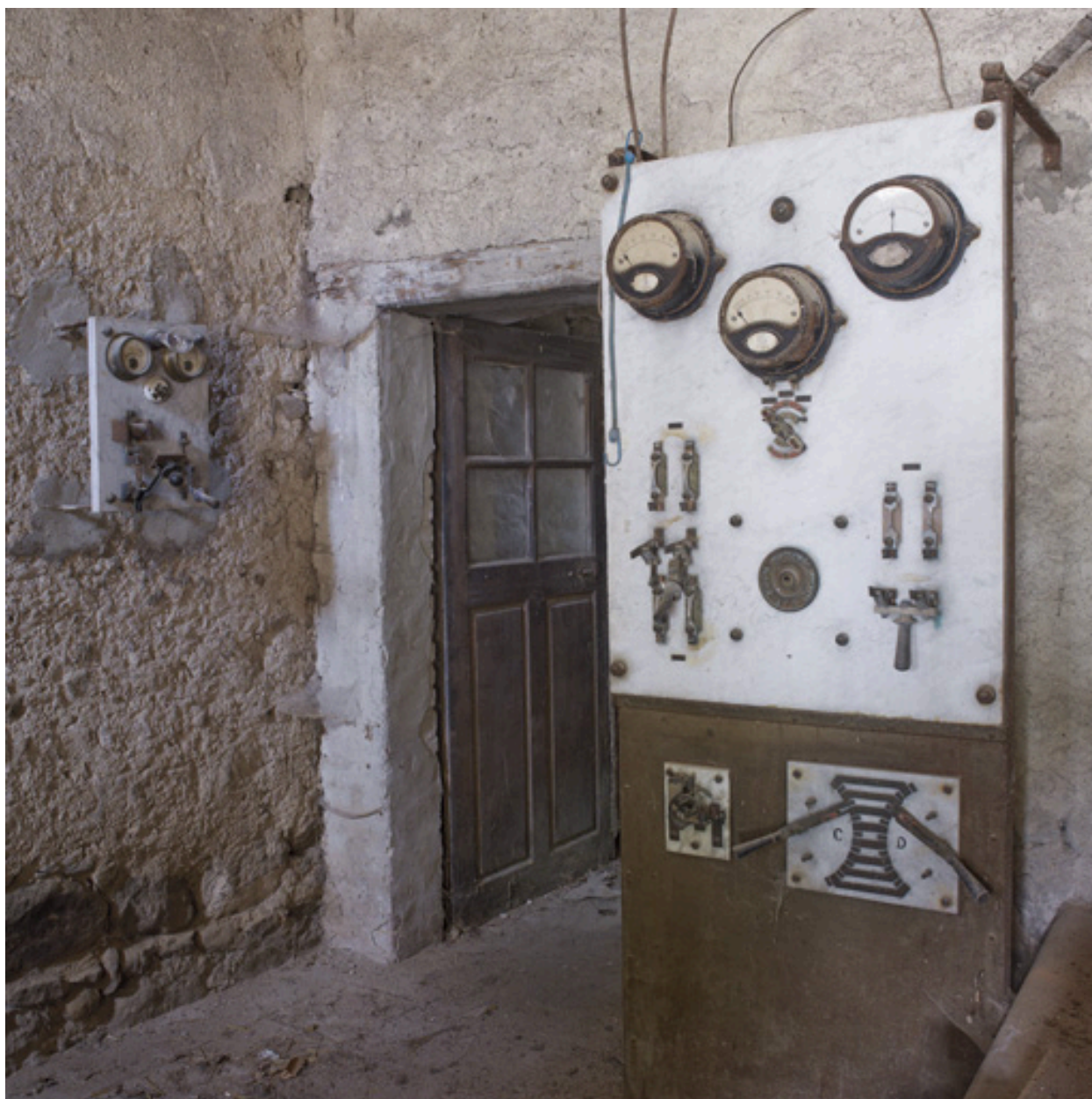
Vue intérieure : tableau électrique.
