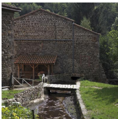
Vue de l'arrivée du bief. Phot. Didier Gourbin IVR82_20054201994NUCA
