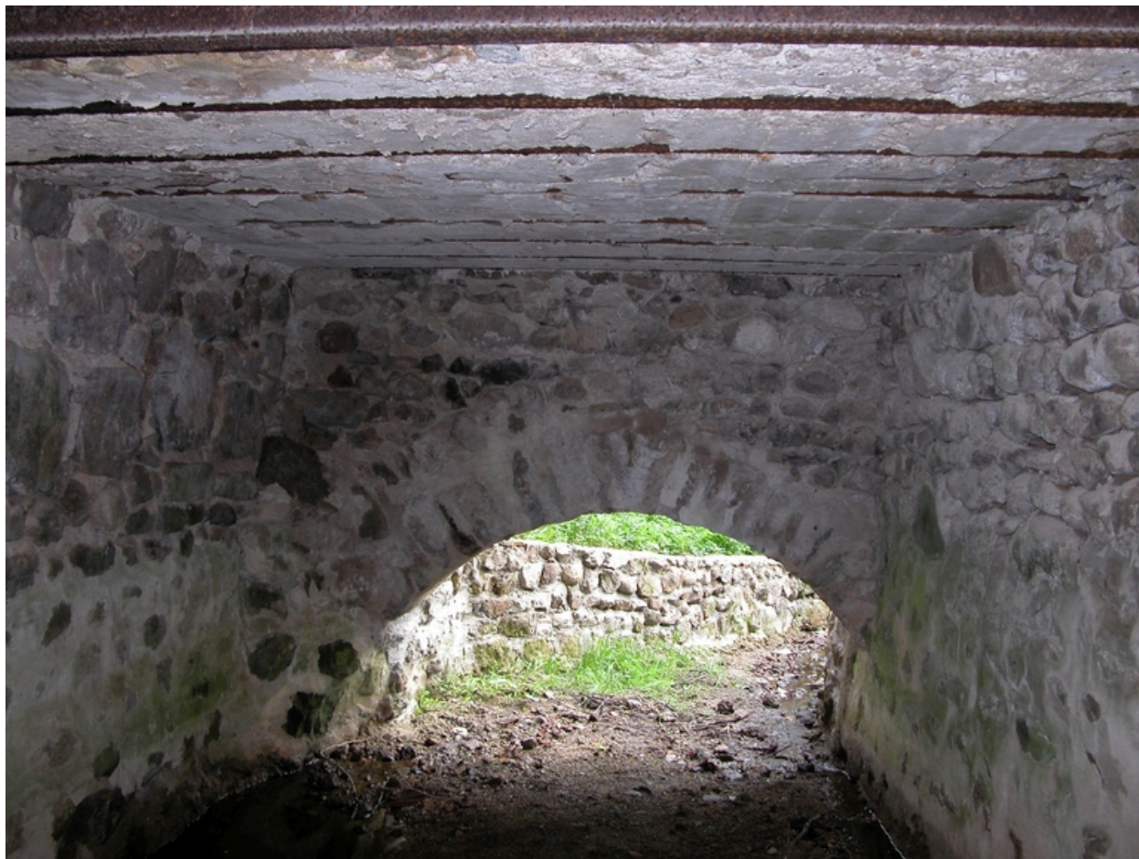
Vue du passage du bief.
