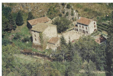
Vue aérienne du site en 1971. Phot. Didier Gourbin IVR82_20054202004NUCA
