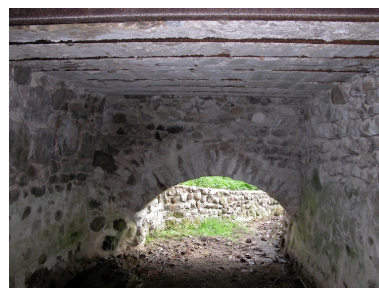
Vue du passage du bief. Phot. Thierry Monnet IVR82_20124202073NUCA
