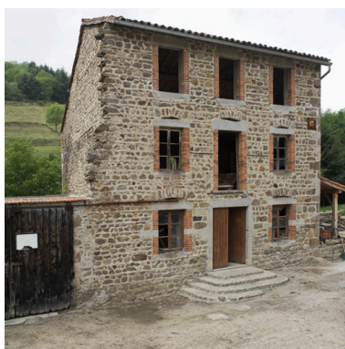
Vue d'ensemble. Phot. Didier Gourbin IVR82_20054201996NUCA
