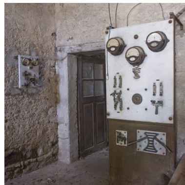
Vue intérieure : tableau électrique. Phot. Didier Gourbin IVR82_20054202000NUCA
