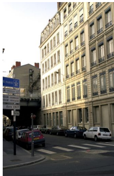
Vue d'ensemble, rue Claudius-Collonge Phot. Maryannick Chalabi IVR82_20016900323NUCA
