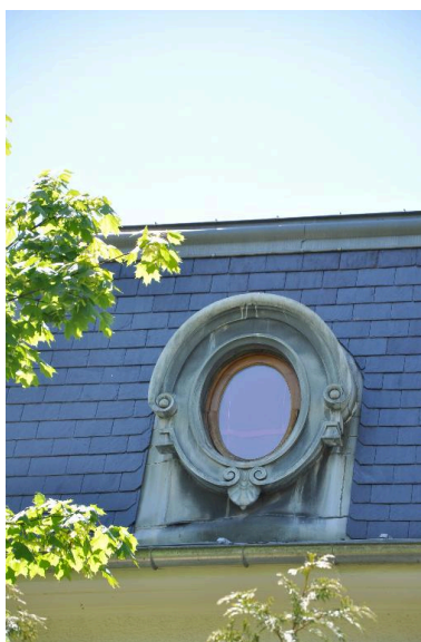
Détail sur un oeil-de- boeuf du brisis du toit Phot. Denys Harreau IVR82_20137300184NUCA
