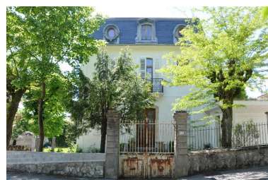
Façade principale orientée à l'est Phot. Denys Harreau IVR82_20137300182NUCA
