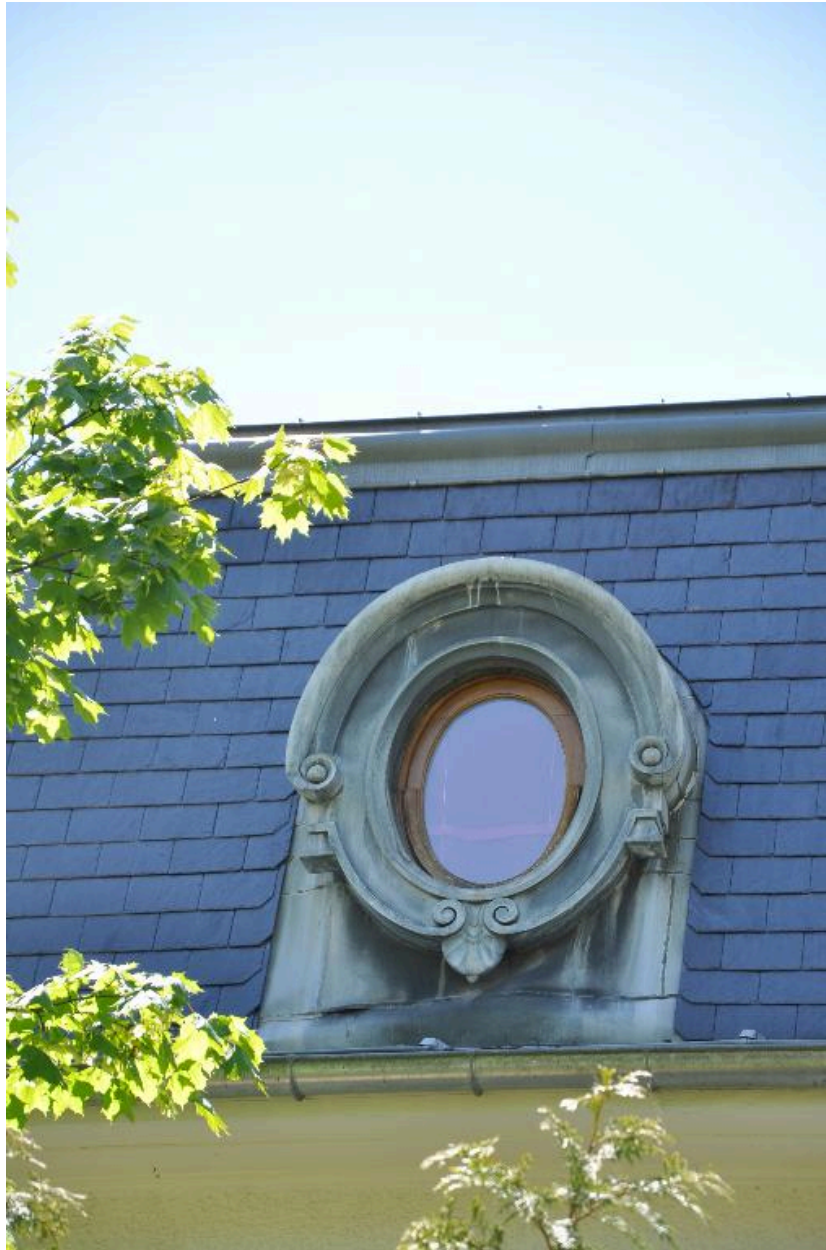
Détail sur un oeil-de-boeuf du brisis du toit
