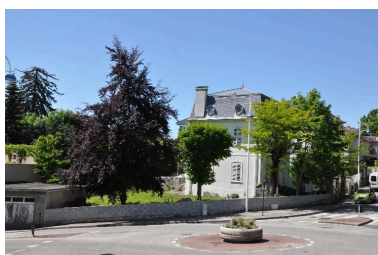
Vue d'ensemble depuis le sud-est Phot. Denys Harreau IVR82_20137300188NUCA
