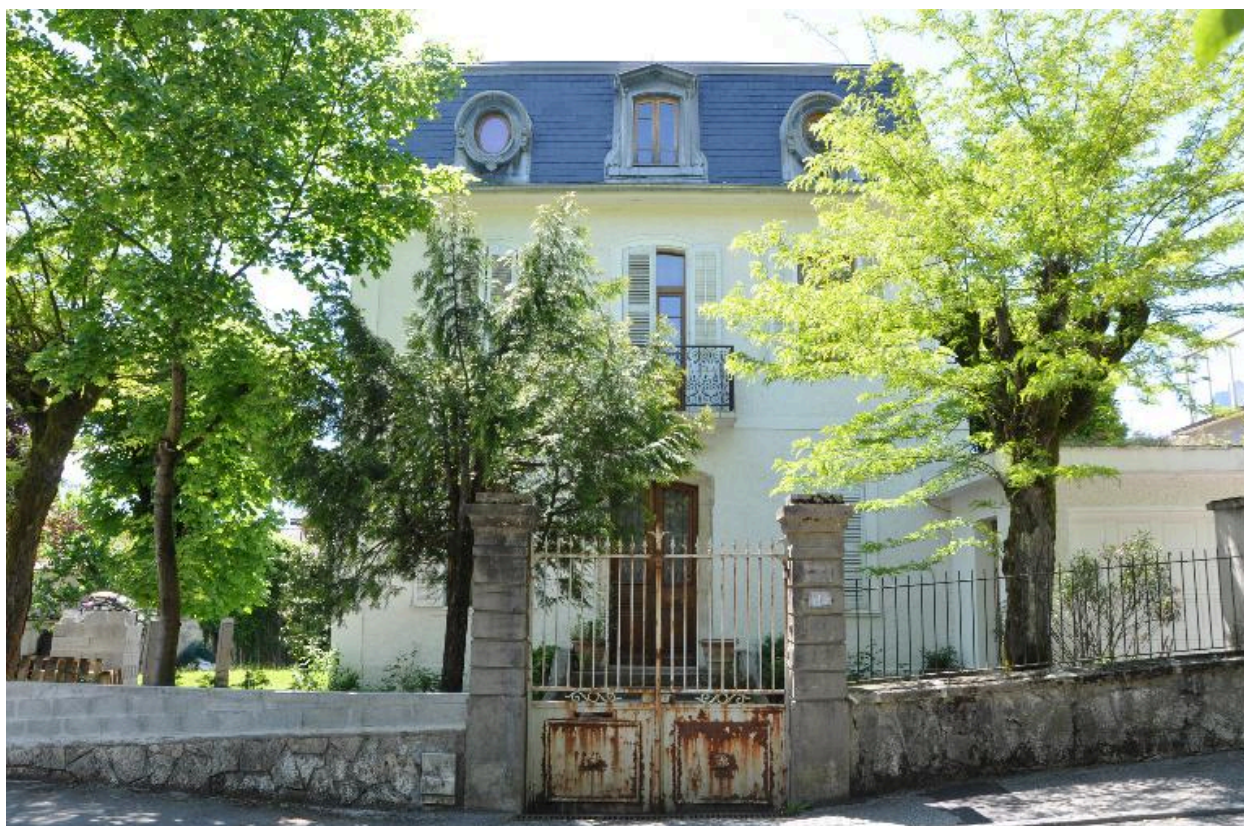
Façade principale orientée à l'est
