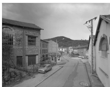
Usine d'enbouteillage des eaux minérales avec station de captage, bureaux et gazomètre à droite ; l'Astrée et la fontaine Font Fort à gauche. Phot. Eric Dessert IVR82_20034200447V
