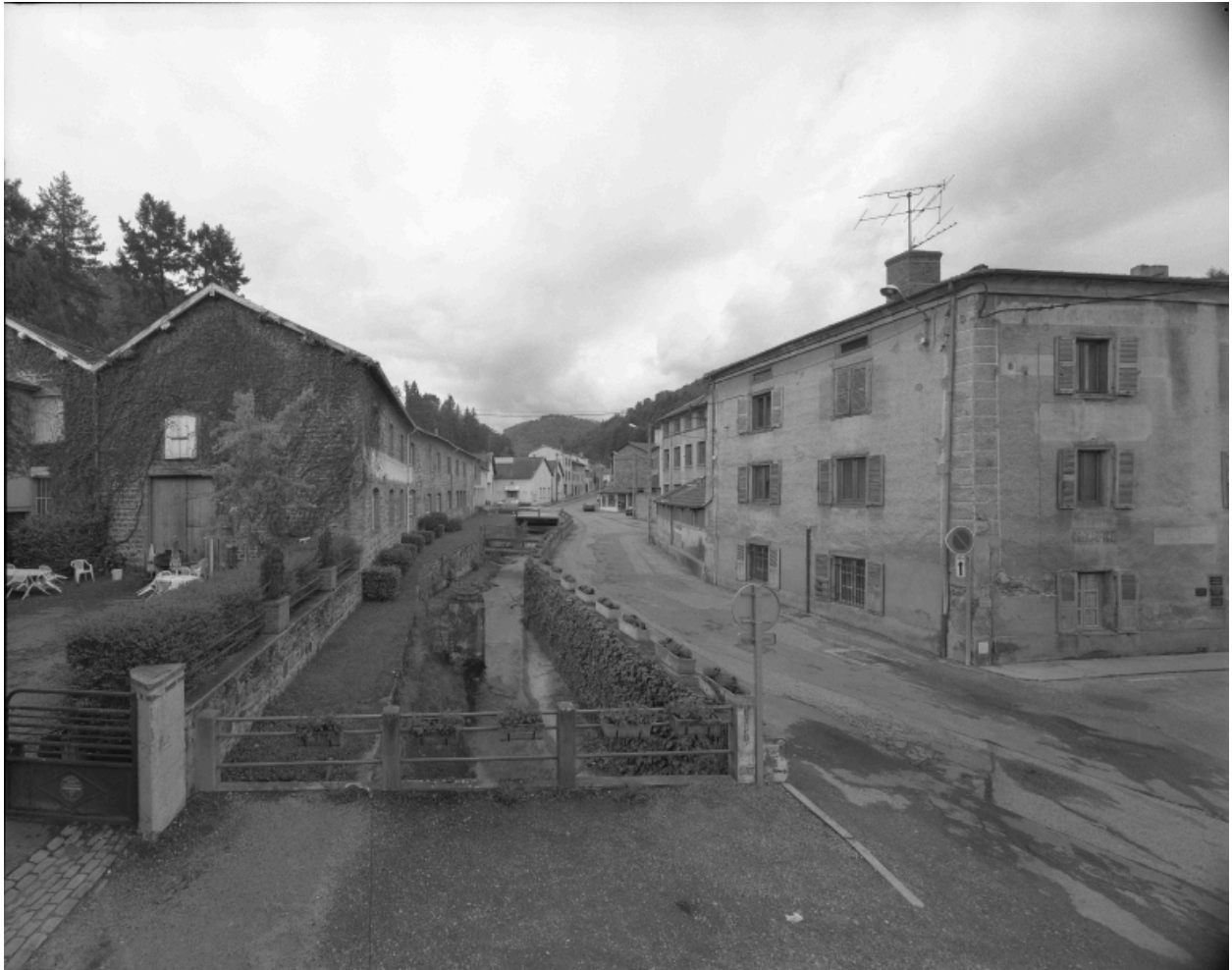
Vue d'ensemble du site de la Font Fort avec l'usine d'enbouteillage des eaux minérales à gauche de la rivière du Chagnon.
