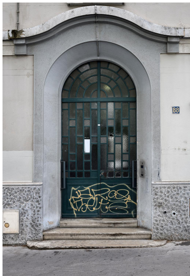
Elévation route de Vienne : la porte Phot. Thierry Leroy IVR84_20266900632NUCA
