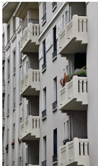
Elévation route de Vienne : vue partielle Phot. Thierry Leroy IVR84_20266900631NUCA
