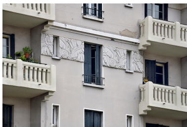
Elévation rue Auguste-Chollat : ornementation des 4e et 5e étages carrés Phot. Thierry Leroy IVR84_20266900629NUCAQ
