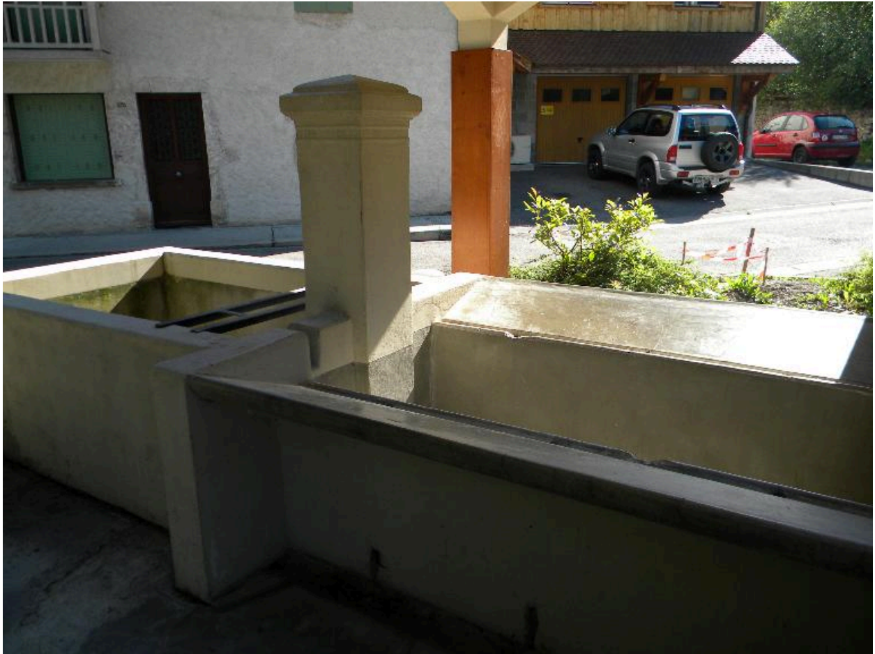
Vue rapprochée du lavoir couvert.
