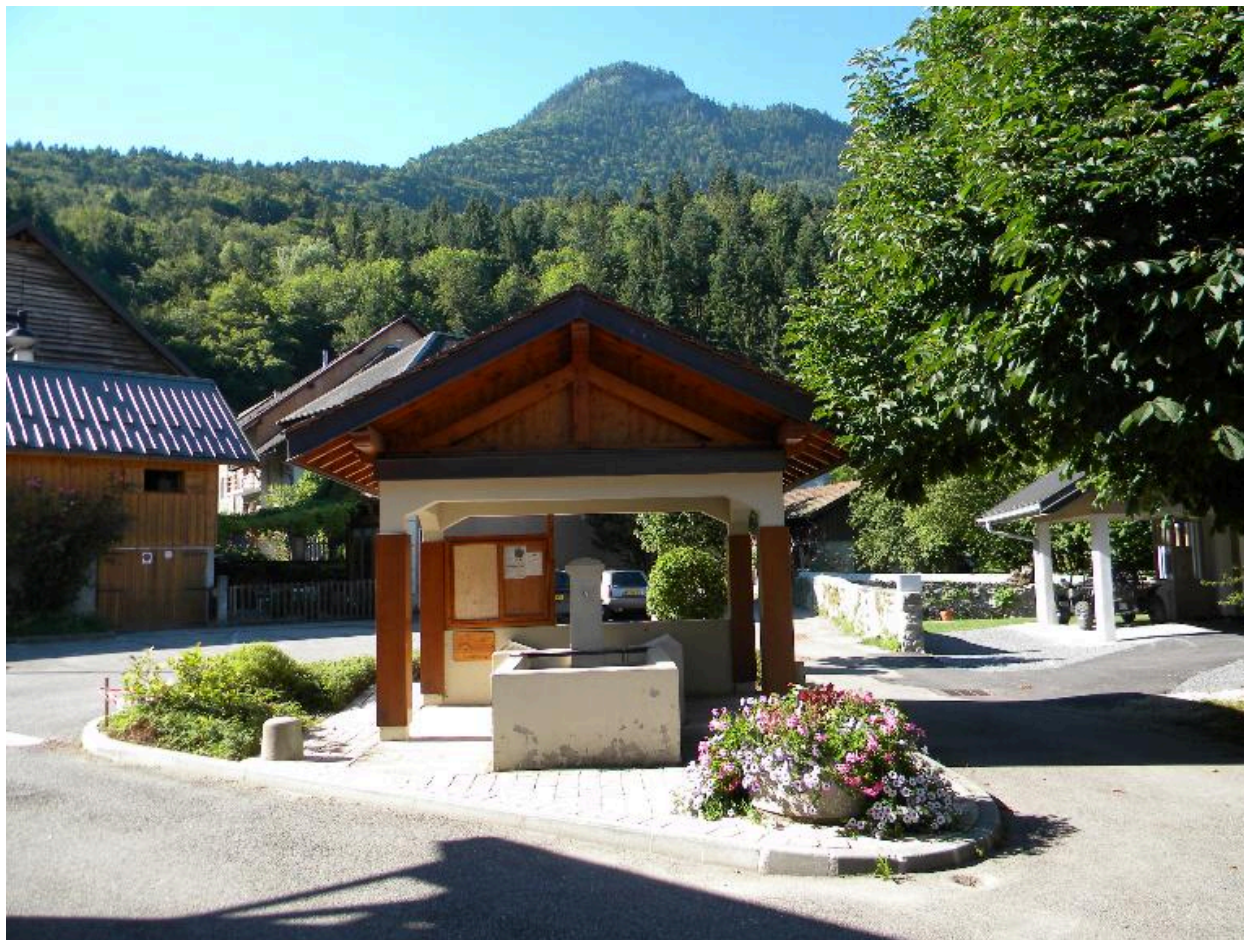
Vue d'ensemble du lavoir couvert.
