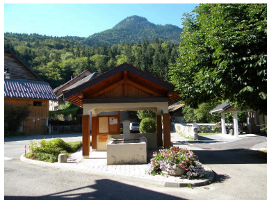
Vue d'ensemble du lavoir couvert. Phot. Jérôme Daviet IVR82_20137401088NUCA
