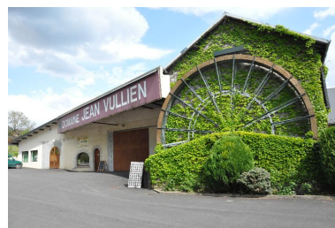
Vue du site. Façade ouest. Phot. Clara Bérelle IVR82_20147302827NUCA
