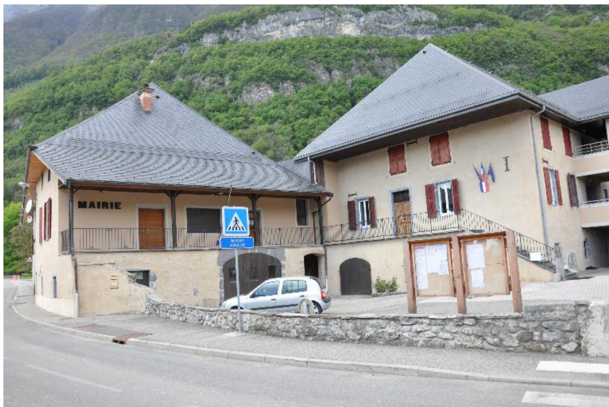
Façade est du bâtiment, une partie est occupée par la mairie de Fréterive.
