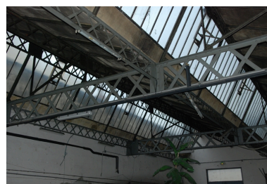
Détail poutre métallique à croisillons Phot. Nadine Halitim-Dubois IVR82_20126900436NUCA
