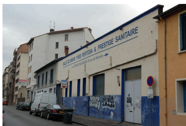
Vue générale nord Phot. Nadine Halitim-Dubois IVR82_20106900546NUCA
