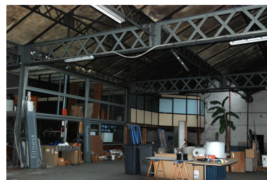
Vue d'ensemble des ateliers avec structure métallique en charpente Phot. Nadine Halitim-Dubois IVR82_20126900433NUCA
