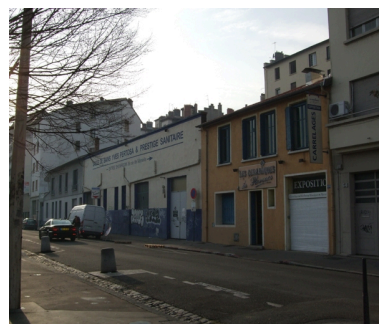
Vue d'ensemble nord Phot. Nadine Halitim-Dubois IVR82_20106900545NUCA
