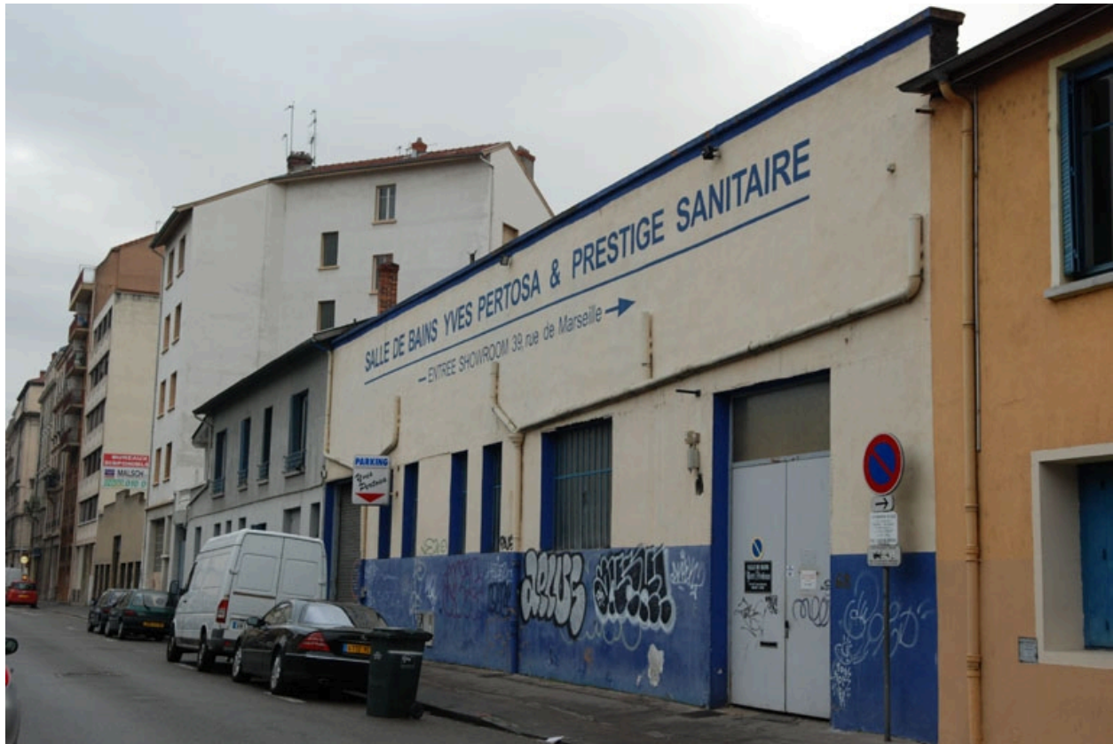
Vue générale nord
