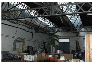
Détail charpente Phot. Nadine Halitim-Dubois IVR82_20126900434NUCA
