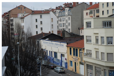
Vue nord-est : shed en toiture Phot. Nadine Halitim-Dubois IVR82_20126900431NUCA
