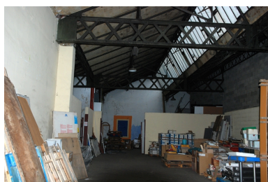
Vue intérieur des ateliers Phot. Nadine Halitim-Dubois IVR82_20126900432NUCA
