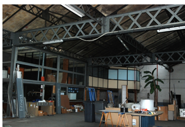
Vue d'ensemble des ateliers avec structure métallique en charpente Phot. Nadine Halitim-Dubois IVR82_20126900433NUCA
