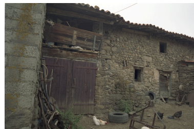
Façade antérieure du logis et de l'étable, depuis la cour. Phot. Thierry Monnet IVR82_20034201893ZE
