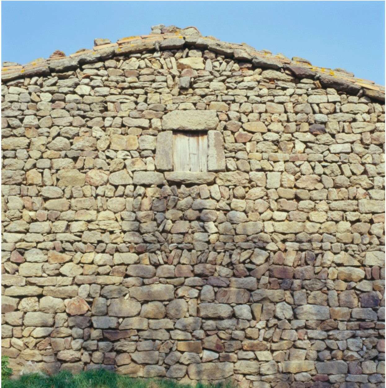
Détail du pignon sud-ouest.
