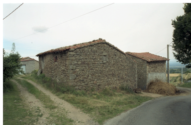
Vue d'ensemble depuis l'ouest. Phot. Thierry Monnet IVR82_20034201892ZE
