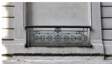
Vue d'un garde-corps Phot. Catherine Guégan IVR82_20116902016NUCA
