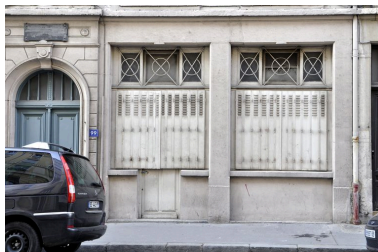
Vue du rez-de-chaussée (ancienne boutique) Phot. Catherine Guégan IVR82_20116902011NUCA
