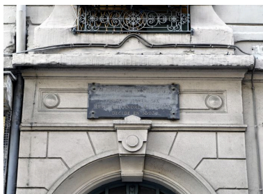
Détail de la plaque fixée au dessus de la porte d'entrée Phot. Catherine Guégan IVR82_20116902014NUCA
