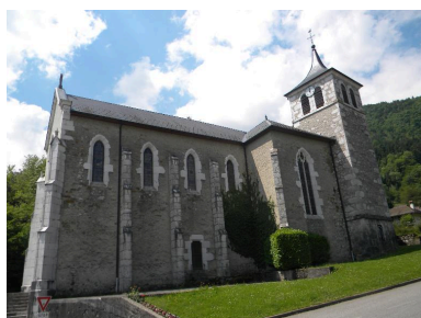
Vue d'ensemble. Phot. Jérôme Daviet IVR82_20147400274NUCA
