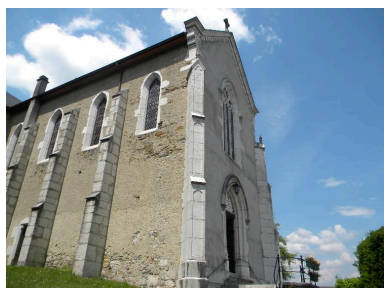
Vue de trois-quarts de l'église depuis la place de la mairie. Phot. Jérôme Daviet IVR82_20147400276NUCA
