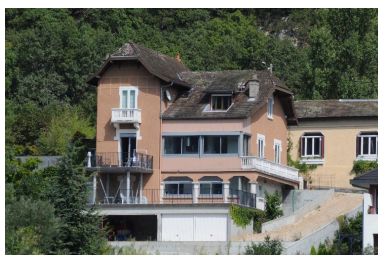
Vue d'ensemble Phot. Denys Harreau IVR82_20157301036NUCA
