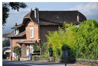
Vue d'ensemble depuis le nord Phot. Denys Harreau IVR82_20137300753NUCA
