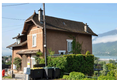
Vue de trois-quart droit Phot. Denys Harreau IVR82_20137300754NUCA
