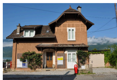
Elévation sur rue Phot. Denys Harreau IVR82_20137300755NUCA
