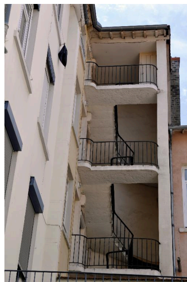
Vue partielle de l'escalier hors-oeuvre à cage ouverte Phot. Catherine Guégan IVR84_20176901345NUCA
