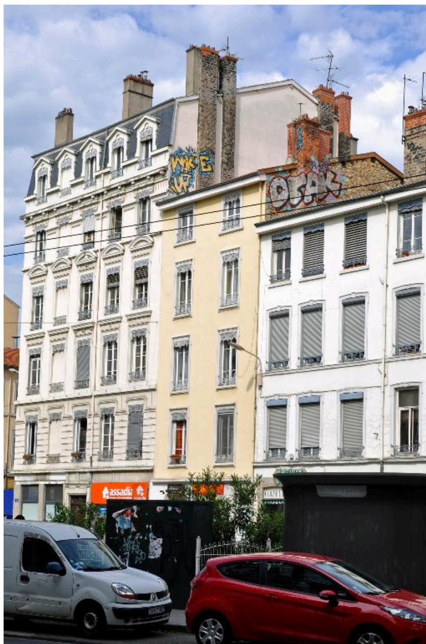
Vue du nord-ouest, montrant la maçonnerie de moellons apparente sur le mur pignon
