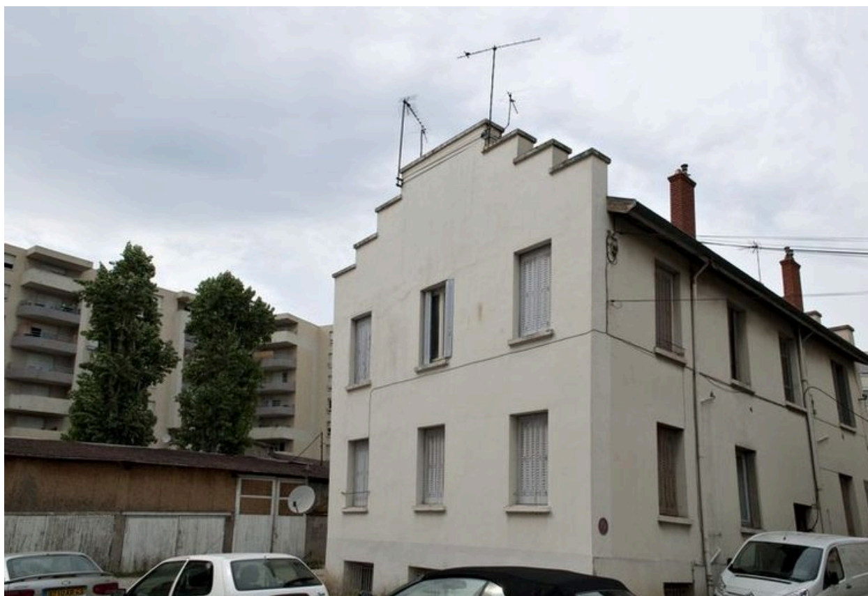
Seconde maison : façade latérale et façade antérieure
