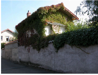
Vue générale Phot. Thierry Monnet IVR82_20134200250NUCA
