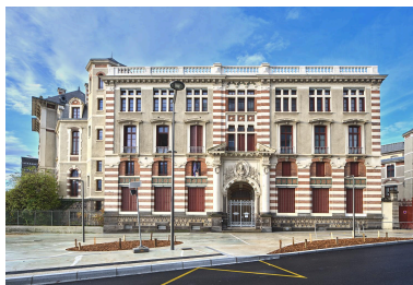
Elévation principale Phot. Franck Trabouillet IVR84_20256302328NUCA
