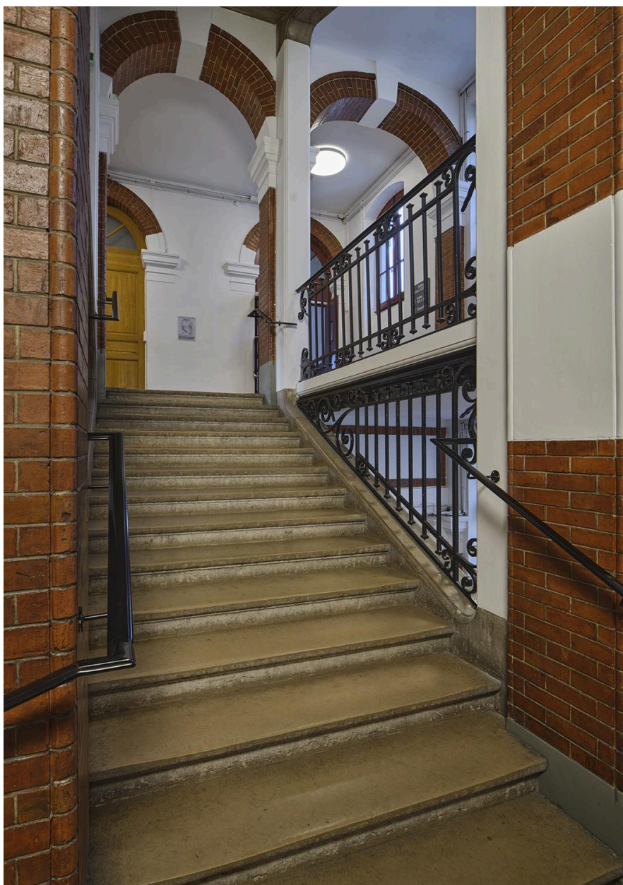
Escalier est : 2ème volée et palier
