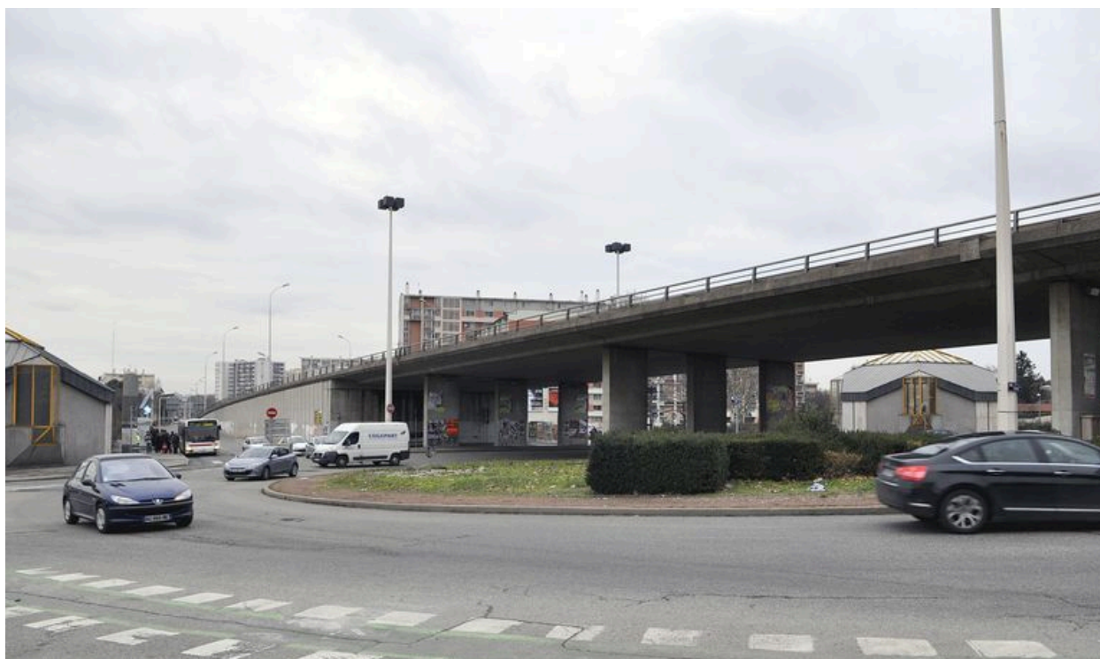
Vue en situation depuis le rond-point du boulevard Pinel
