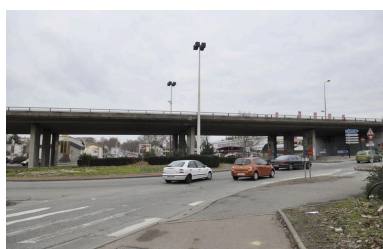
Vue en situation au dessus du rond-point. Phot. Julien Defillon IVR82_20106900837NUCA
