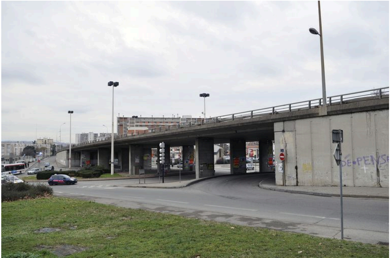
Vue en situation depuis le sud-est
