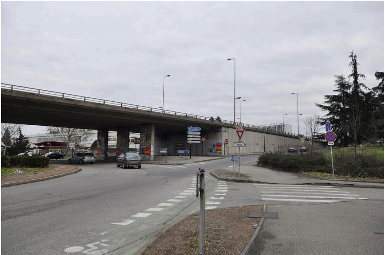
Vue en situation depuis le rond-point du boulevard Pinel
