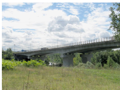
Vue générale, face amont (depuis la rive droite) Phot. I. Havard IVR82_20100100303NUCA
