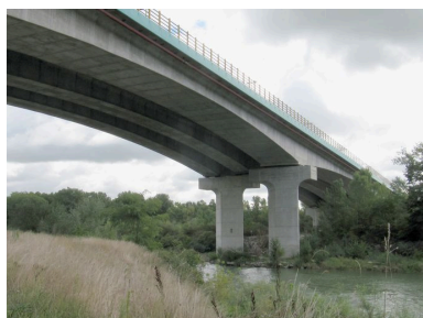
Vue générale, face aval (depuis la rive droite) Phot. I. Havard IVR82_20100100306NUCA
