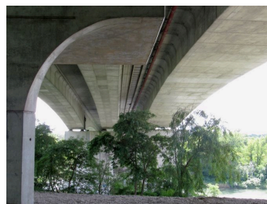
Tablier vu de dessous (depuis la rive droite) Phot. I. Havard IVR82_20100100307NUCA
