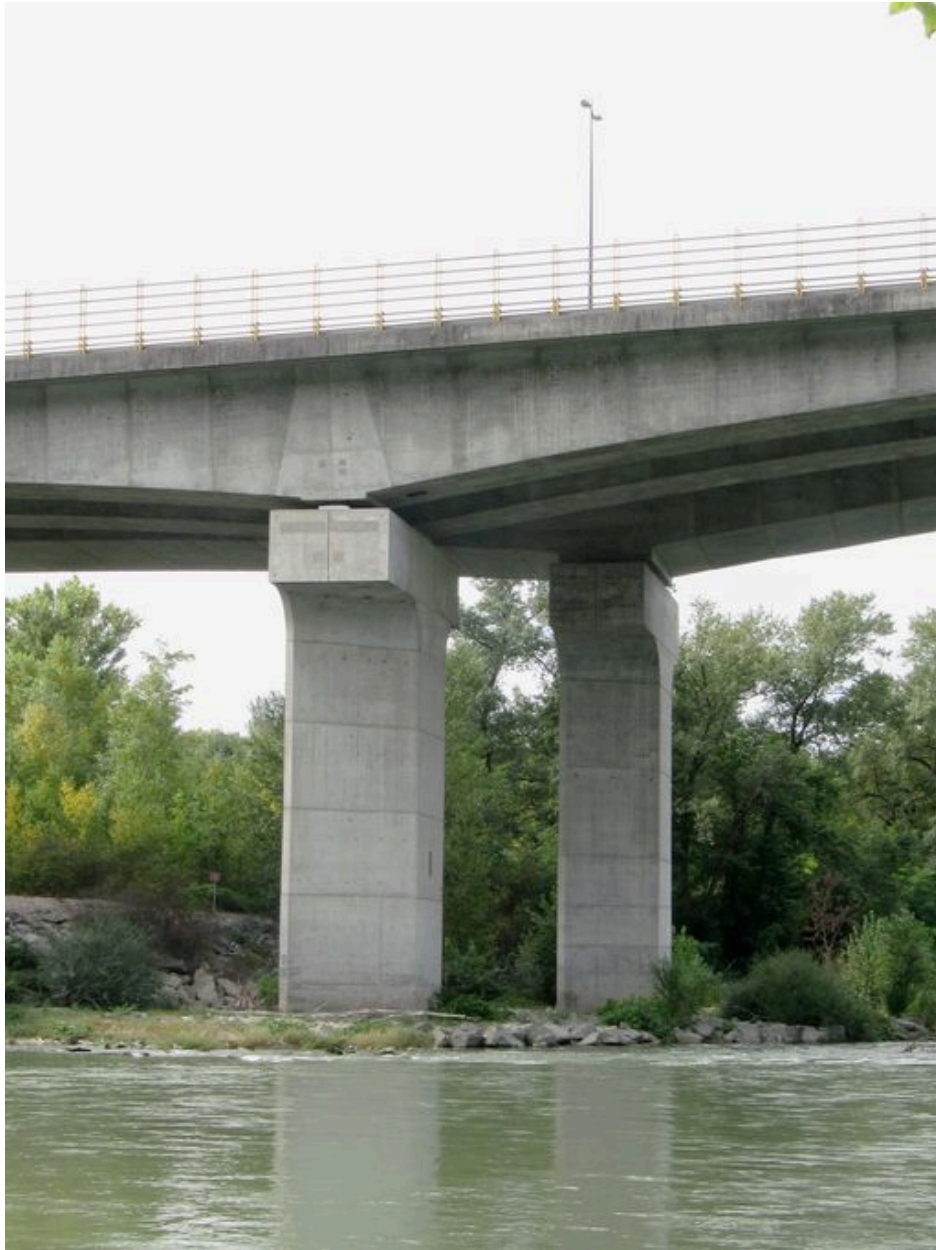
Piles, face amont (depuis la rive gauche)
