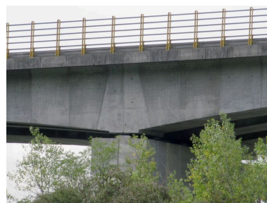
Tablier, vue partielle, face amont (depuis la rive droite) Phot. I. Havard IVR82_20100100305NUCA
