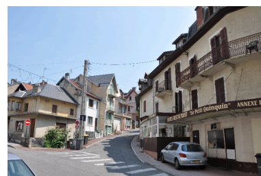
Le Petit Quinquin et son annexe, vue générale Phot. François Fouger IVR82_20107301279NUCA
