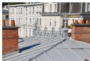
Crête de toit Phot. François Fouger IVR82_20127301061NUCA
