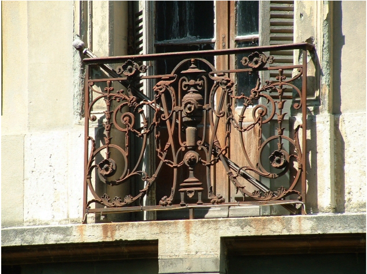
Détail d'un garde-corps
