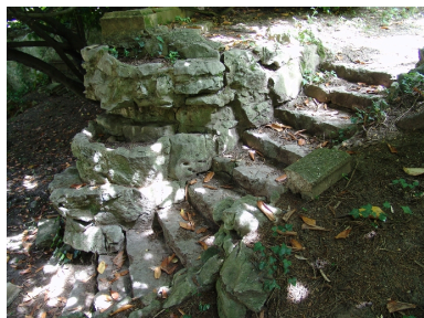
Escalier du jardin avec jardinière Phot. François Fouger IVR82_20087300463NUCA
