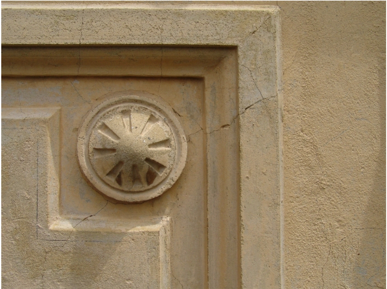
Décor de la façade, détail
