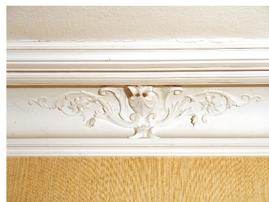
Plafond d'une pièce du rez-de- chaussée, détail de l'adoucissement Phot. François Fouger IVR82_20087300483NUCA
