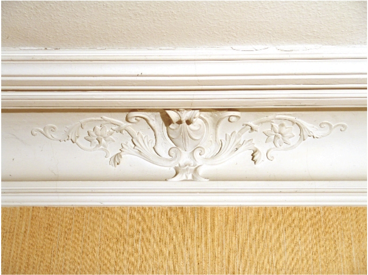
Plafond d'une pièce du rez-de-chaussée, détail de l'adoucissement
