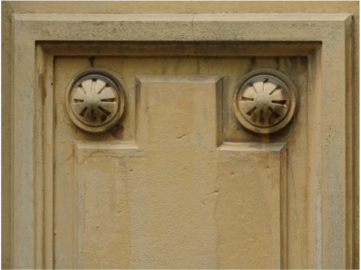
Décor de la façade, détail
