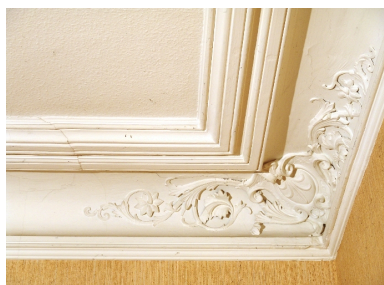
Plafond d'une pièce du rez-de-chaussée Phot. François Fouger IVR82_20087300480NUCA
