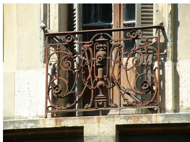
Détail d'un garde-corps Phot. François Fouger IVR82_20067300607NUCA
