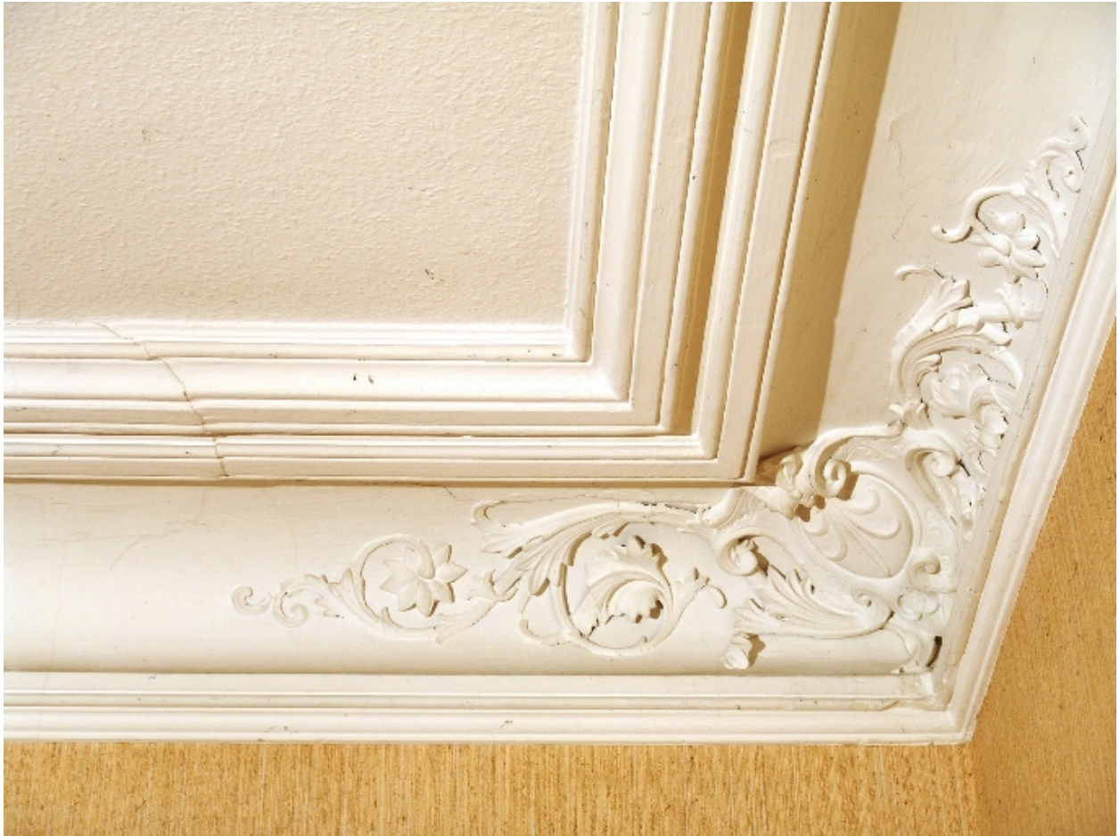
Plafond d'une pièce du rez-de-chaussée
