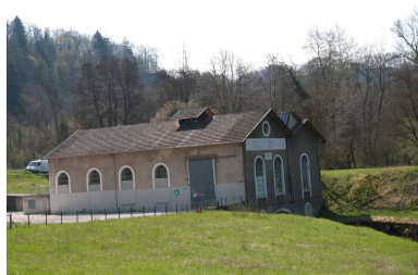
Vue du mur goutte de la seconde travée prise depuis les berges du Fier Phot. Samir Mahfoudi, Autr. Samir Mahfoudi IVR82_20107400340NUCA
