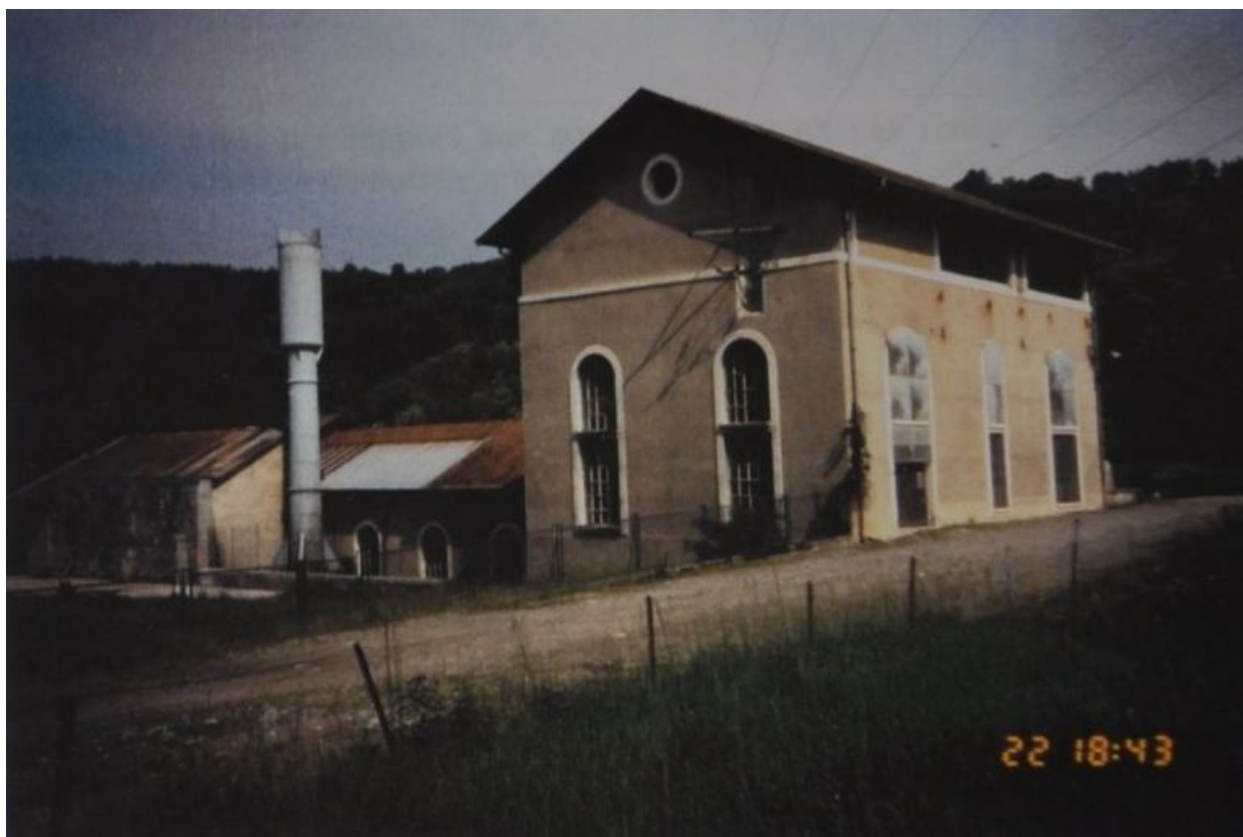
La Centrale de Brassilly.1993. Photo. © Archives Direction départementale de l'Équipement et de l'Agriculture de Haute-Savoie. Carton Brassilly
