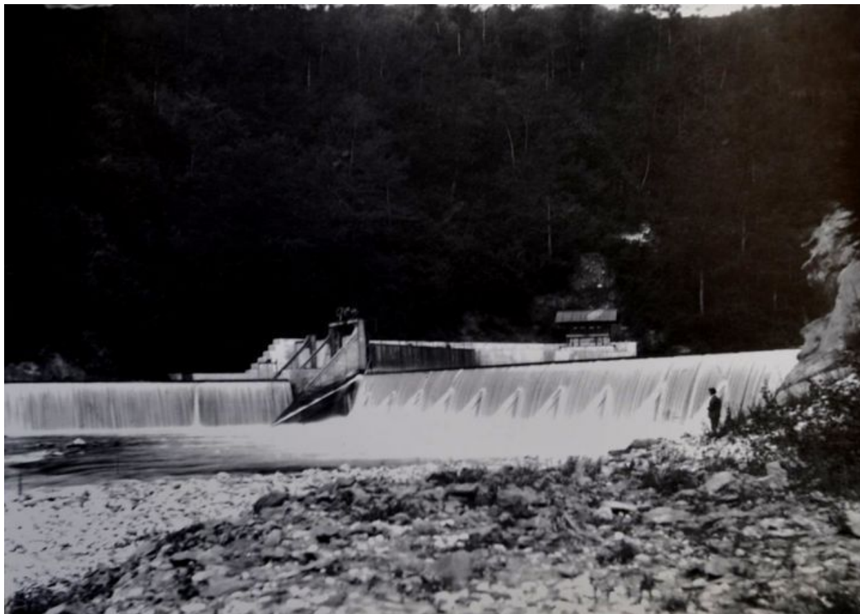
Mise en eau du Barrage.1904
