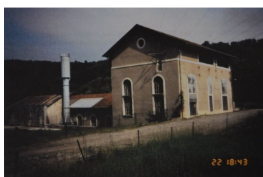
La Centrale de Brassilly.1993. Photo. © Archives Direction départementale de l'Équipement et de l'Agriculture de Haute-Savoie. Carton Brassilly Phot. Samir Mahfoudi, Autr. Direction départementale de l'Équipement et de l'Agriculture de Haute-Savoie IVR82_20107400330NUCA
