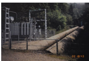
Arrivée des conduites forcées à la centrale.1993. Photo. © Archives Direction départementale de l'Équipement et de l'Agriculture de Haute-Savoie. Carton Brassilly Phot. Samir Mahfoudi, Autr. Direction départementale de l'Équipement et de l'Agriculture de Haute-Savoie IVR82_20107400331NUCA
