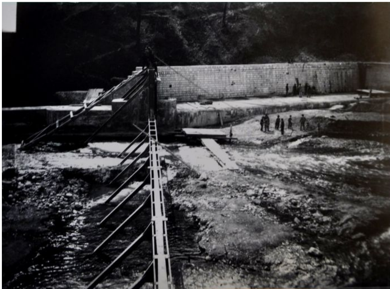
Autre vue de l'armature métallique du seuil. 1904
