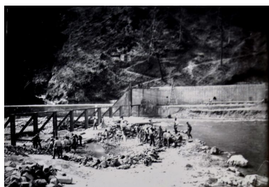
Vue de l'armature métallique du seuil. 1904 Phot. Samir Mahfoudi, Autr. Association Cran au File de l'Eau IVR82_20107400301NUCA
