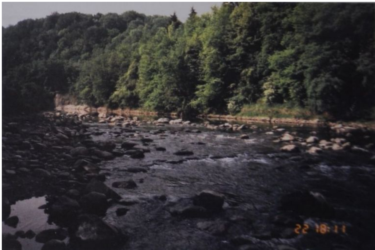
Station 1, Amont retenue de Brassilly.1993. Photo. © Archives Direction départementale de l'Équipement et de l'Agriculture de Haute-Savoie. Carton Brassilly
