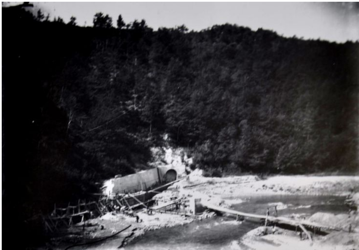
Construction du Barrage à Cran-Gevrier. 1904
