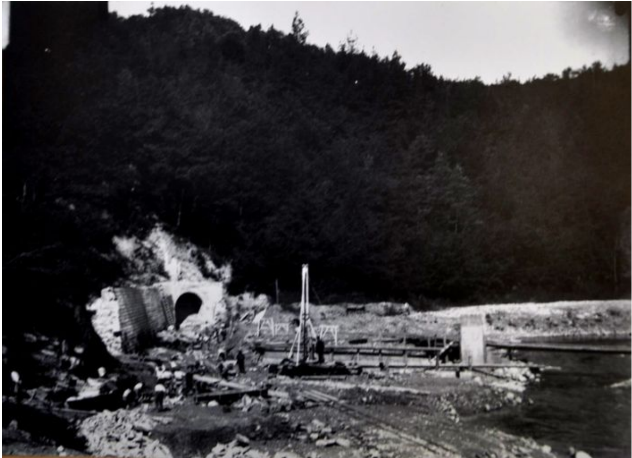
Autre vue de la construction du Barrage.1904
