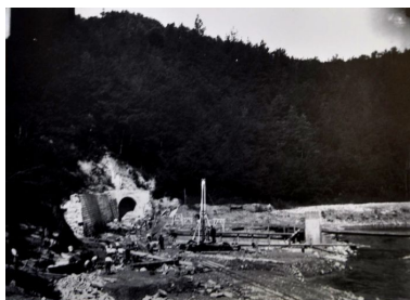
Autre vue de la construction du Barrage. 1904 Phot. Samir Mahfoudi, Autr. Association Cran au File de l'Eau IVR82_20107400299NUCA
