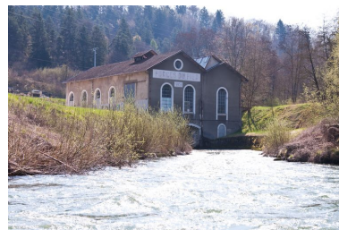
Les deux halles principales prises depuis les berges du Fier Phot. Samir Mahfoudi, Autr. Samir Mahfoudi IVR82_20107400342NUCA
