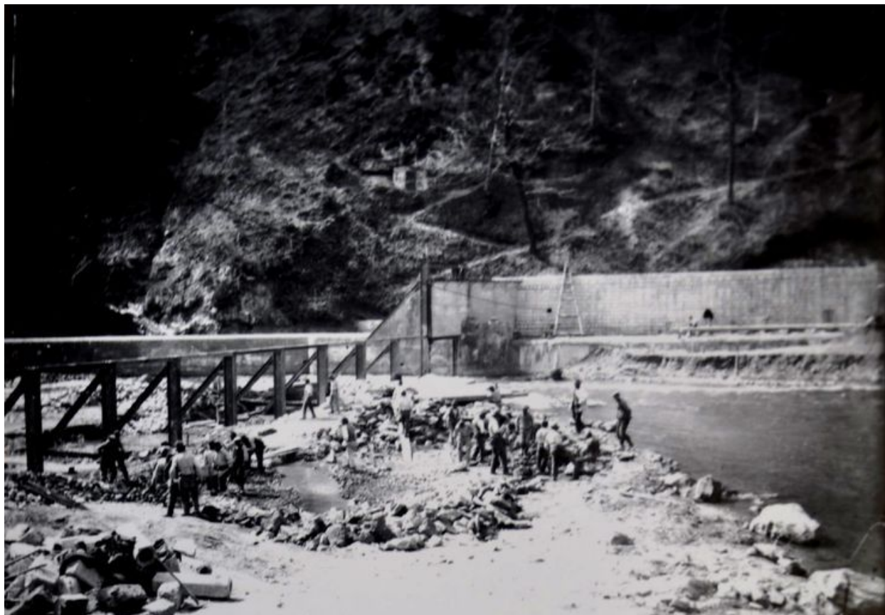
Vue de l'armature métallique du seuil. 1904
