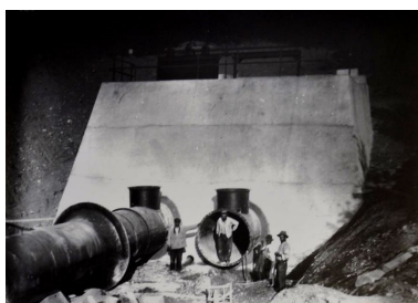
Salle de mise en charge et conduites forcées. 1904 Phot. Samir Mahfoudi, Autr. Association Cran au File de l'Eau IVR82_20107400305NUCA
