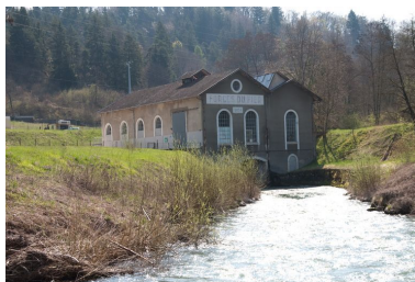
Vue générale Phot. Samir Mahfoudi, Autr. Samir Mahfoudi IVR82_20107400341NUCA
