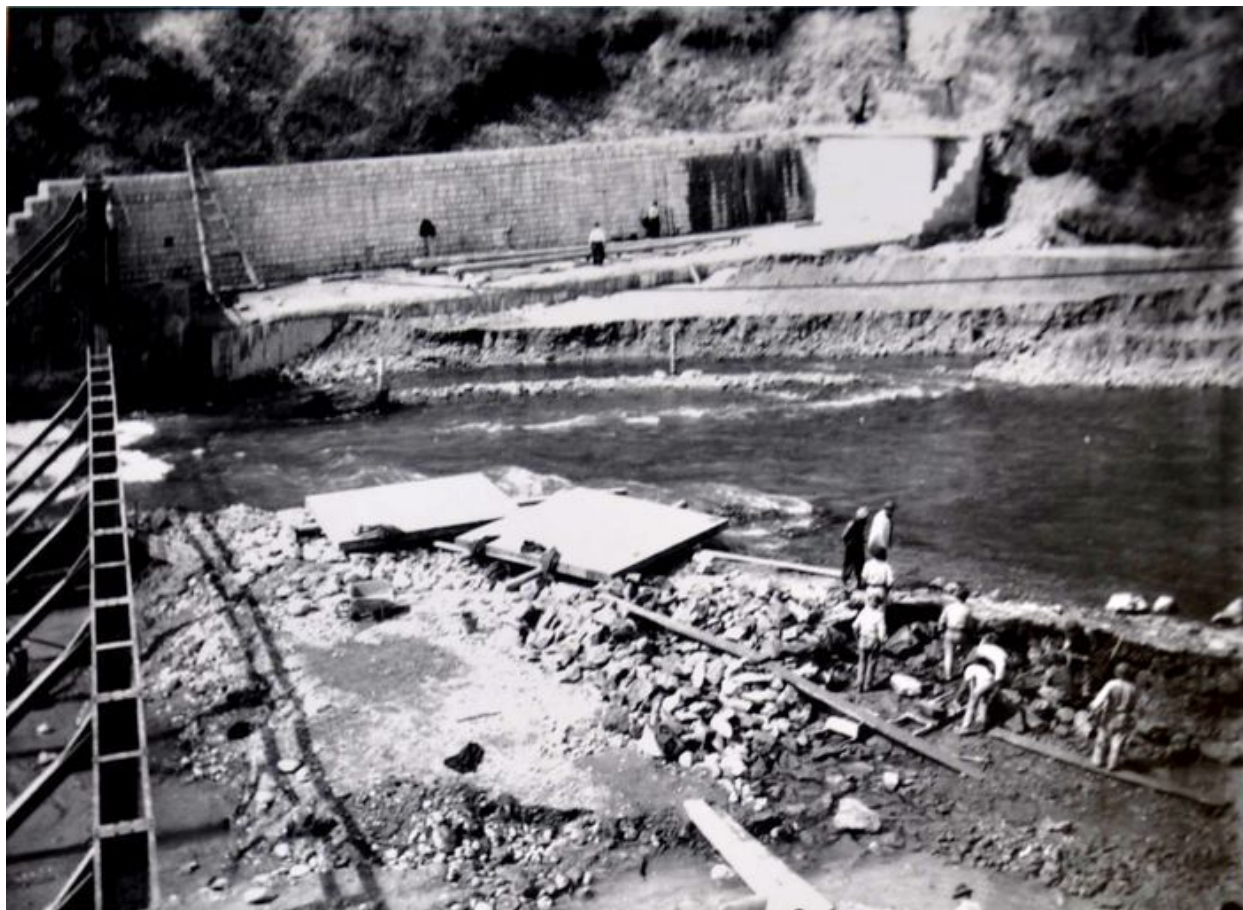
Construction du barrage de la centrale hydroélectrique de Brassilly. Dérivation du Fier.1904
