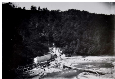
Construction du Barrage à Cran-Gevrier. 1904 Phot. Samir Mahfoudi, Autr. Association Cran au File de l'Eau IVR82_20107400298NUCA
