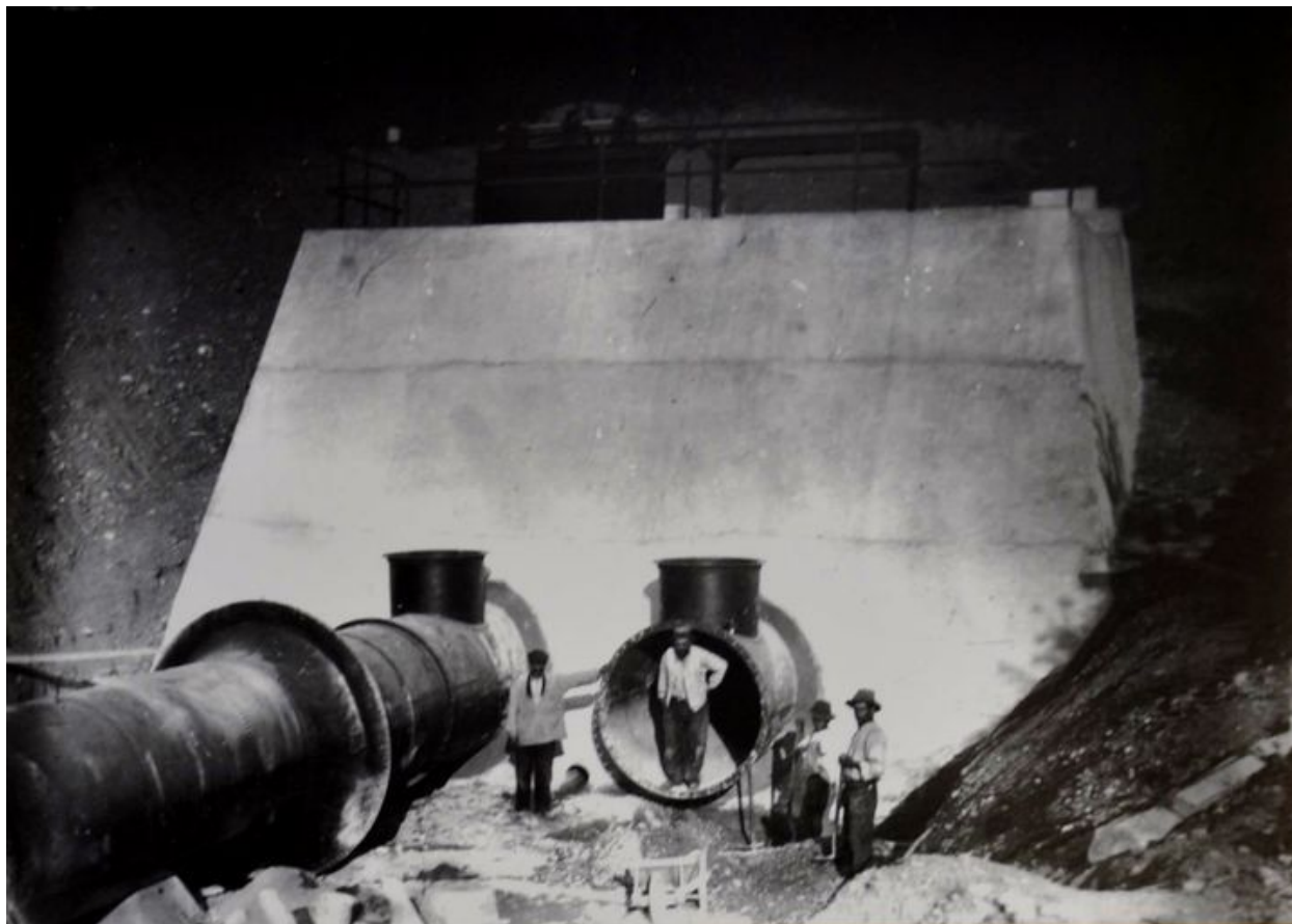
Salle de mise en charge et conduites forcées.1904
