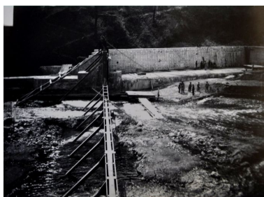
Autre vue de l'armature métallique du seuil. 1904 Phot. Samir Mahfoudi, Autr. Association Cran au File de l'Eau IVR82_20107400302NUCA
