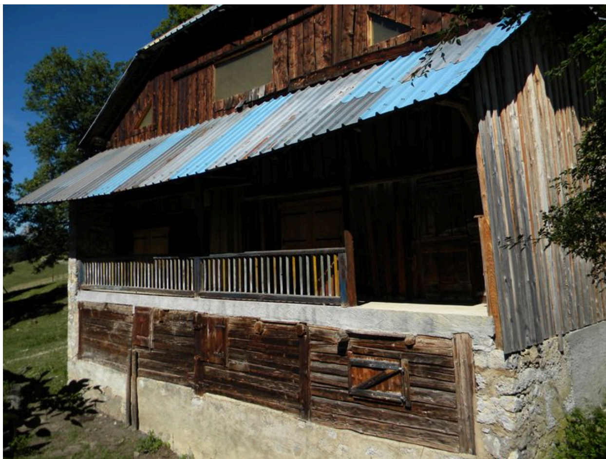
Vue de la principale ferme de l'écart.
