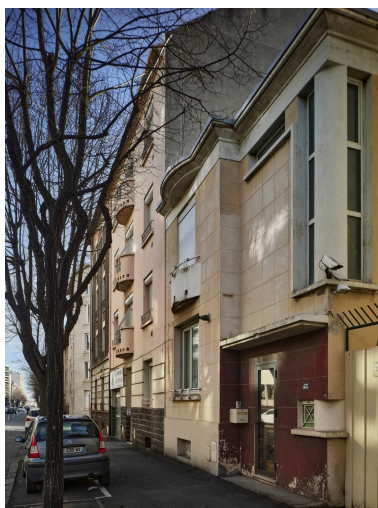
Elévation sur le boulevard Cote-Blatin Phot. Christian Parisey IVR84_20236300309NUCA4A
