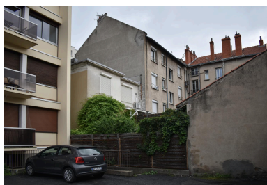
Façades postérieures Phot. Félicie Fougère IVR84_20246301643NUCA
