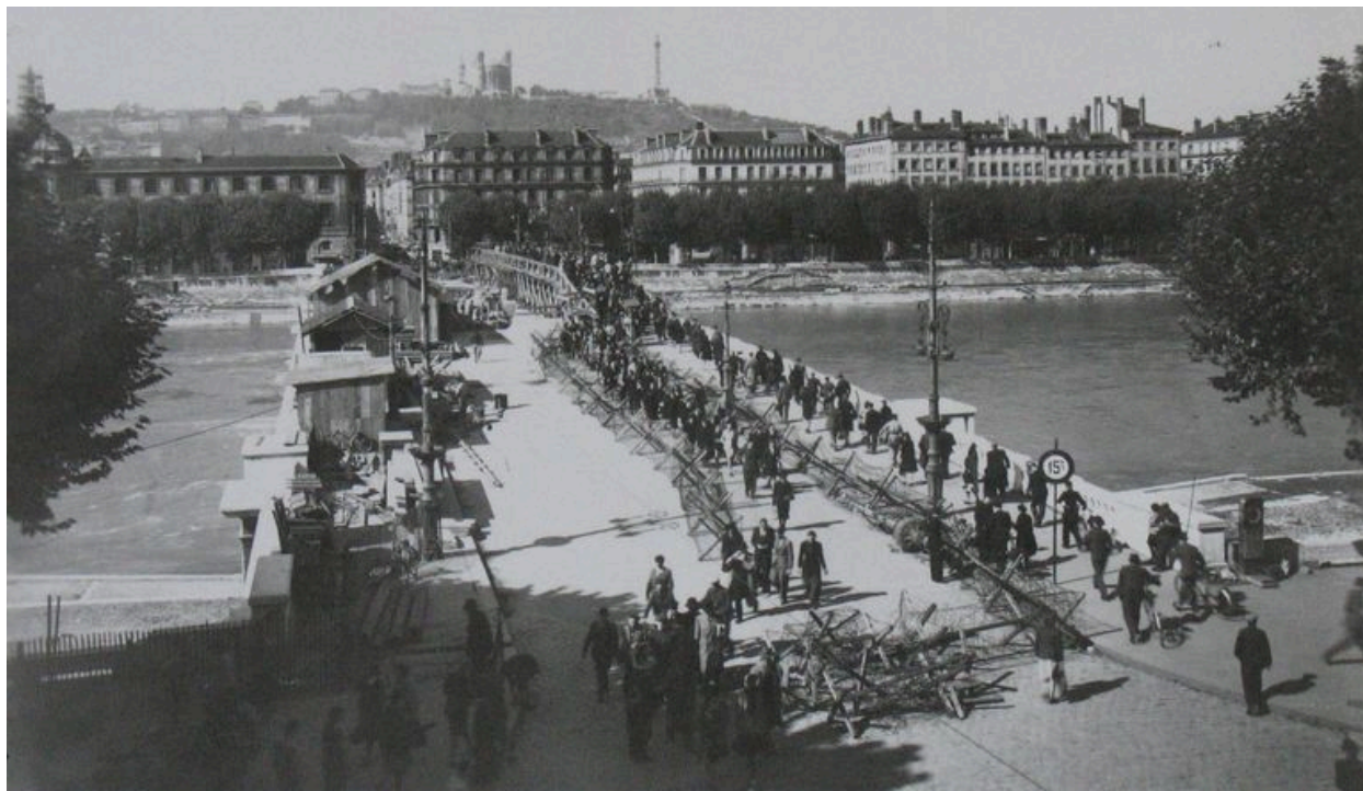
[Pont Wilson : passage de piétons sur une passerelle provisoire construite à la suite du bombardement de septembre 1944] / E. Poix ou Edmond Pernet phot., [1944]. 1 fotogr. pos. : n. et b. ; 13 x 18 cm (AM Lyon. 8 Ph 04638)
