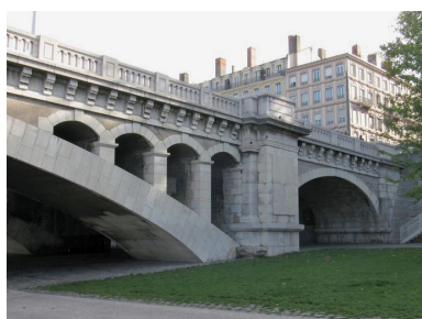
Vue partielle, de côté, travée de rive et moitié de l'arche gauche, face aval (depuis la rive gauche) Phot. I. Havard IVR82_20106907236NUCA
