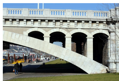
Arche gauche, face aval, vue partielle : ancrage dans le sol et quai (depuis la rive gauche) Phot. G. Gellert IVR82_20106907425NUCA
