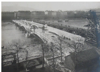
[Construction du Pont de l'Hôtel-Dieu sur le Rhône] / F. Pacalet, Ch. Volatier, Rapidphoto phot., [ca 1918]. 1 fotogr. : n. et b. (AM Lyon. 2 Ph 00283, n°23). La passerelle provisoire et le pont Wilson Phot. F. Bardoneschi, Autr. Pacalet (photographe), Autr. Volatier (photographe) IVR82_20106902778NUCAB
