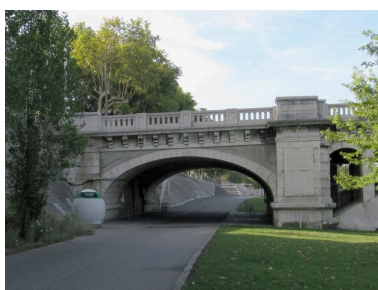
Travée de rive gauche, face amont, vue générale (depuis la rive gauche) Phot. I. Havard IVR82_20106907237NUCA
