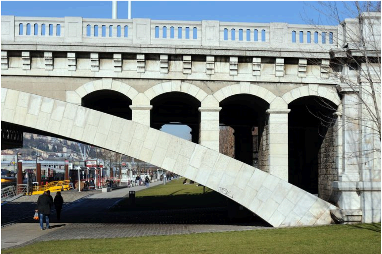
Arche gauche, face aval, vue partielle : ancrage dans le sol et quai (depuis la rive gauche)
