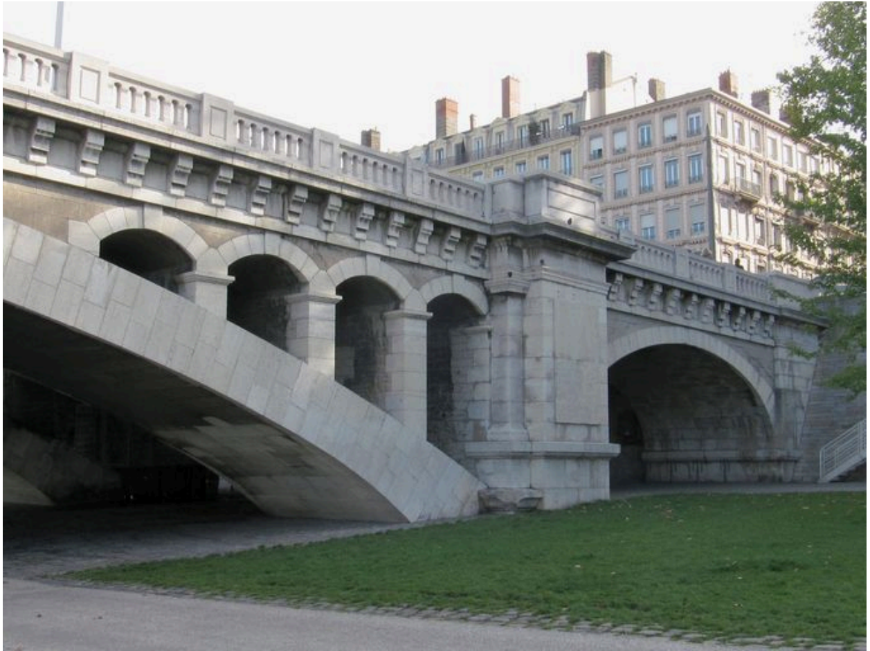
Vue partielle, de côté, travée de rive et moitié de l'arche gauche, face aval (depuis la rive gauche)
