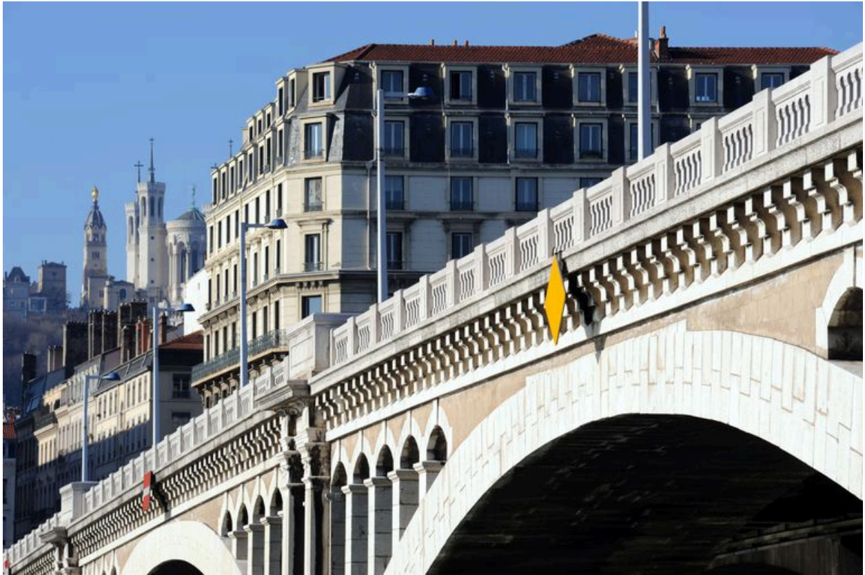
Tablier et parapet, de côté, face aval, vue partielle : décors en partie haute (depuis la rive gauche)
