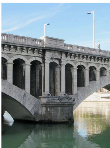
Pile, face amont, vue générale (depuis la rive gauche) Phot. I. Havard IVR82_20106907234NUCA
