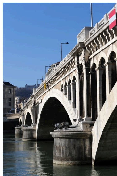
Vue partielle, de côté, face aval (depuis la rive gauche) Phot. G. Gellert IVR82_20106907233NUCA
