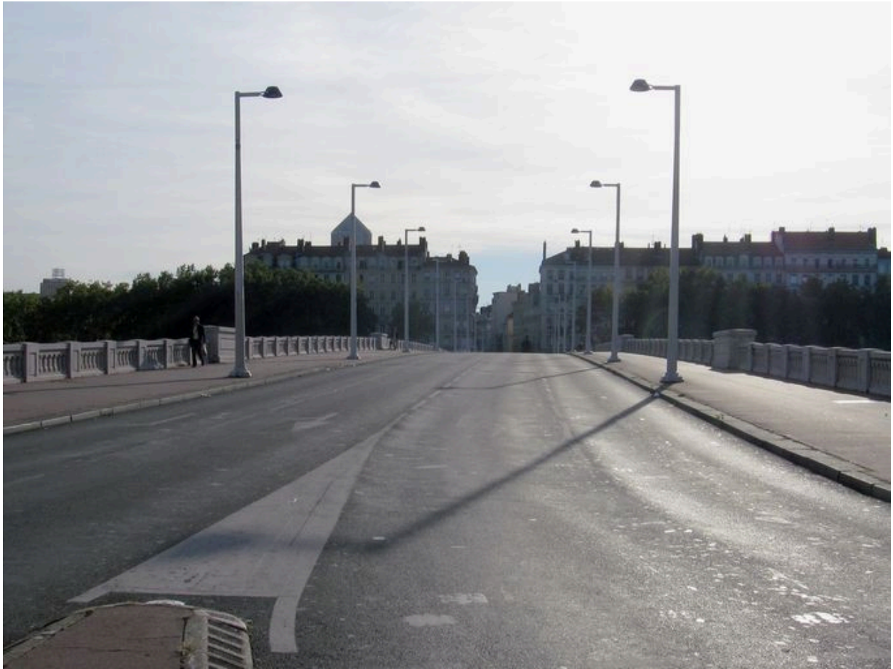
Vue générale, de dessus (depuis la rive droite)
