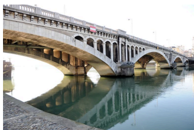
Vue générale, de côté, face amont (depuis la rive gauche) Phot. G. Gellert IVR82_20106907231NUCA
