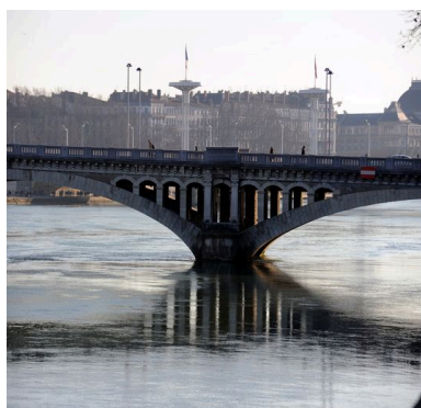
Vue partielle, pile, face amont (depuis la rive droite) Phot. G. Gellert IVR82_20106907424NUCA
