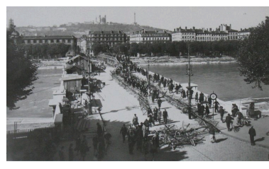
[Pont Wilson : passage de piétons sur une passerelle provisoire construite à la suite du bombardement de septembre 1944] / E. Poix ou Edmond Pernet phot., [1944]. 1 fotogr. pos. : n. et b. ; 13 x 18 cm (AM Lyon. 8 Ph 04638) Phot. F. Bardoneschi, Autr. E. (? Poix, Autr. Edmond (? Pernet) IVR82_20106902784NUCAB
