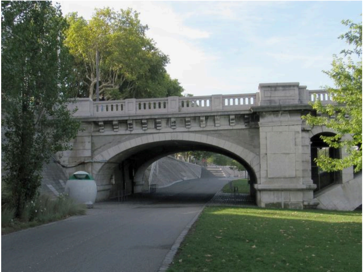
Travée de rive gauche, face amont, vue générale (depuis la rive gauche)
