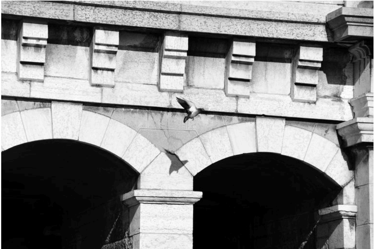
Tablier, face aval, vue de détail : décors en partie haute (depuis la rive gauche)
