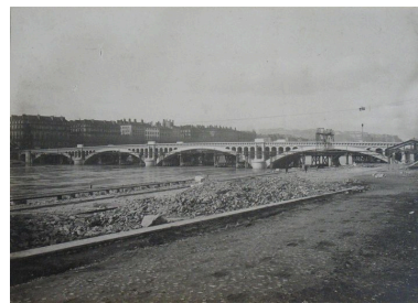
[Construction du Pont de l'Hôtel-Dieu sur le Rhône] / F. Pacalet, Ch. Volatier, Rapidphoto phot., [ca 1918]. 1 fotogr. : n. et b. (AM Lyon. 2 Ph 00283, n°24). La passerelle provisoire et le pont Wilson Phot. F. Bardoneschi, Autr. Pacalet (photographe), Autr. Volatier (photographe) IVR82_20106902779NUCAB
