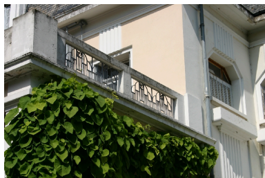
Détail de la terrasse Phot. François Fouger IVR82_20067300640NUCA
