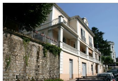
Vue de trois-quart gauche Phot. François Fouger IVR82_20067300639NUCA
