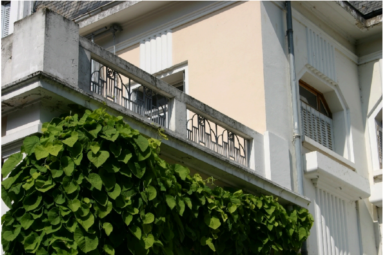
Détail de la terrasse
