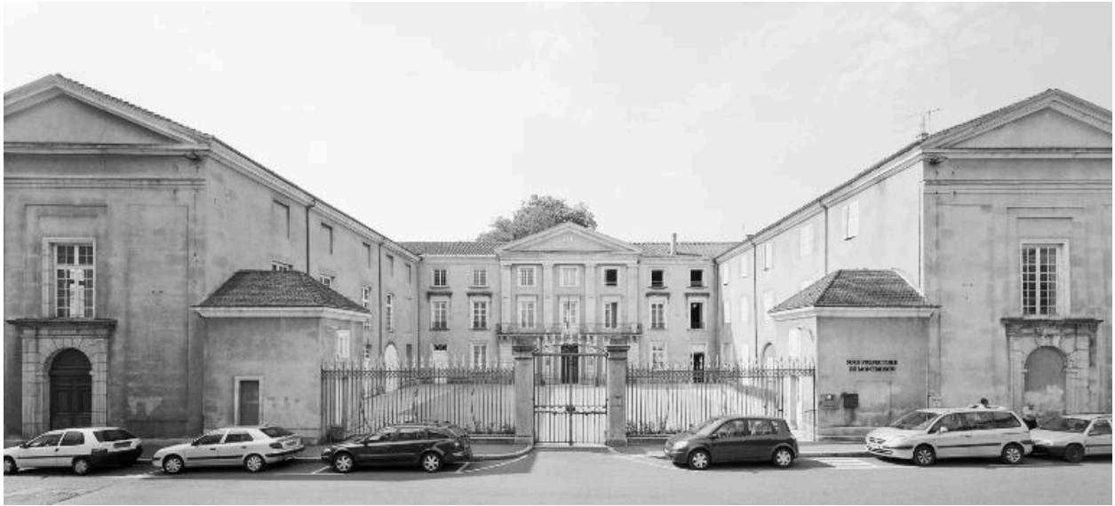
Vue de la sous-préfecture depuis le nord.
