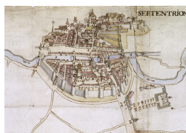
Vue cavalière de Montbrison (1732). Le second collège d'oratoriens est peut-être visible dans la partie haute de la ville. Repro. Didier Gourbin IVR82_20074200291NUCA
