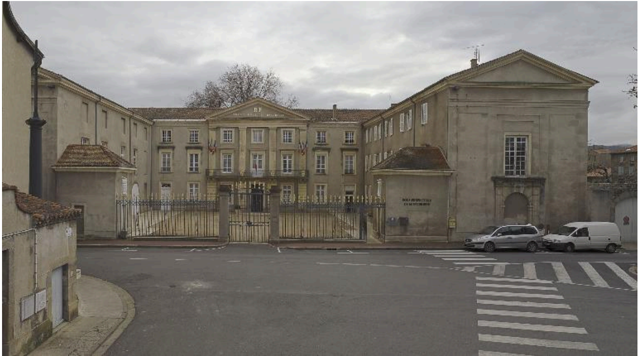
Vue partielle de la sous-préfecture côté nord.
