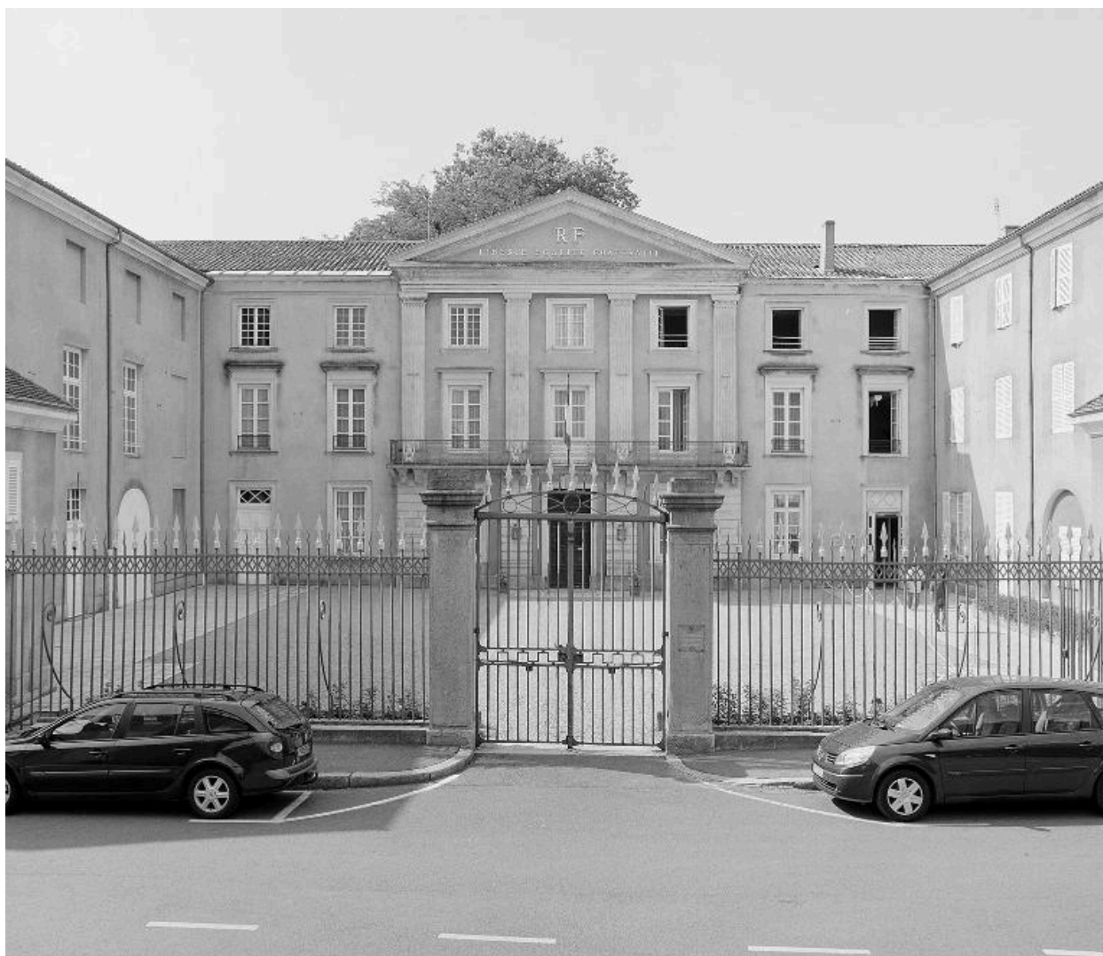
Vue de l'entrée de la sous-préfecture.
