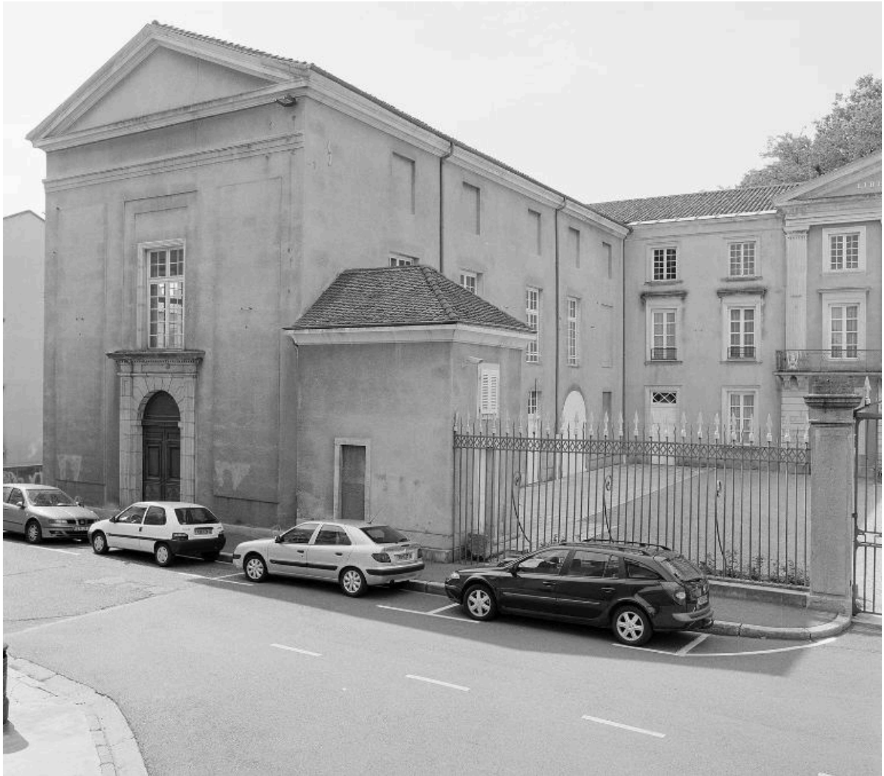
Vue du pavillon d'entrée de l'aile est depuis le nord.
