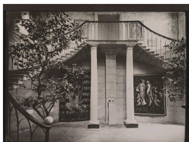
Vue de l'escalier d'accès à la salle du "conseil général" (1947). IVR82_20084200112NUCA
