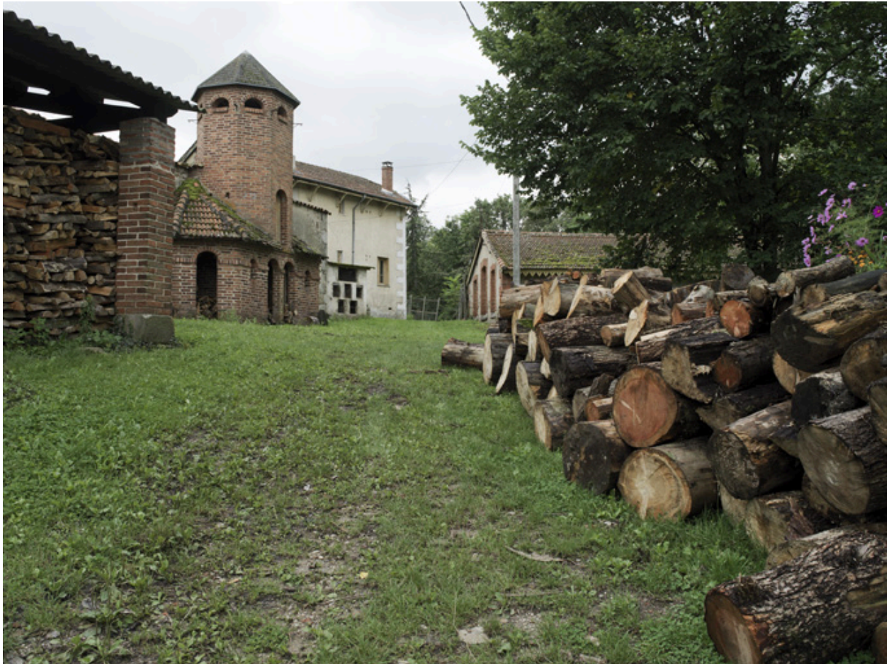
Alignement du hangar, du pigeonnier et de la maison du jardinier ; au fond à droite le cuvage.
