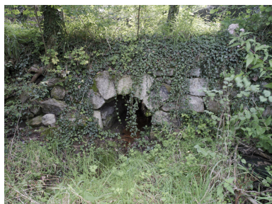
Canal d'alimentation de l'étang. Phot. Eric Dessert IVR82_20084200649NUCA
