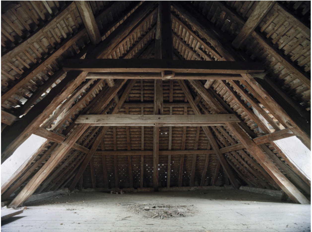
Charpente des communs
