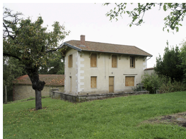
Ancienne maison du jardinier. Phot. Eric Dessert IVR82_20084200633NUCA
