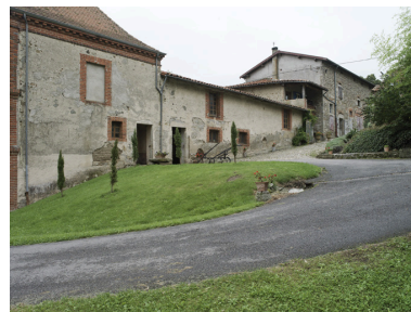
Vue partielle des communs et dépendances. Phot. Eric Dessert IVR82_20084200630NUCA
