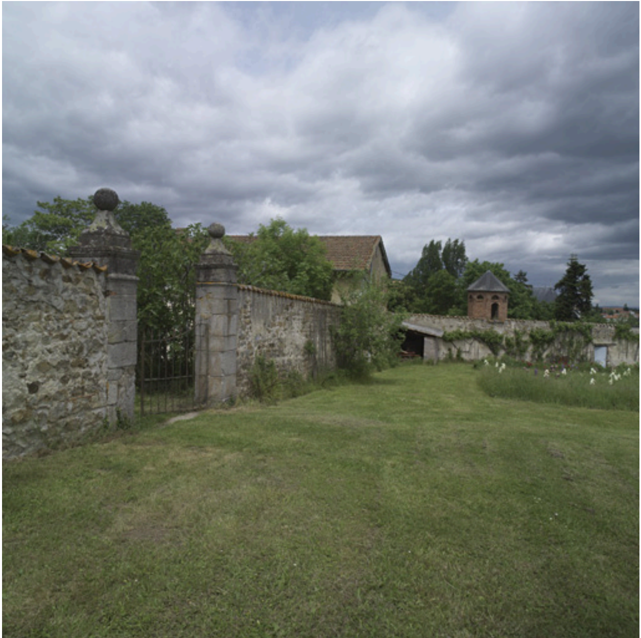
Clôture du jardin et vue partielle de la maison du jardinier, au fond le pigeonnier.
