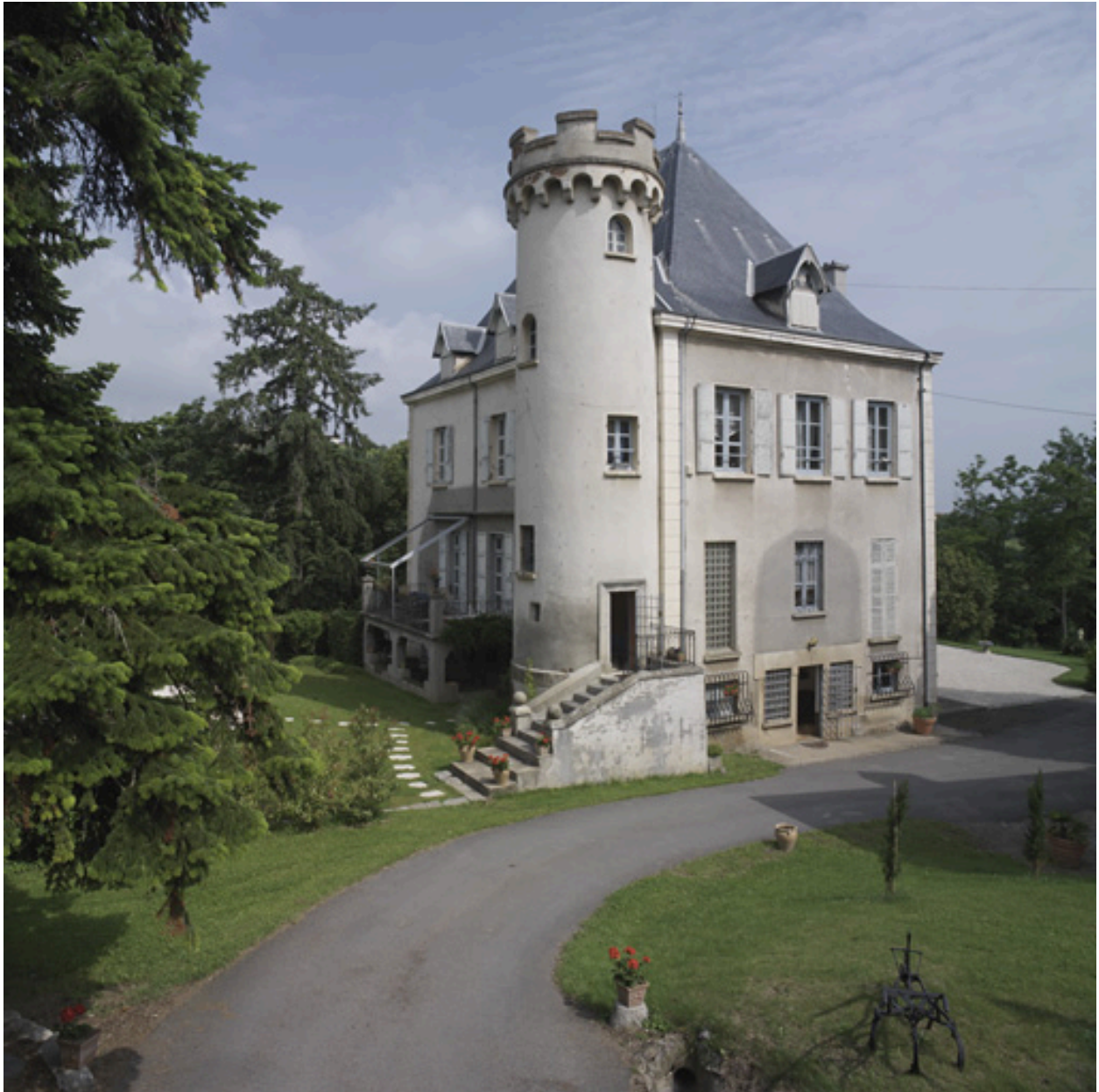
Château vu du sud-ouest.
