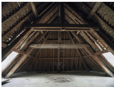
Charpente des communs Phot. Eric Dessert IVR82_20084200644NUCA
