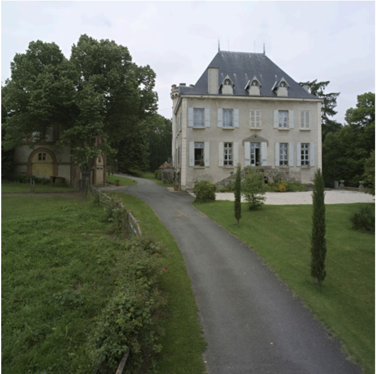
Château vu depuis l'est.
