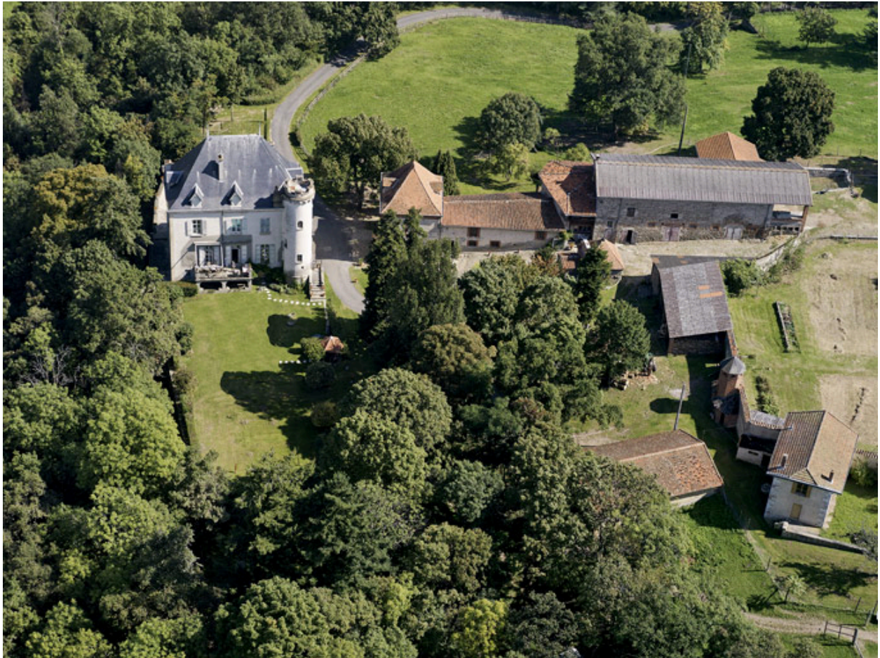
Vue générale des bâtiments.
