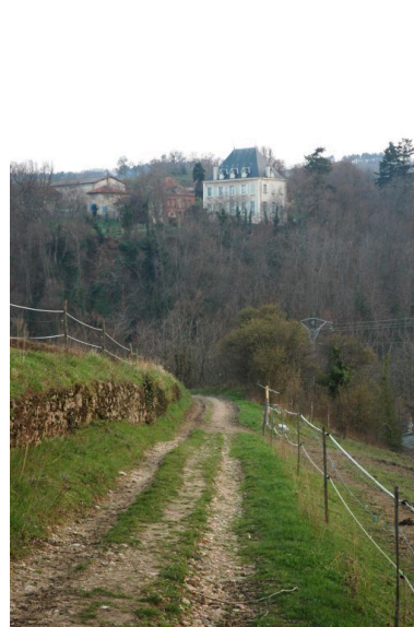
Vue de situation. Phot. Didier Gourbin IVR82_20134202028NUCA
