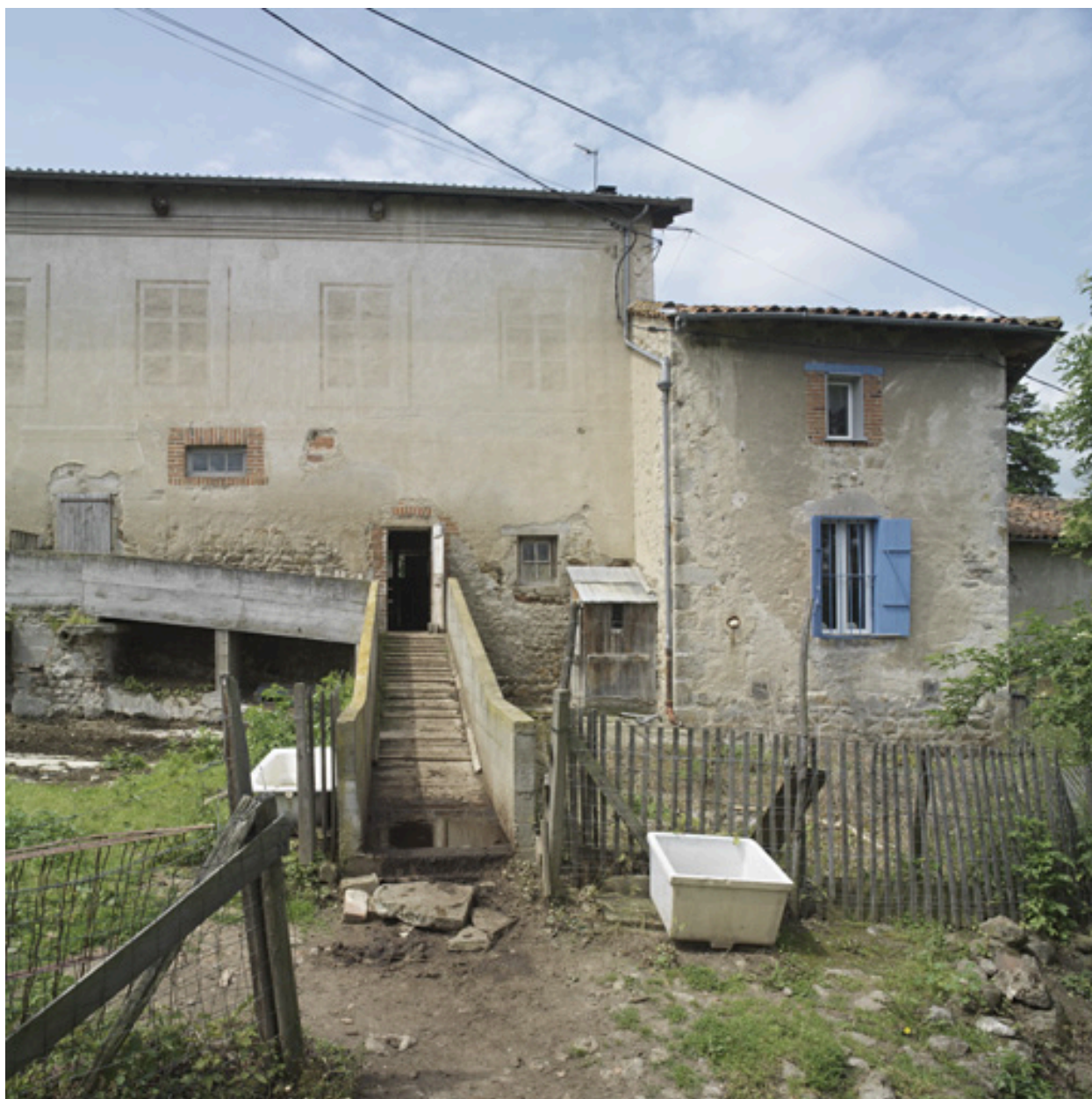
Vue depuis l'est : étable et grange à gauche, habitation du fermier à droite.
