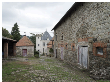
A droite, le hangar agricole et le four, à gauche l'étable et le fenil. Phot. Eric Dessert IVR82_20084200631NUCA
