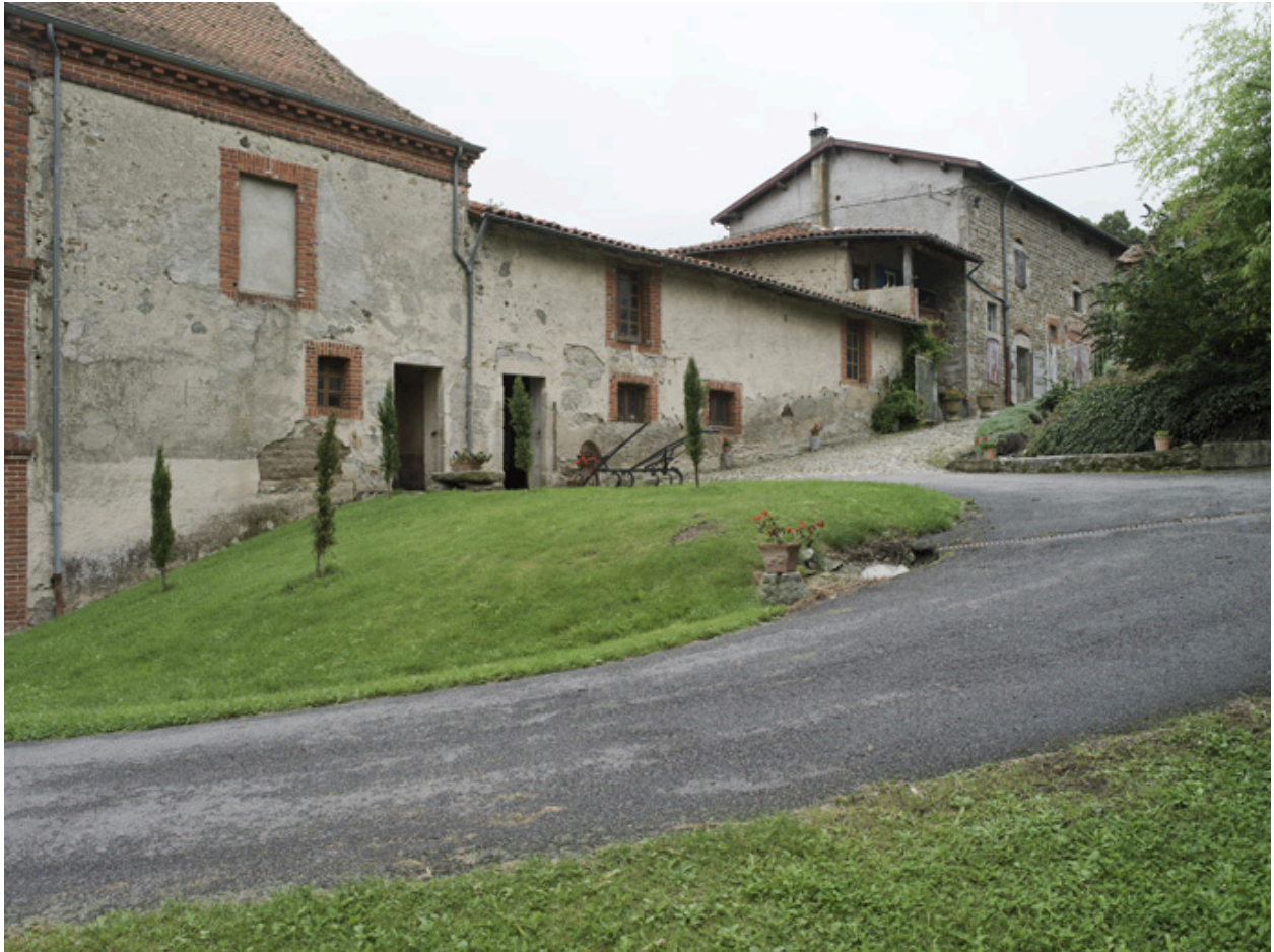
Vue partielle des communs et dépendances.
