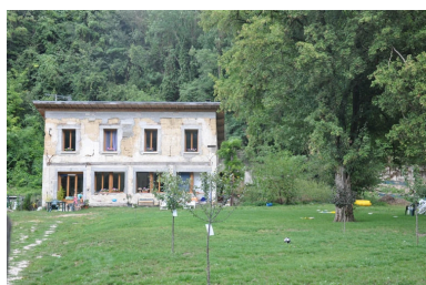
Vue générale du bâtiment de l'ancienne scierie, façade sud Phot. Yannick Milleret IVR82_20107300551NUCA
