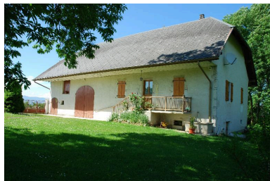
Vue d'ensemble de trois- quart avant droit de la ferme. Phot. Thierry Monnet IVR84_20167301934NUCA
