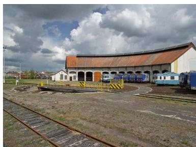
Vestiges de la rotonde ferroviaire de Montluçon. En 1880, deux demi-rotondes avaient été construites pour le nouveau dépôt de la gare de Montluçon, permettant d'abriter 38 machines qui manoeuvraient grâce à deux ponts tournants (un 3e pont tournant avait été installé
