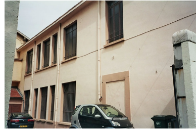
Vue nord des ateliers Phot. Nadine Halitim-Dubois IVR82_20066900380NUCA
