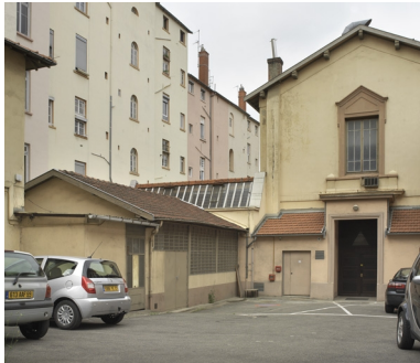
Vue d'ensemble nord-ouest Phot. Didier Gourbin IVR82_20076900851NUCA
