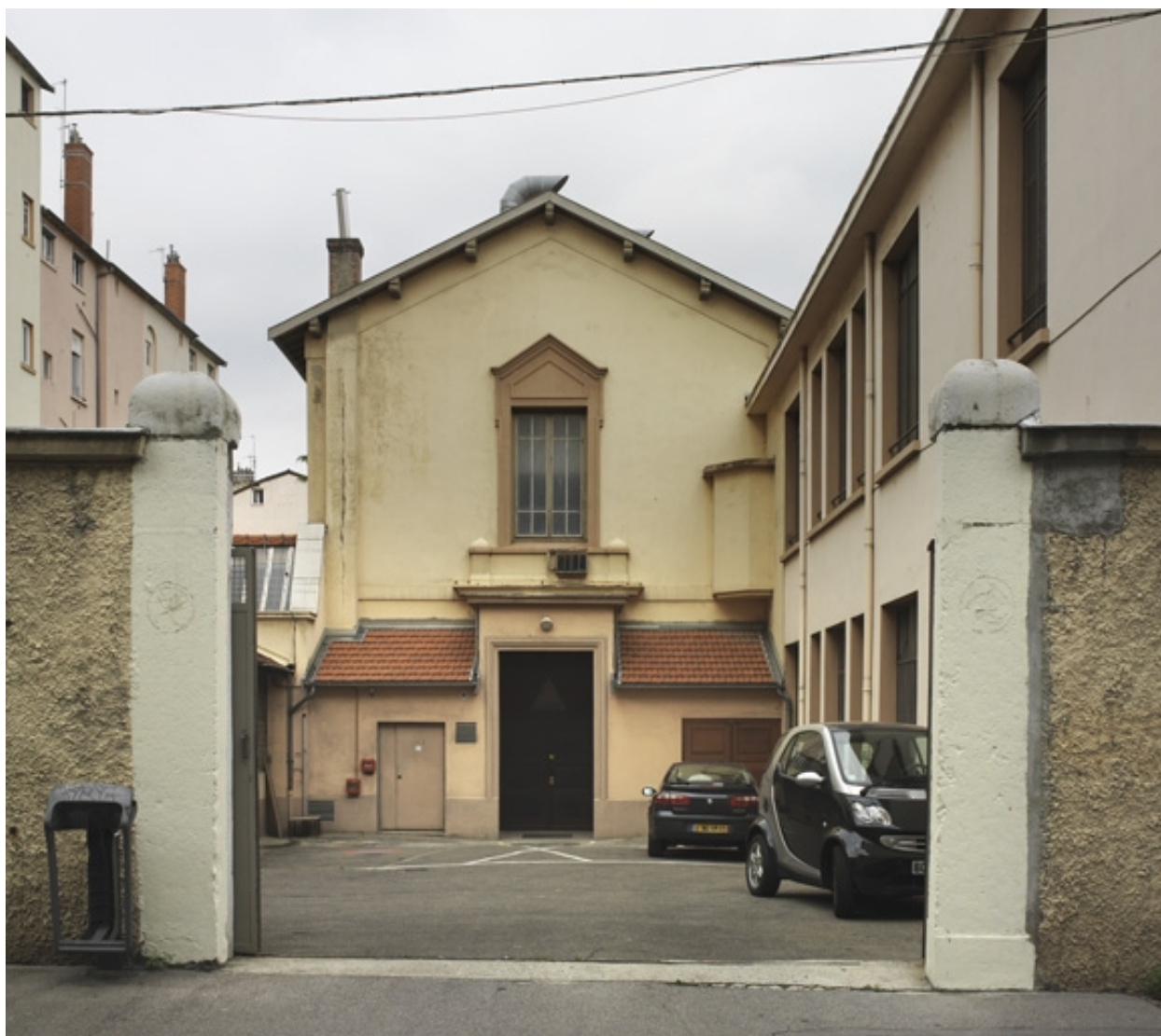
Entrée du site
